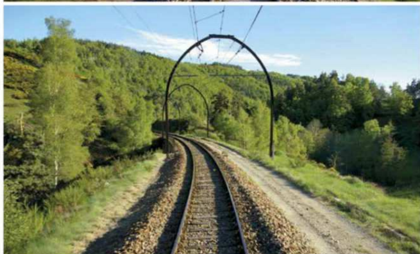
Section de ligne des Causses en ogives. La plateforme est prévue pour deux voies.
