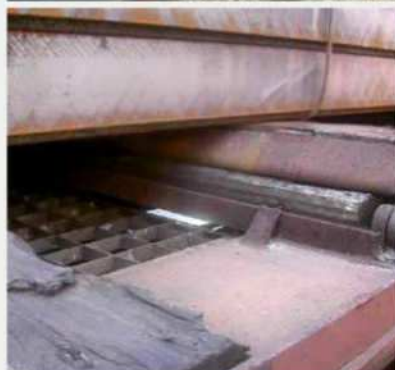
Détail d'une lambourde levée. Remarquez le chanfrein ainsi que la grille sur le châssis.
