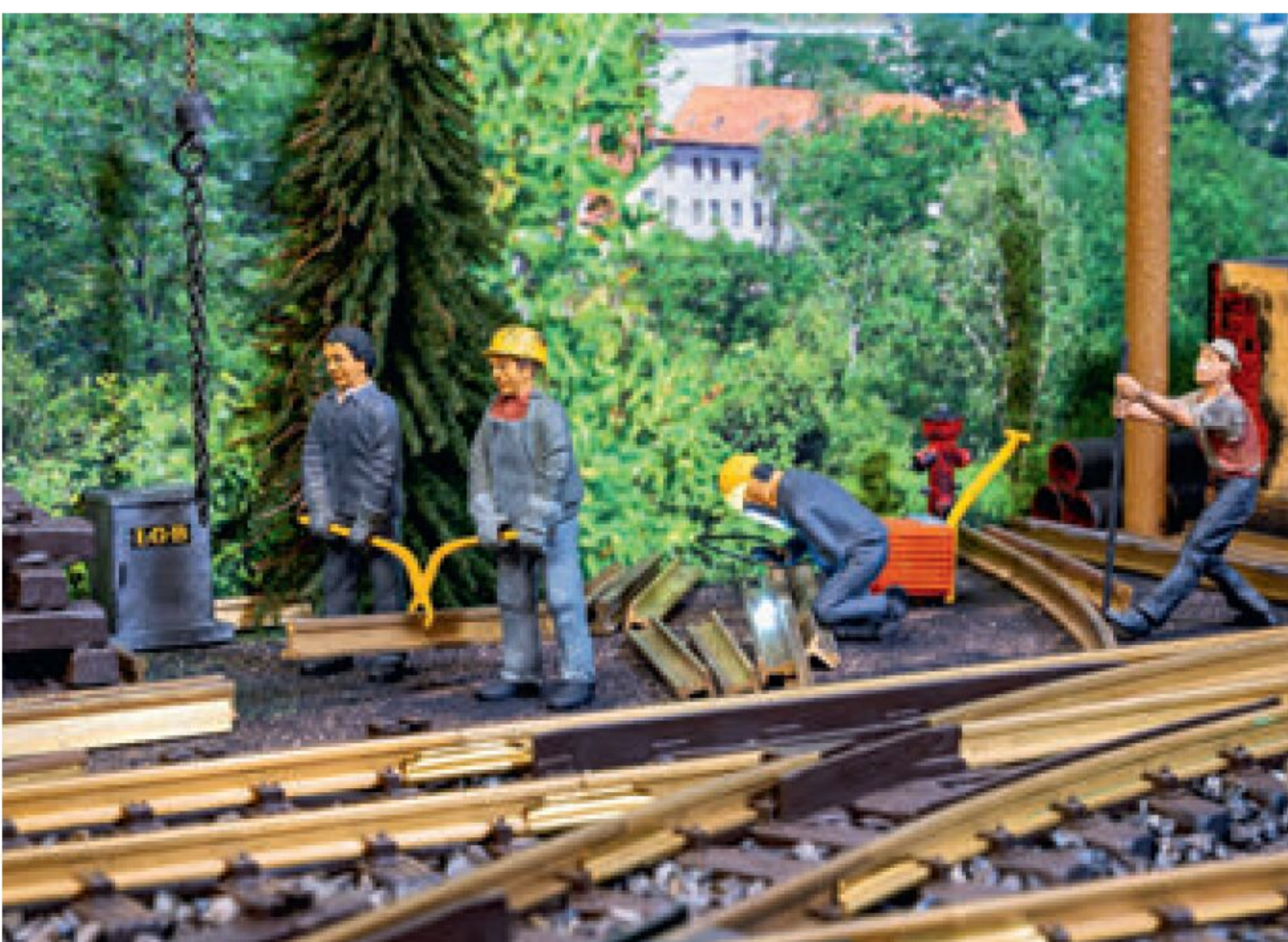
Ausbesserung: Ein Schienenstrang muss erneuert werden.
