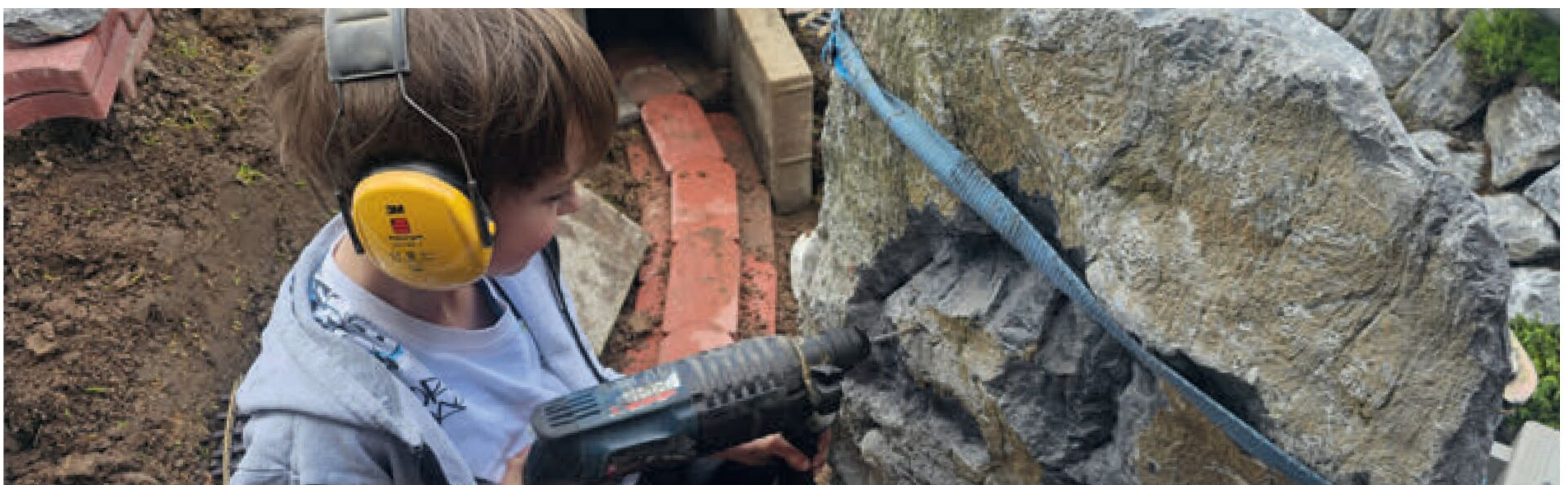
Mitarbeit: Auch der Sohn packte fleißig mit an und half, den Tunnel in den Ardenner Steinbrocken zu bohren.
