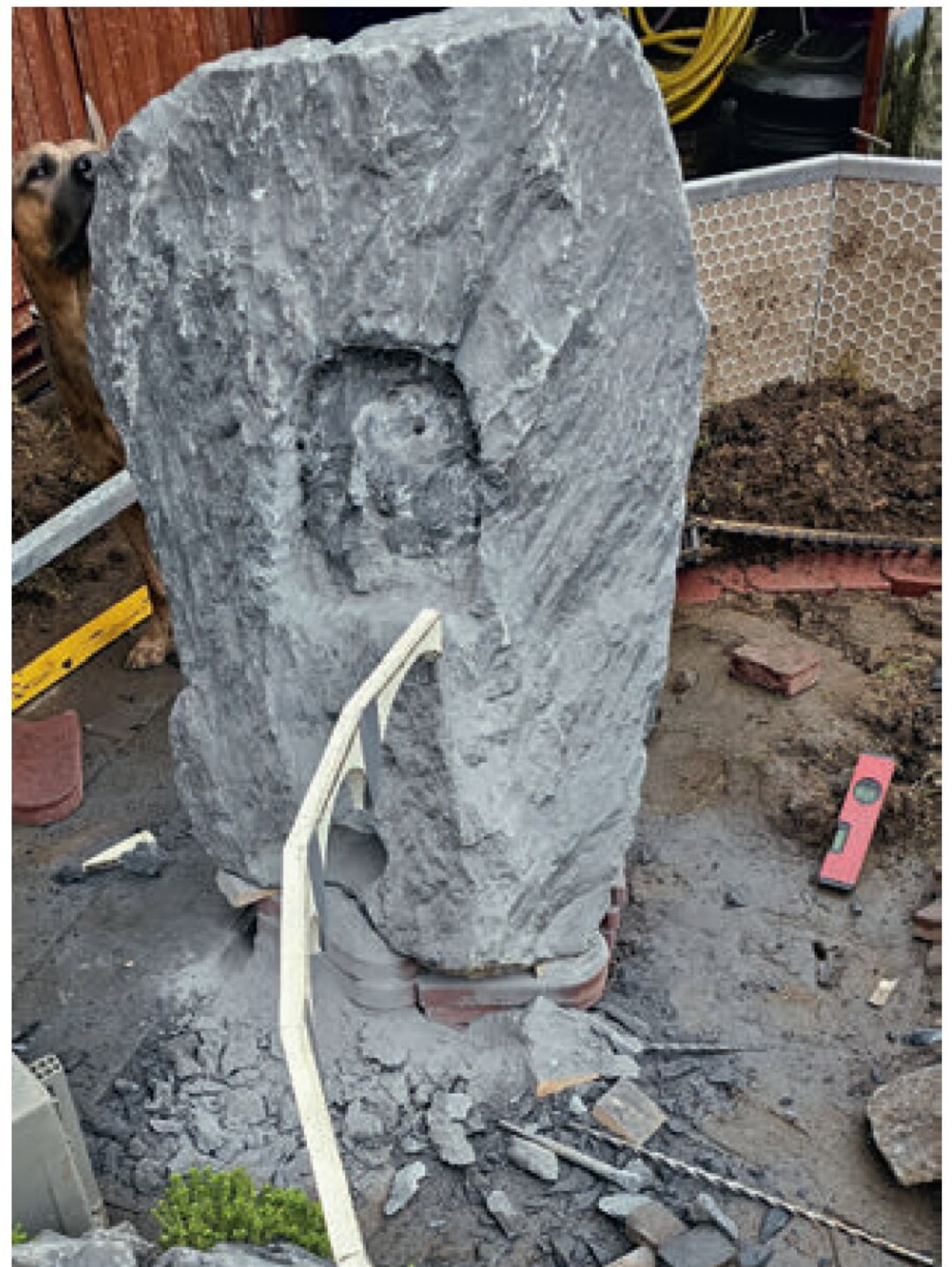
Fleißarbeit: Aufkleben der Steine, Durchbruch am Felsbrocken.
