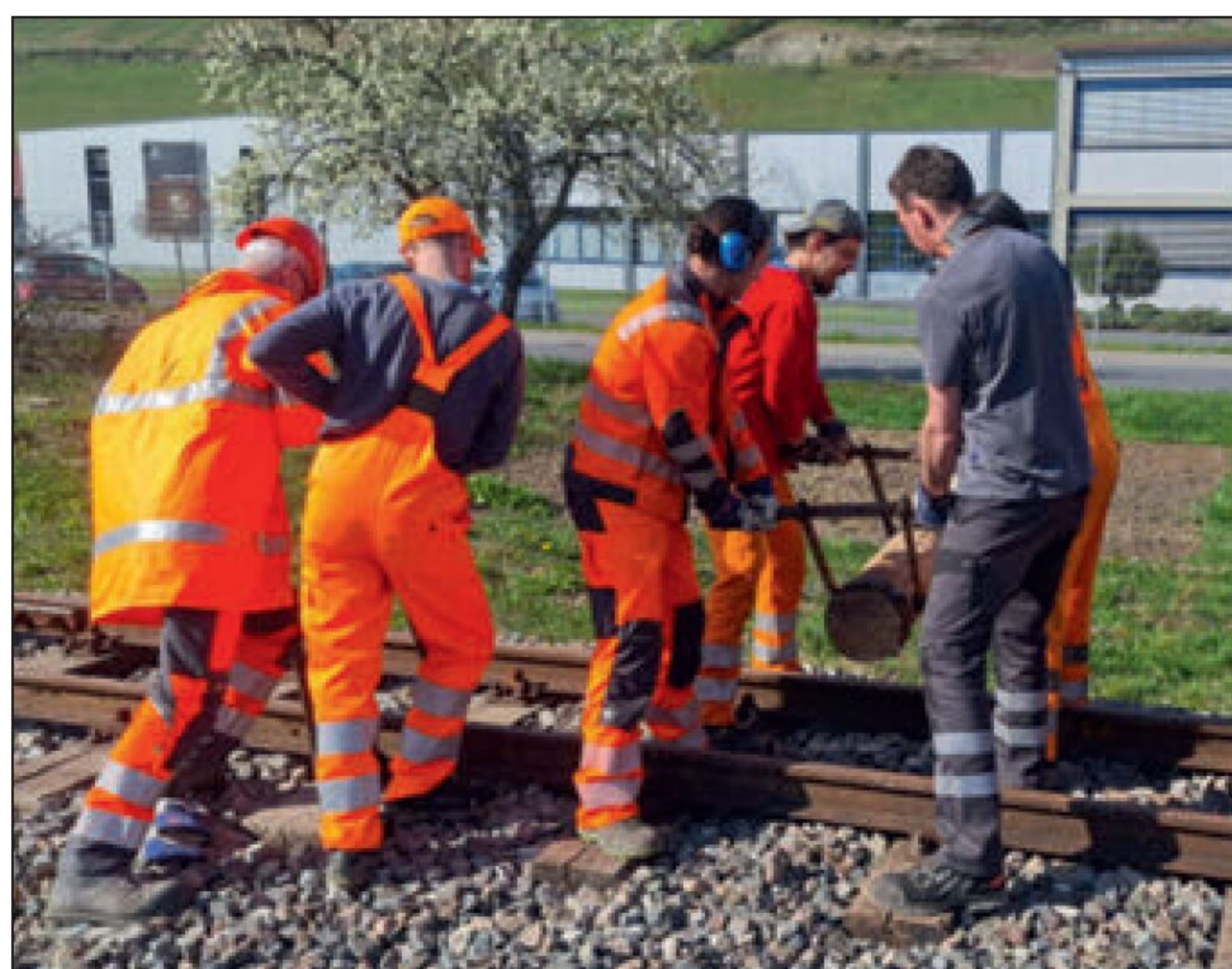
Gemeinsam: Die notwendigen Schwellen und Gleise verlegten die Vereinsmitglieder in Eigenarbeit – mit großem Erfolg.
