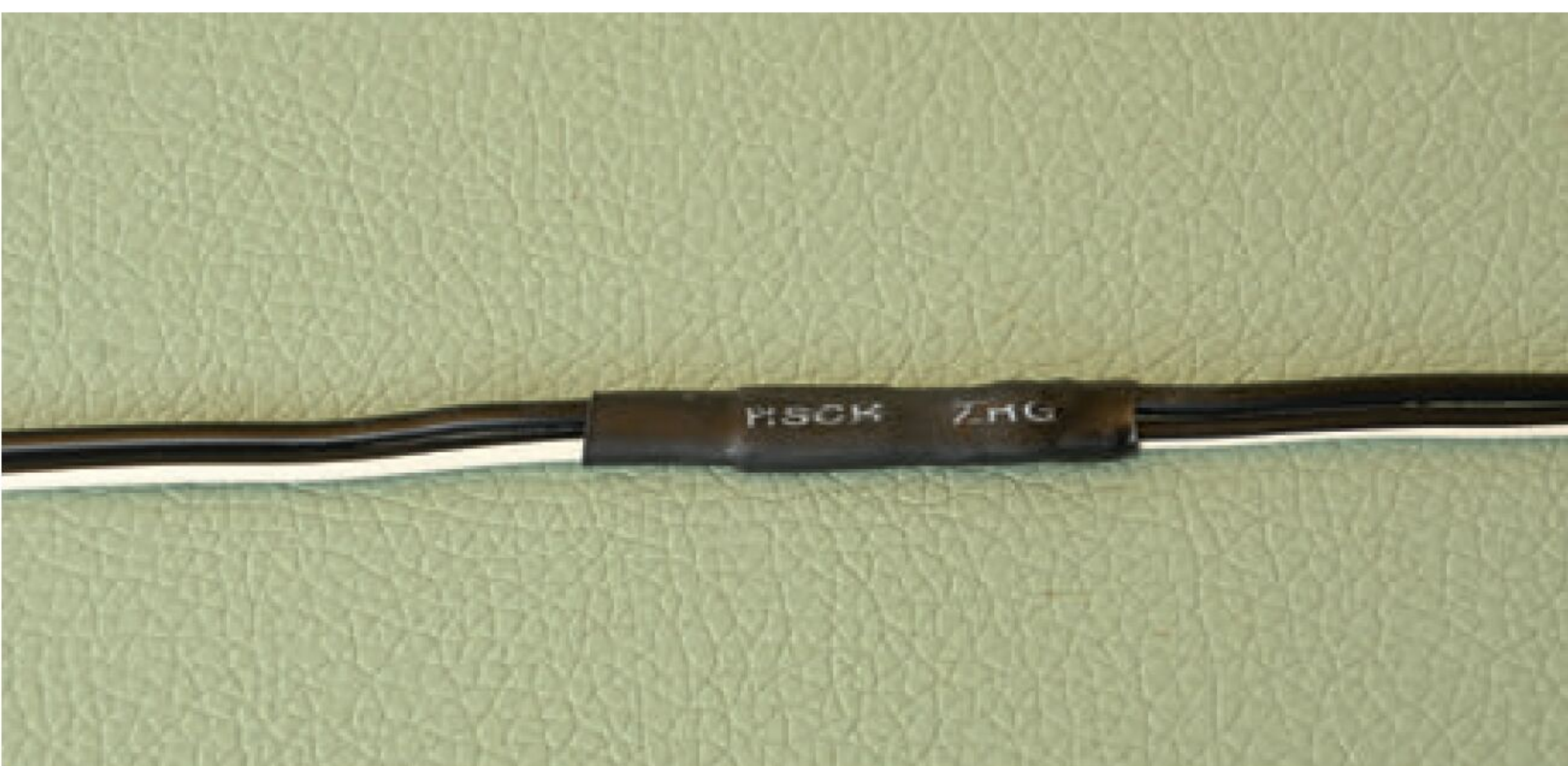
Zusätzlicher Schutz: Sind beide Kabel verlötet und mit einem Schrumpfschlauch versehen, ziehen wir über beide Adern nochmals einen separaten Schrumpfschlauch.
