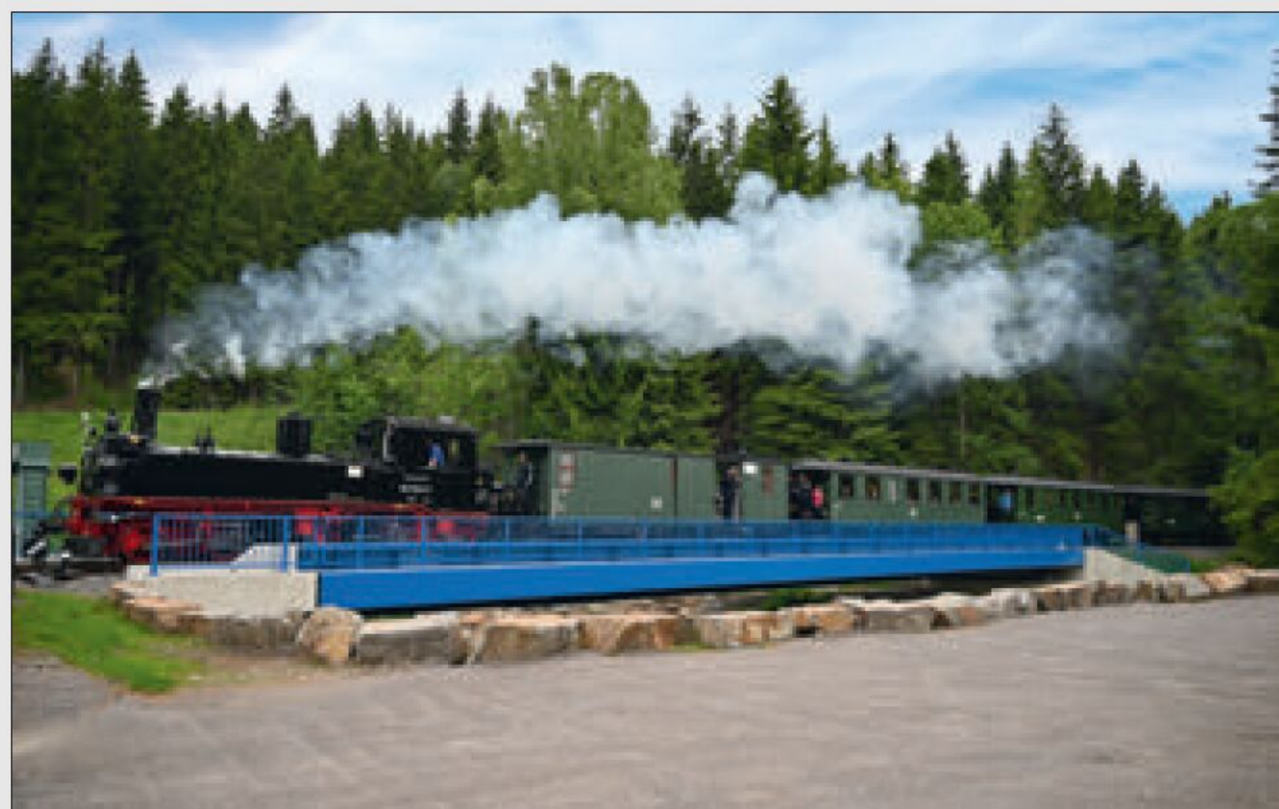
Sanierung perfekt: Die IV K 99 1594-3 quert die erneuerte Brücke über das Schwarzwasser am Bahnhof Schlössel.
