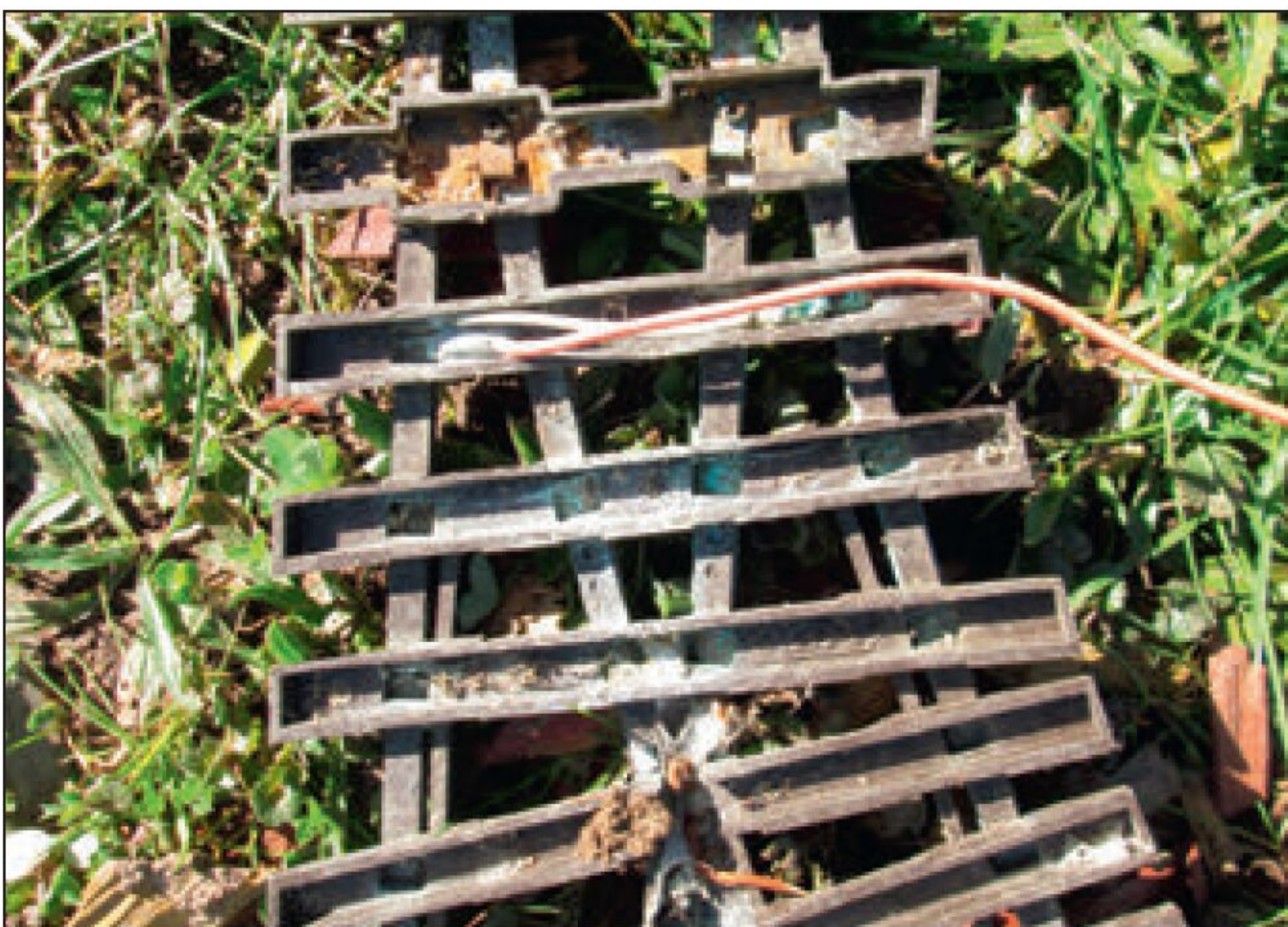
Detailarbeit II: Nach zwei Jahrzehnten lohnt die Generalsanierung einer Weiche und eine Kontrolle der elektrischen Zuleitung.
