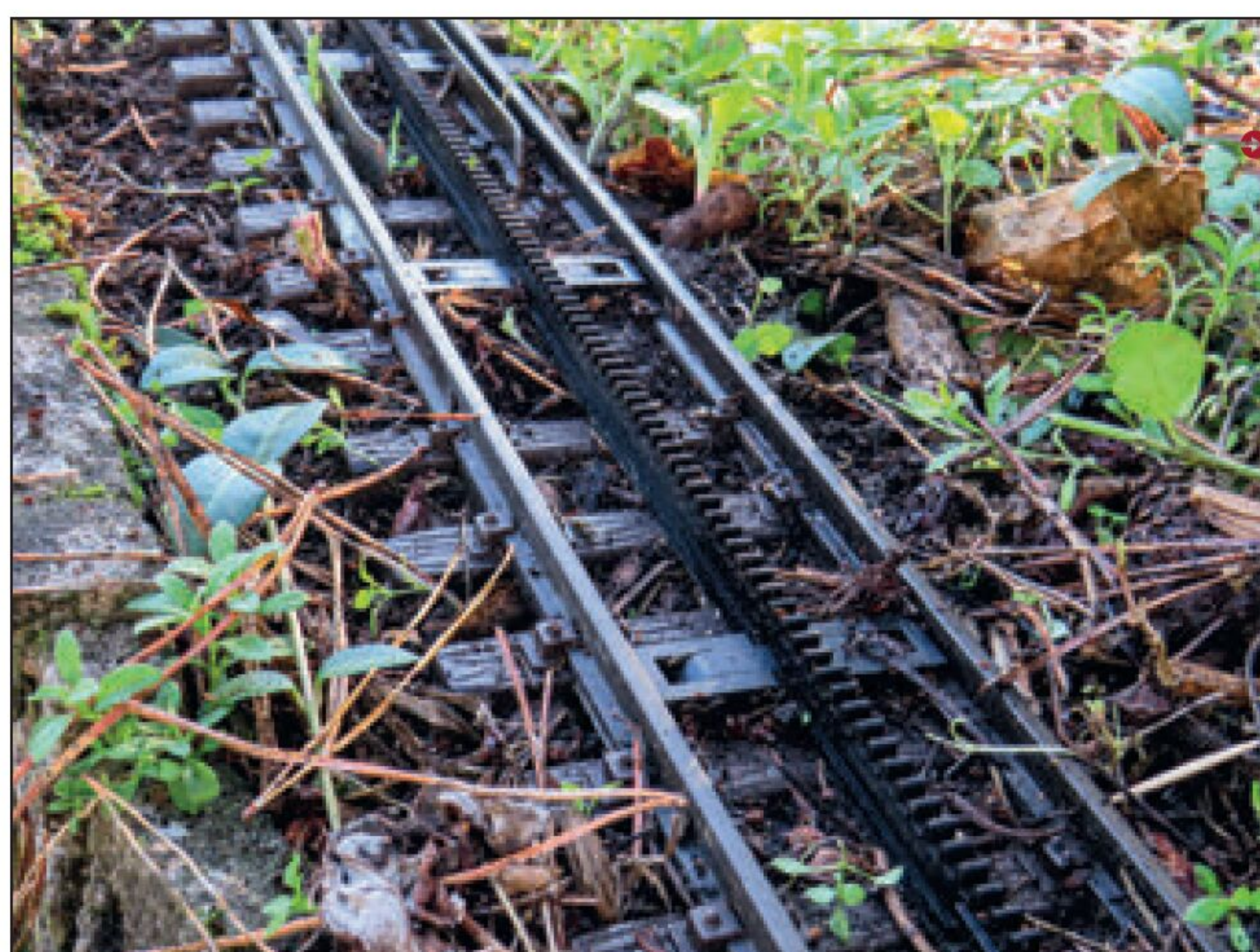
Feinarbeit: Die Gleiskörper von Kleinstzweigen befreien. Zahnstangen sind von Sand und Schmutz besonders sorgsam zu reinigen.
