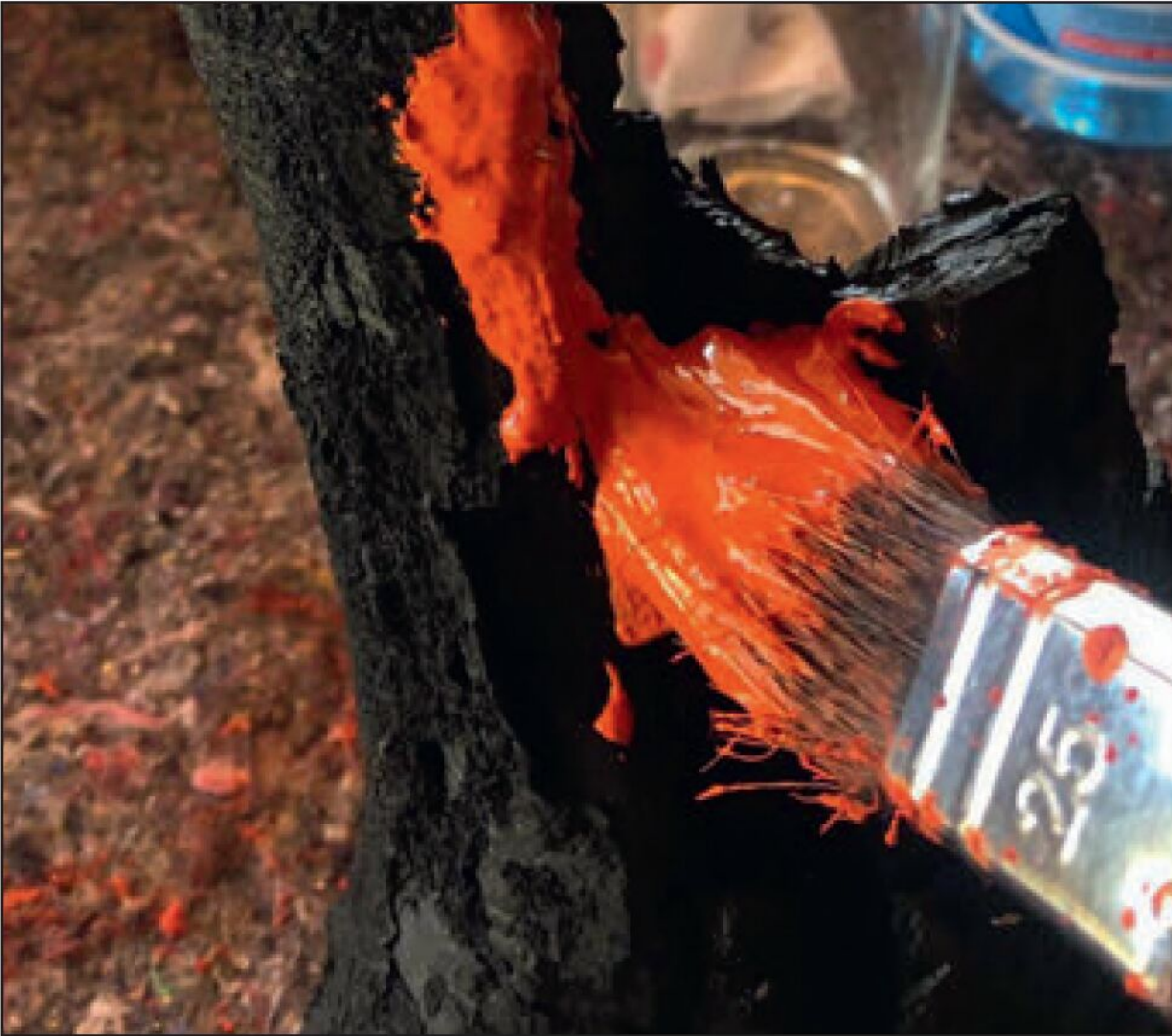
Feinarbeit: Erst eine ausgiebige Behandlung mit Tiefengrund, dann der Anstrich mit roter Acrylfarbe (vermischt mit Quarzsand).
