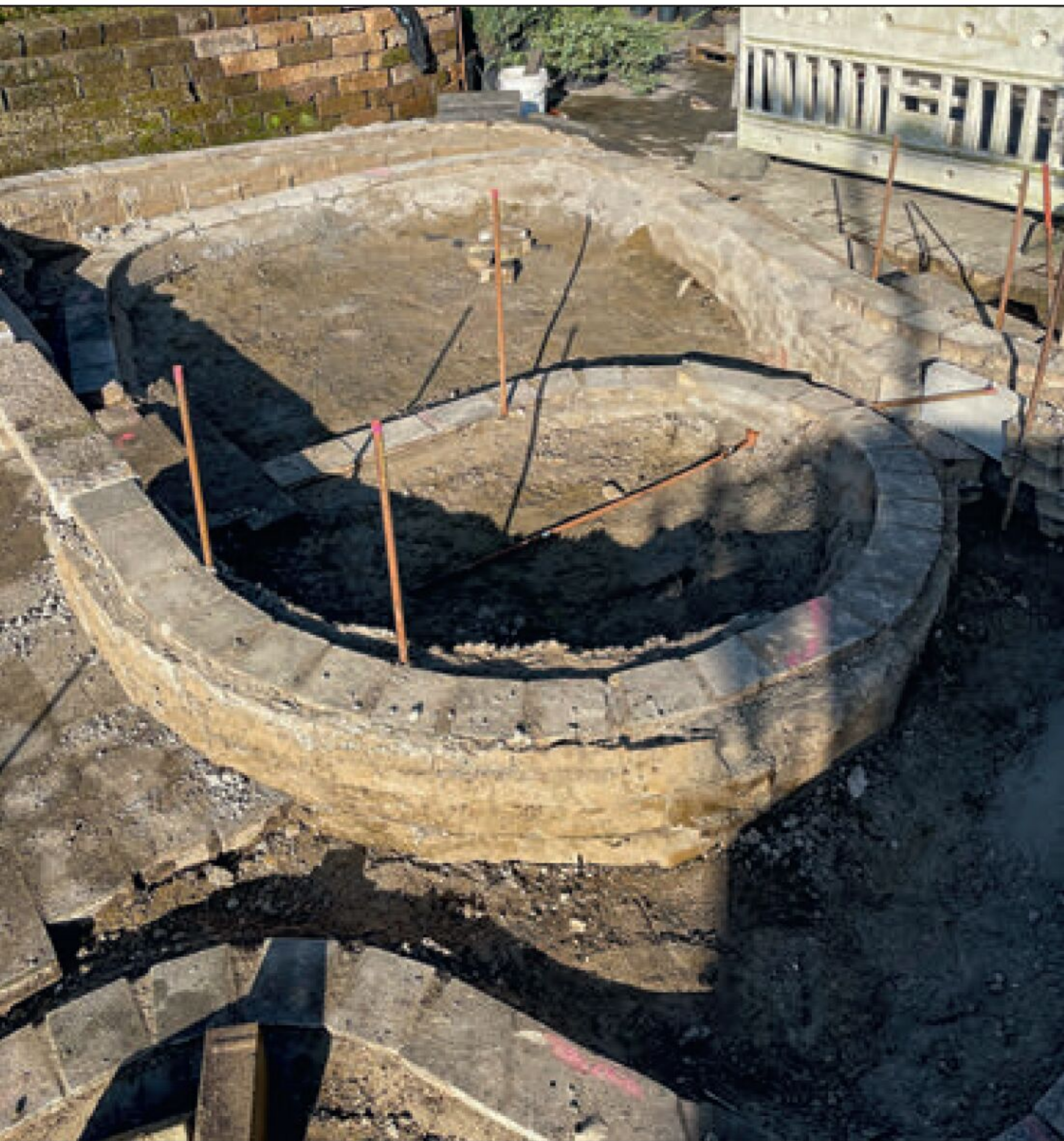
Exzellente Ausführung: Der Kehrviadukt aus Randsteinen und Magerbeton exakt nach Plan umgesetzt.
