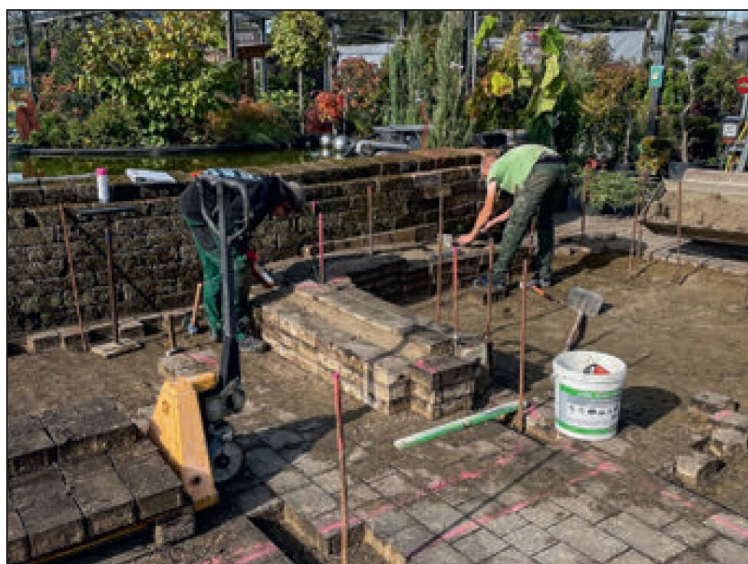
Basisarbeit: Nach der Planung ging es an den Grundaufbau. Die Trassen wurden mit Trittsteinen aufgebaut und mit Magerbeton fixiert. Den Aufbau übernahmen Max Brockmann und Malte Werner, Azubis beim Garten- und Landschaftsbau Vornbrock.
