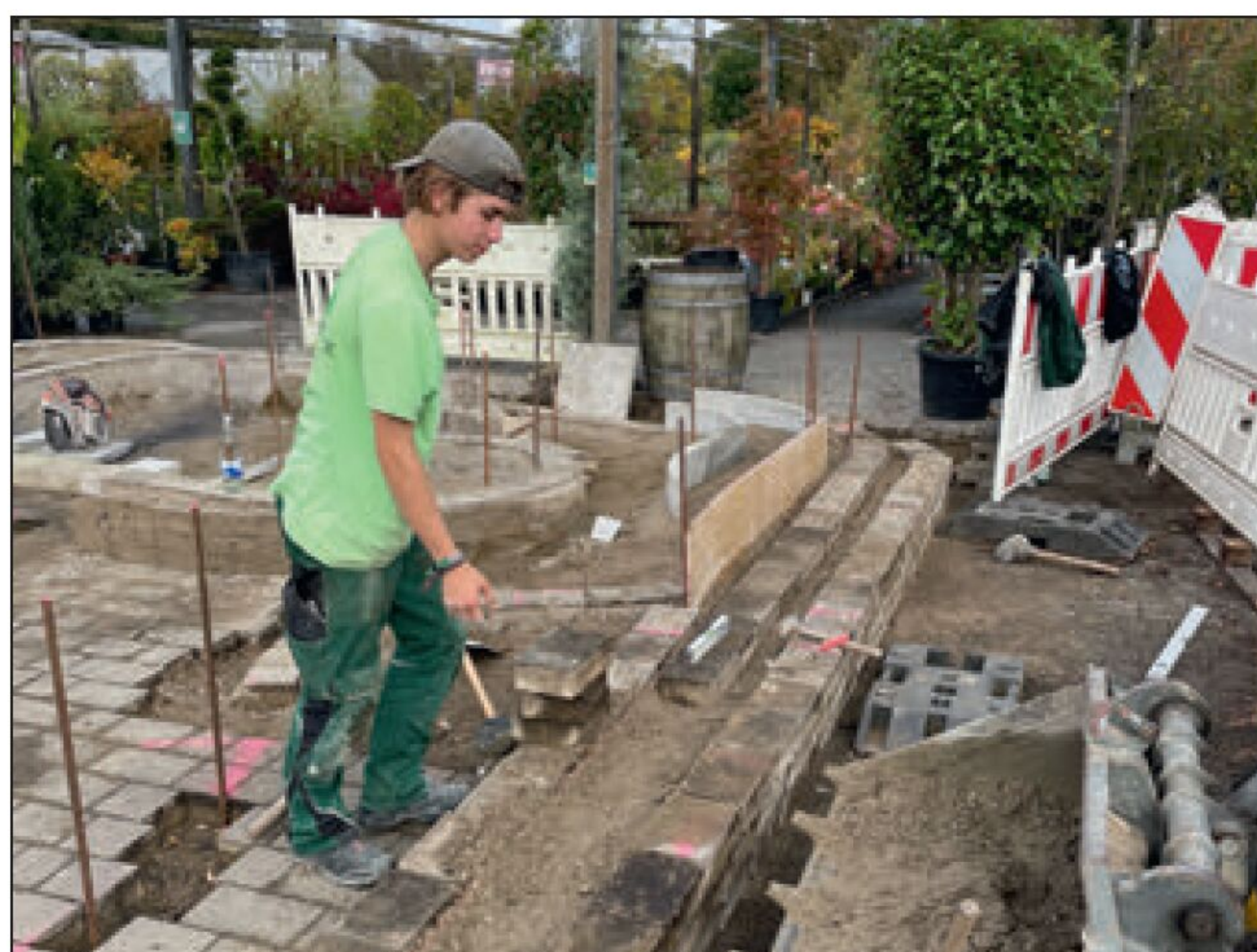
Basisarbeit: Nach der Planung ging es an den Grundaufbau. Die Trassen wurden mit Trittsteinen aufgebaut und mit Magerbeton fixiert. Den Aufbau übernahmen Max Brockmann und Malte Werner, Azubis beim Garten- und Landschaftsbau Vornbrock.
