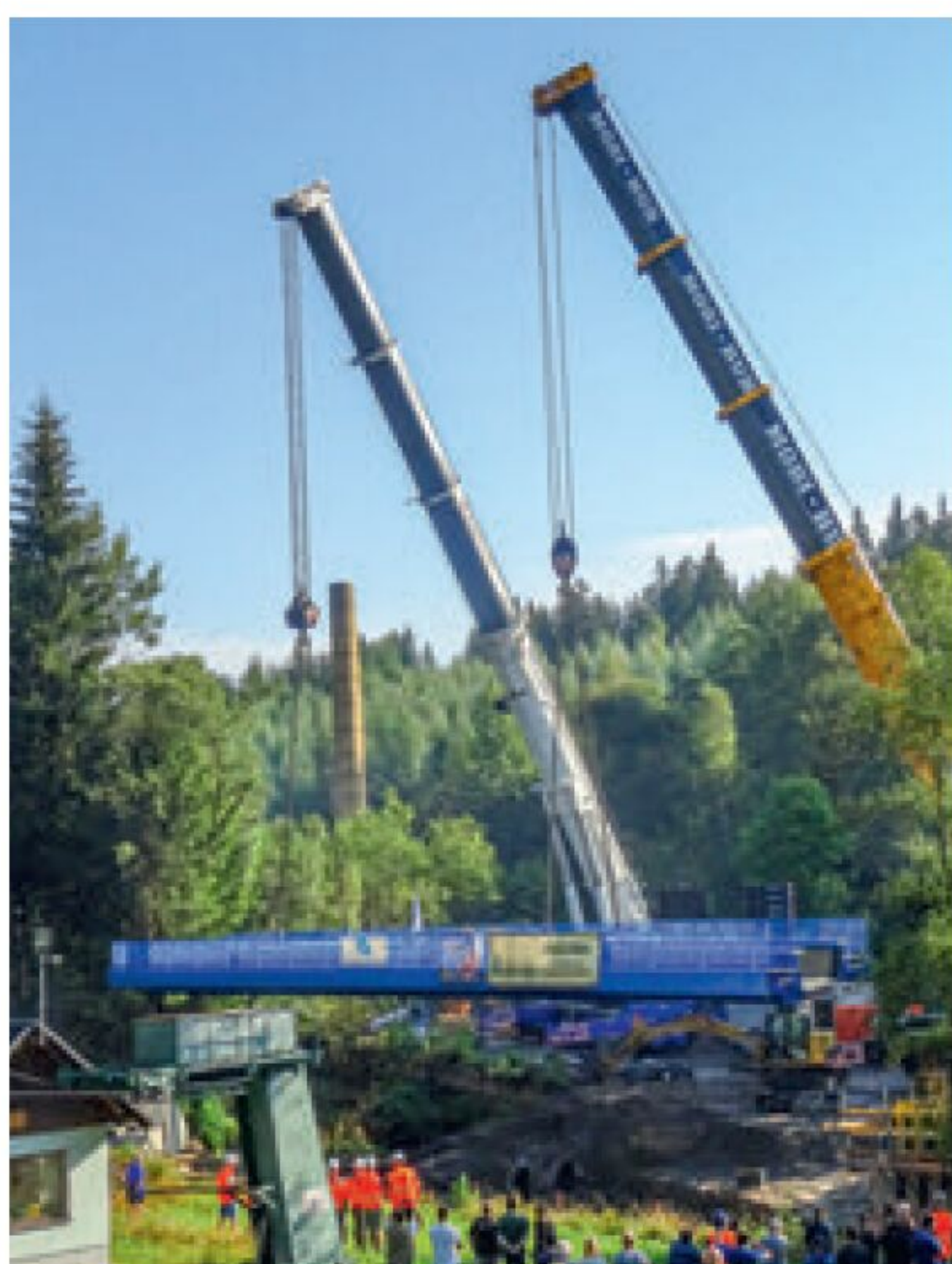
Großprojekt 2024: Zwei große Autokräne setzen den Stahltrog der neuen Brücke am Bahnhof Schlössel ein.
