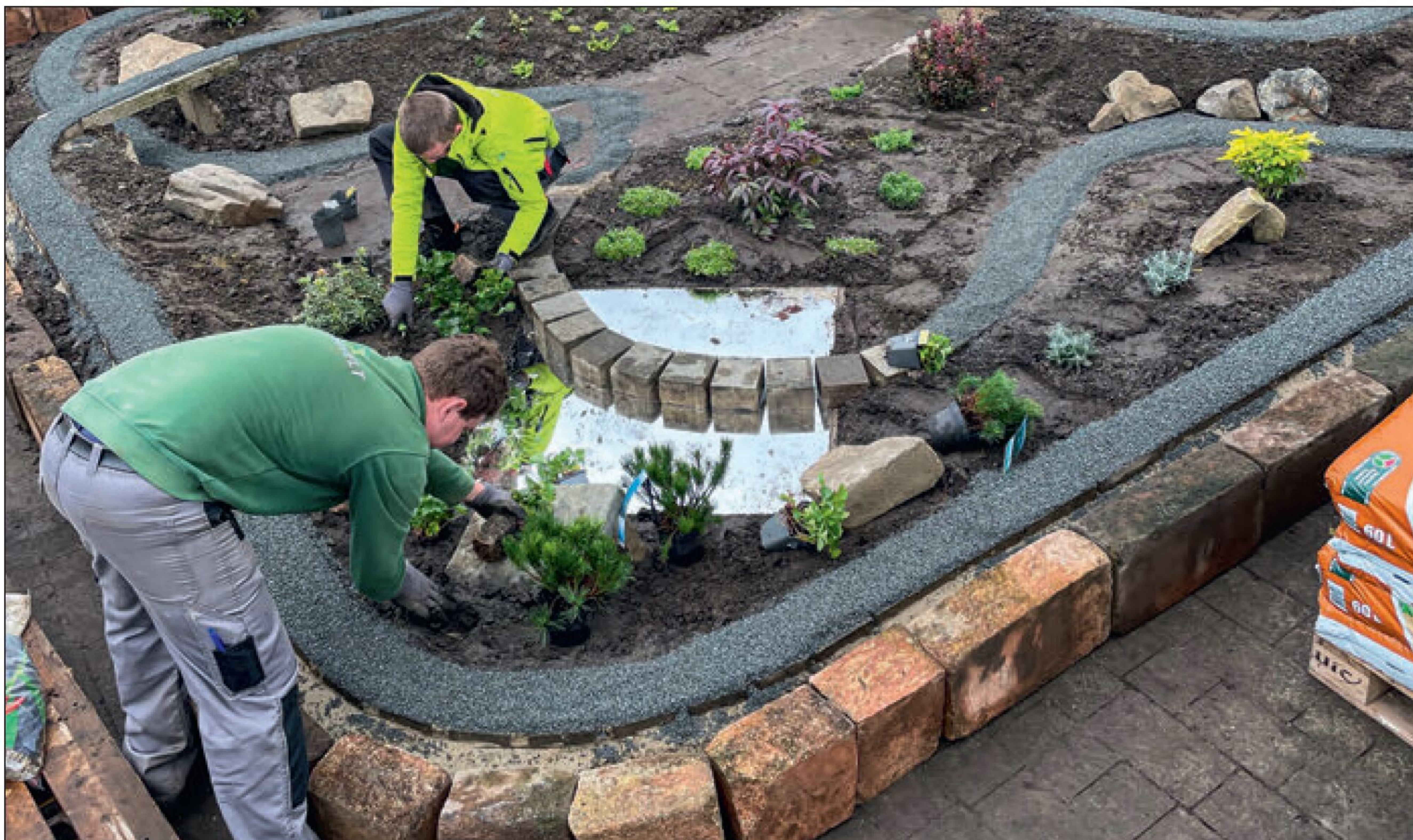
Gartenarbeit: Im dritten Schritt konnten die Auszubildenden von FloraWelt, Max Bege und Eloy Miersch, eingreifen. Die Fahrtrassen erhielten vor dem Verlegen der Gleise eine Auflage aus Rollsplitt. Erste Pflanzen (Koniferen) wurden ebenfalls platziert.
