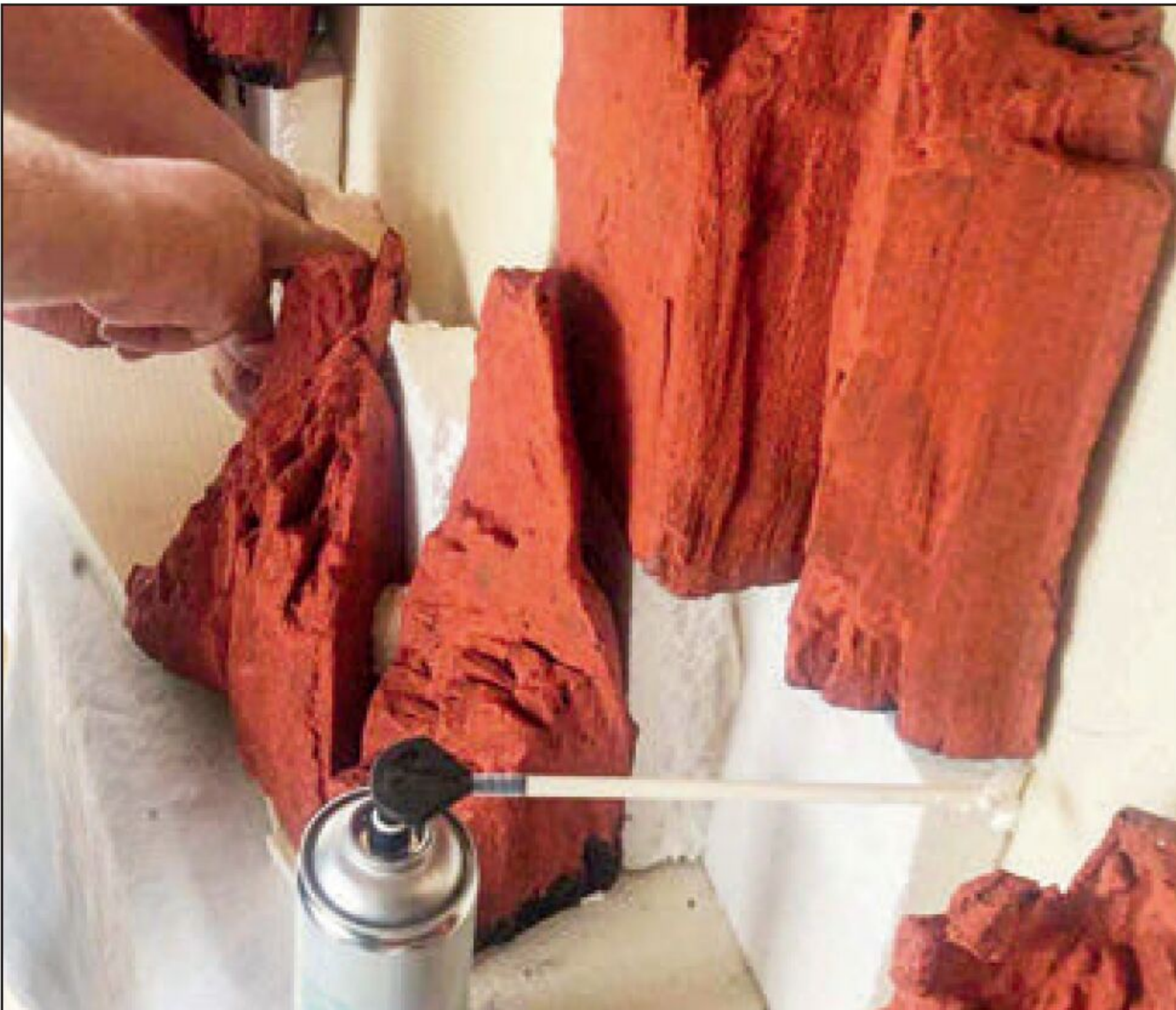
Effektiv: Styroporblöcke dienen als Unterkonstruktion für die einzelnen „Felsen“, fixiert wurde mit PU-Schaum und Schrauben.
