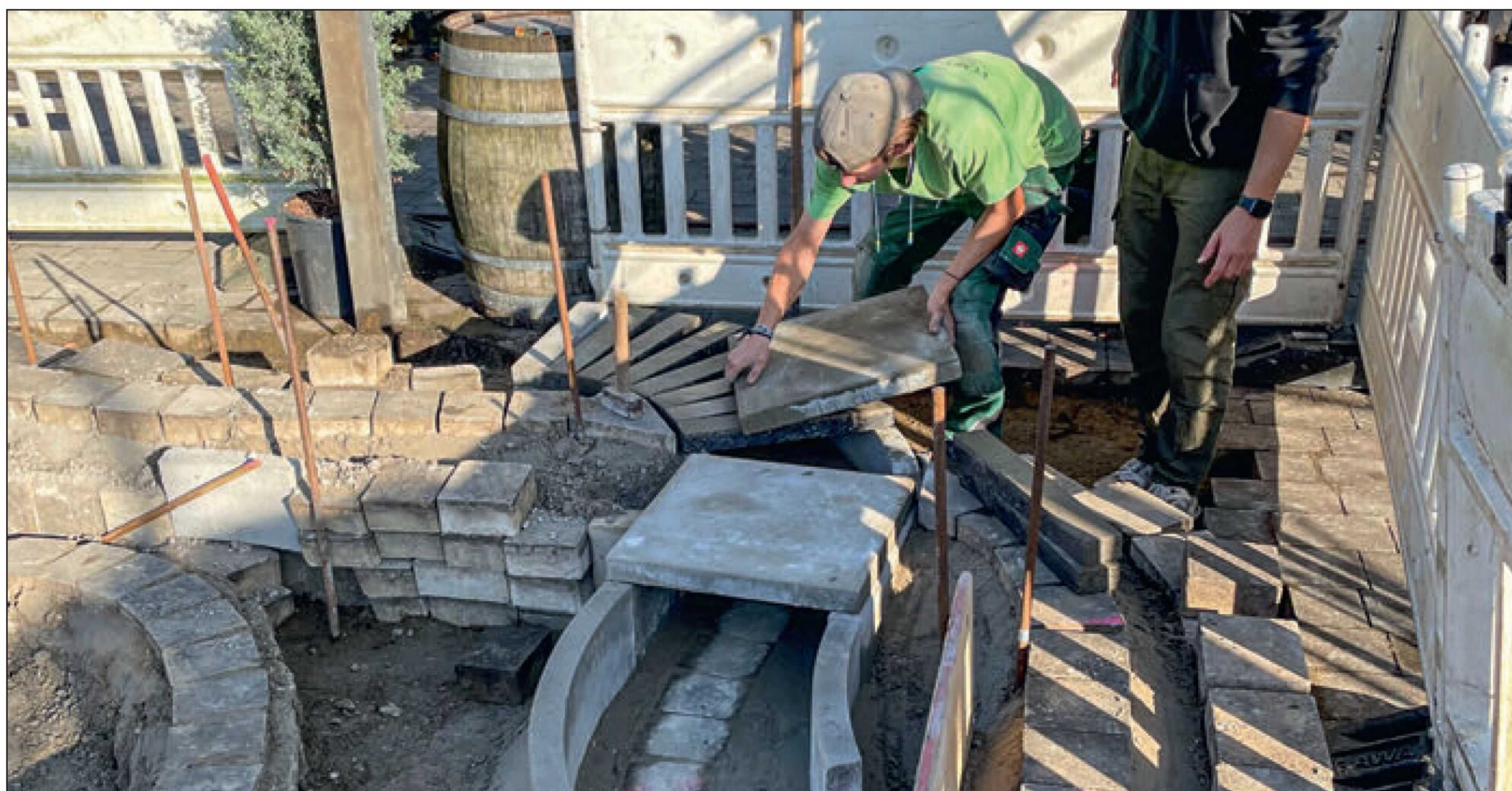
Tunnelvortrieb: Der Aufbau der Tunnelstrecke erfolgte mit Randsteinen und Gehwegplatten. Sie boten auch die notwendige Flexibilität, denn beim ersten Versuch blieb zu wenig Platz für die Durchfahrt der Modelle. Im zweiten Anlauf lief dann alles glatt.
