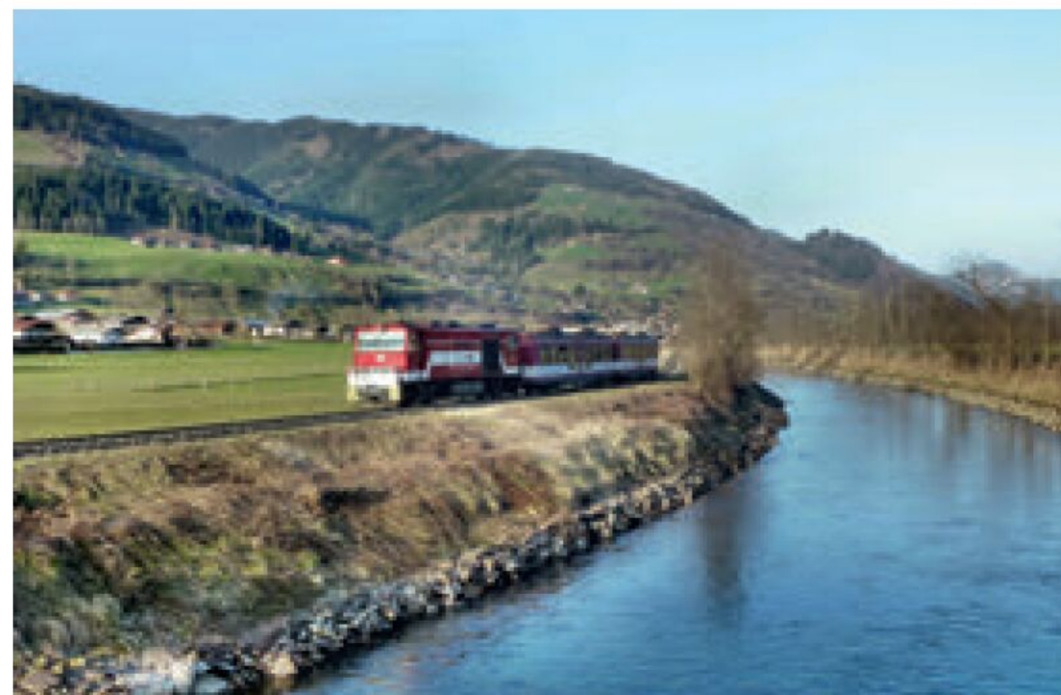
Geschafft: Am 17. Juni konnte der Streckenabschnitt von Niedersill bis Mittersill wieder in Betrieb gehen.
