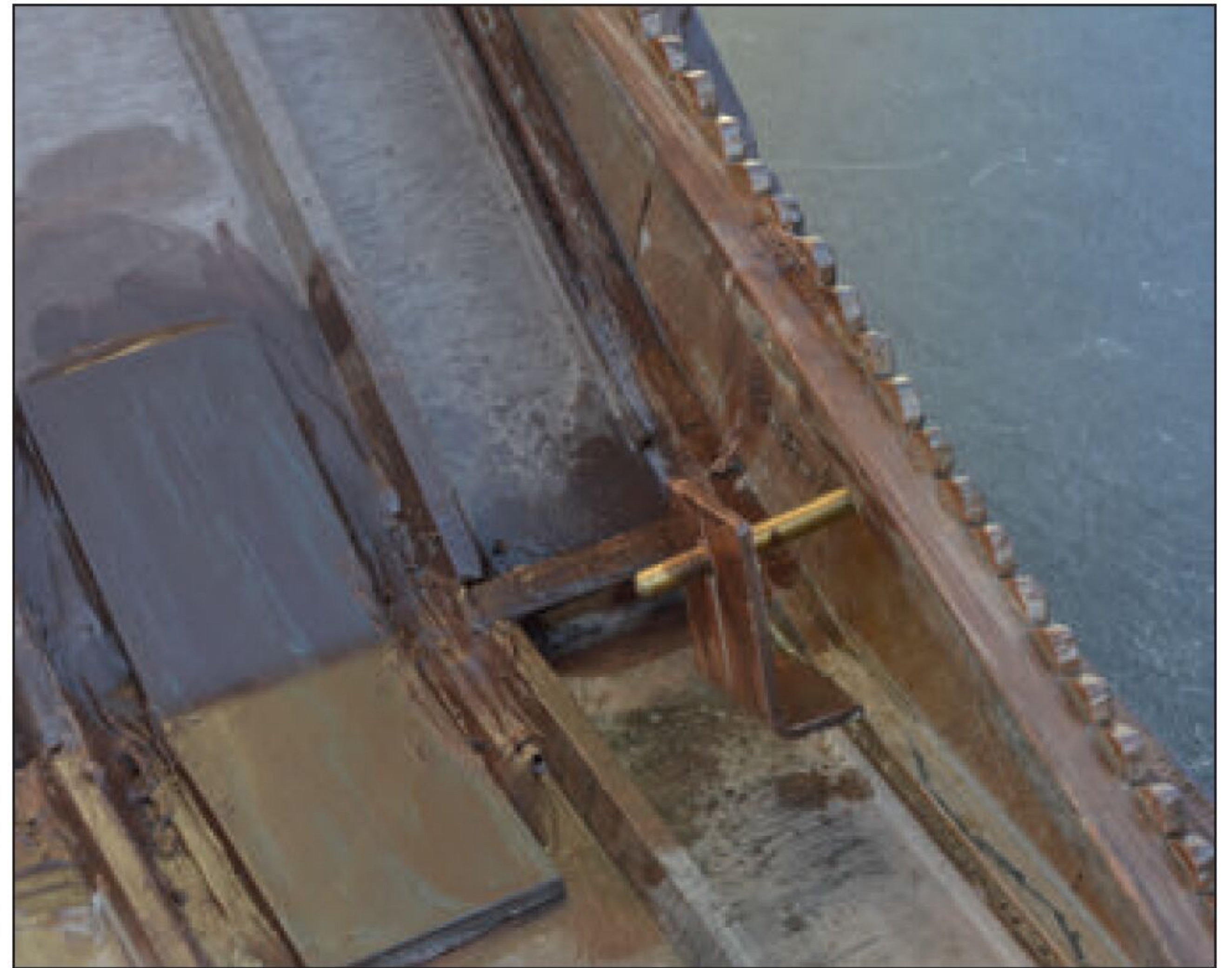
Gut verankert: Im Innern der Sägemühle wird ein kleiner Aluwinkel angebracht und mittels Schraube das Dach daran befestigt.
