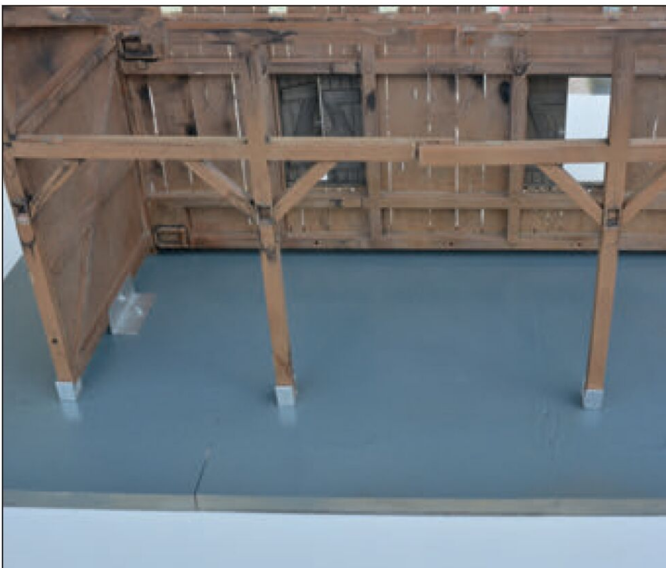
Verbund: Pfosten und Grundplatte verbinden wir mit den zugesägten Alu-U-Profilen, ein kleines L-Profil sichert zusätzlich.
