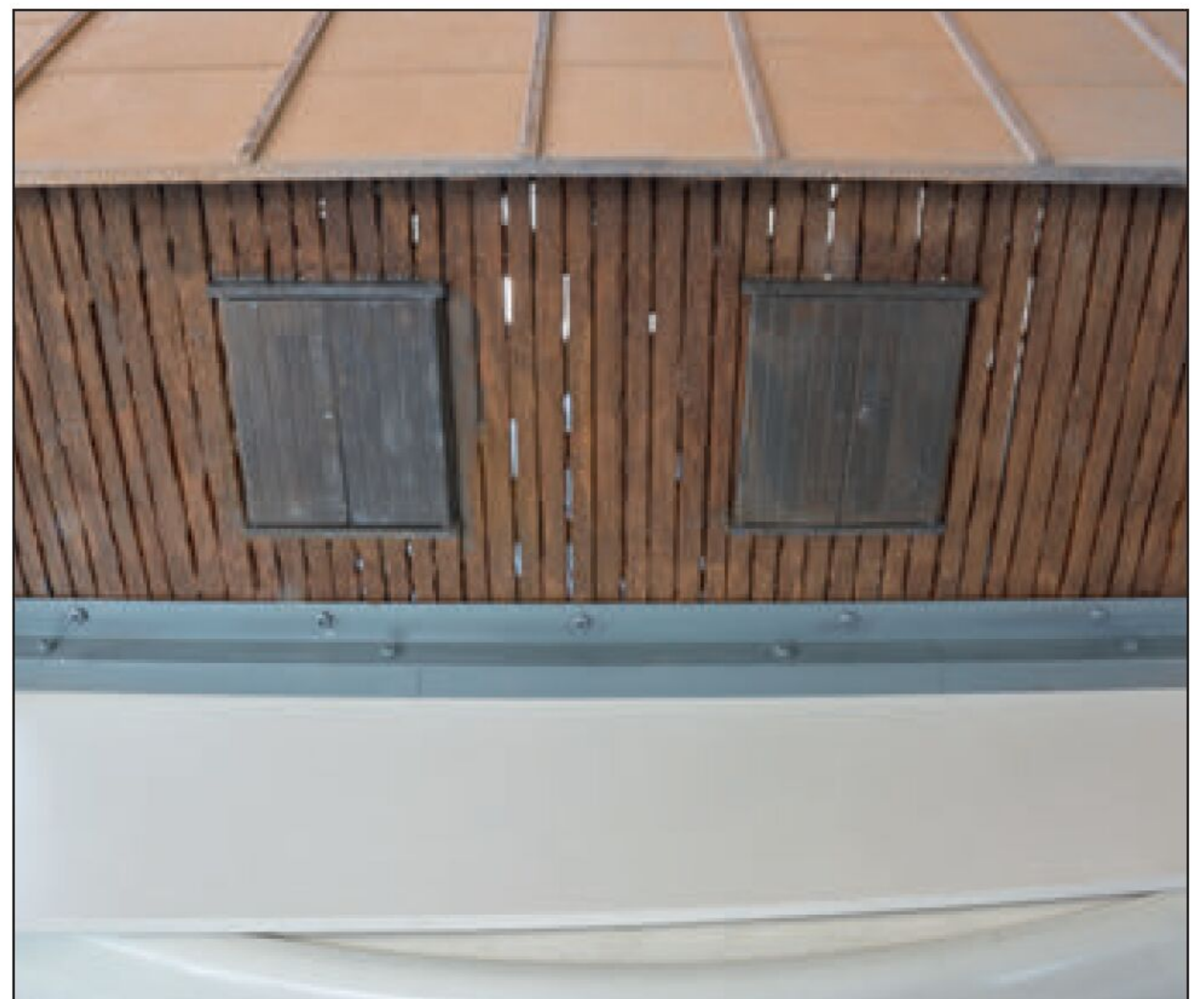
Hilfreich: Das L-Profil an der Rückwand erstreckt sich über die gesamte Gebäudelänge und wird an die Grundplatte geschraubt.
