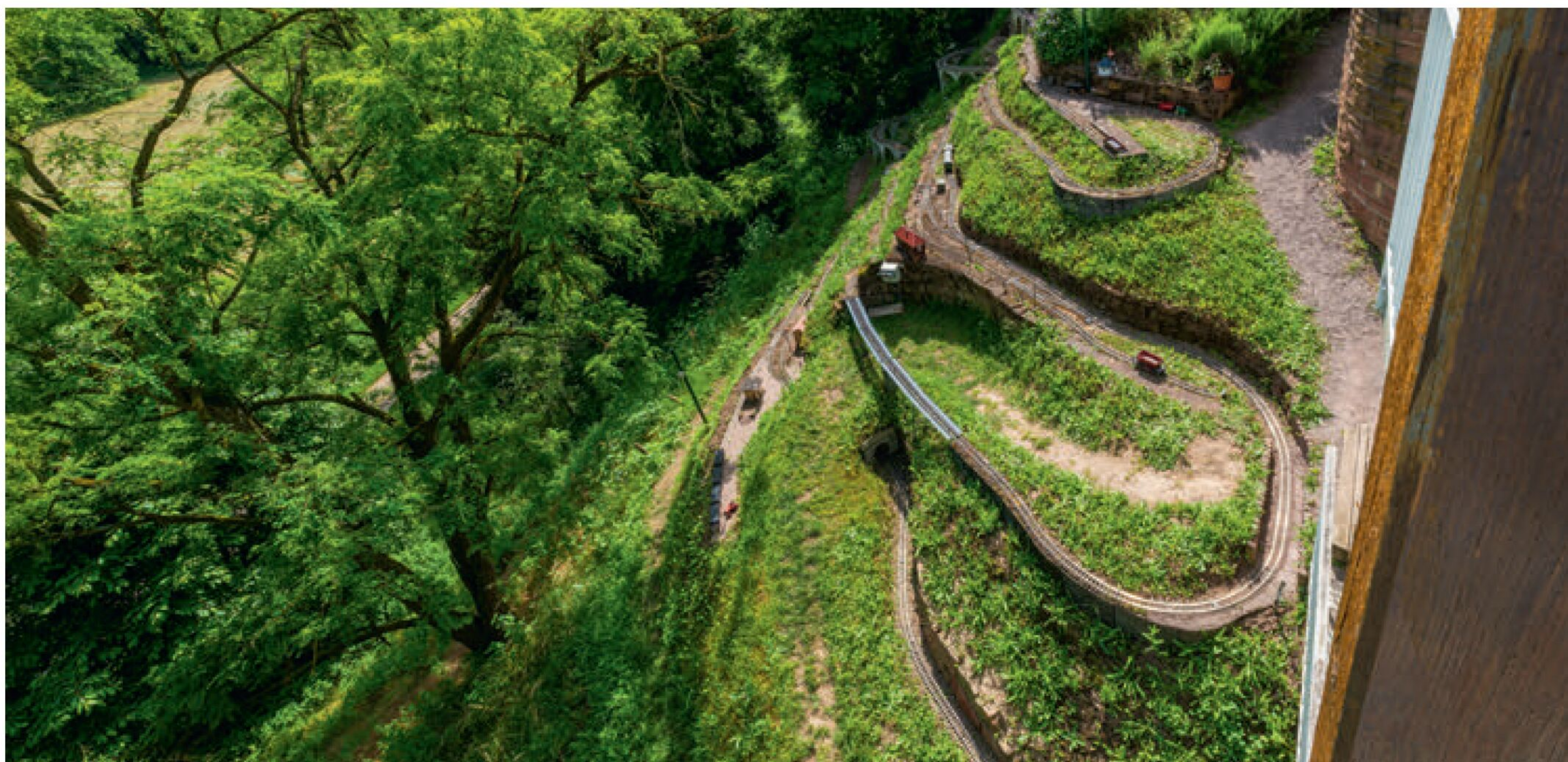
Bergbahn: Der Blick vom Balkon zeigt den Streckenverlauf eindrucklich und die verschiedenen Maßnahmen, um den Hang zu sichern.
