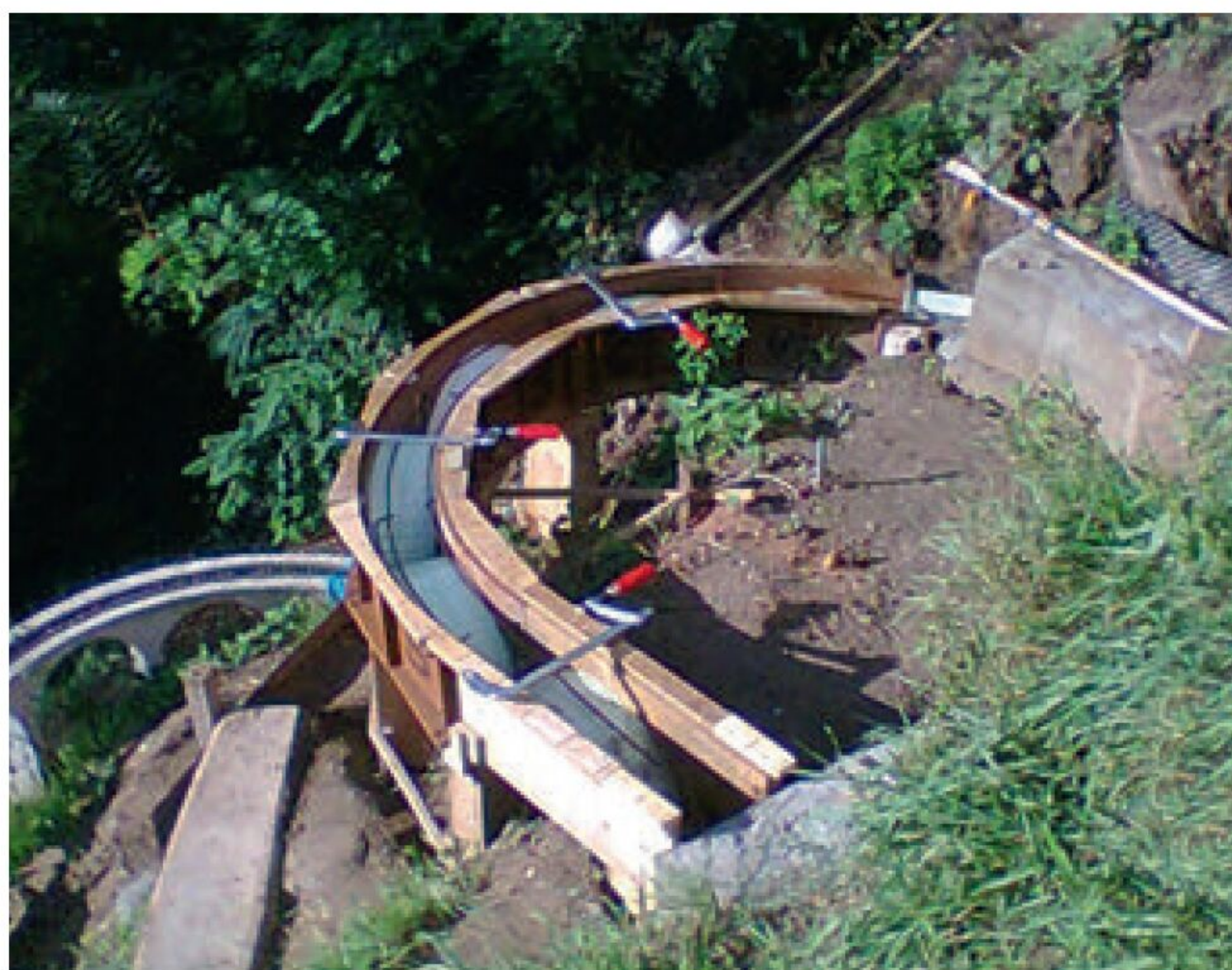
Viadukte: Jeder einzeln eingeschalt und mit Beton ausgegossen.
