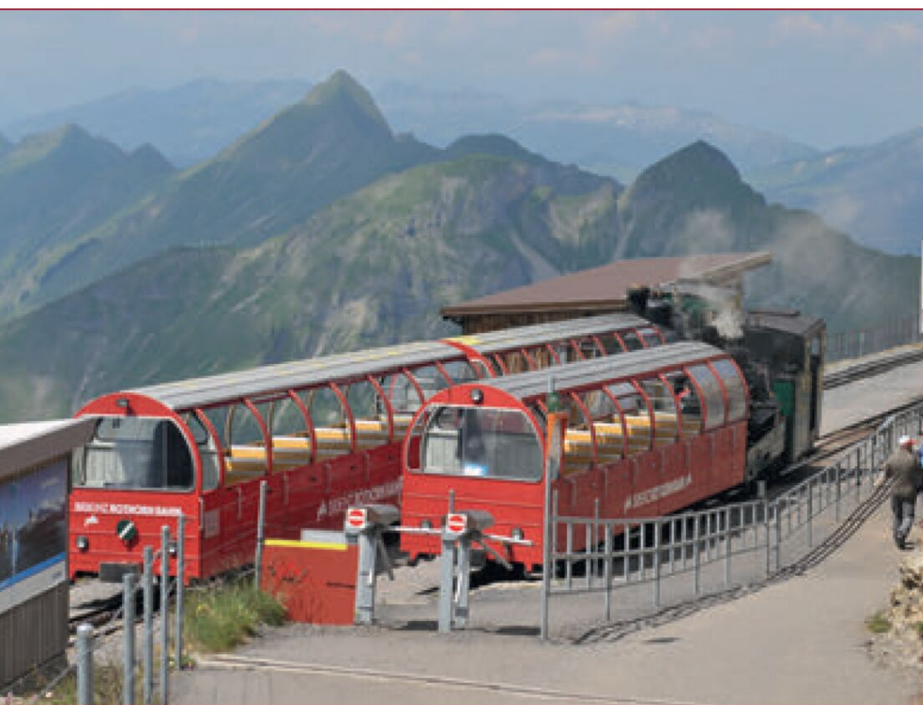
Wenig Platz: Die zweigleisige Bergstation wurde direkt am Steilhang erbaut. Sie wird nach circa einer Stunde Fahrt erreicht.
