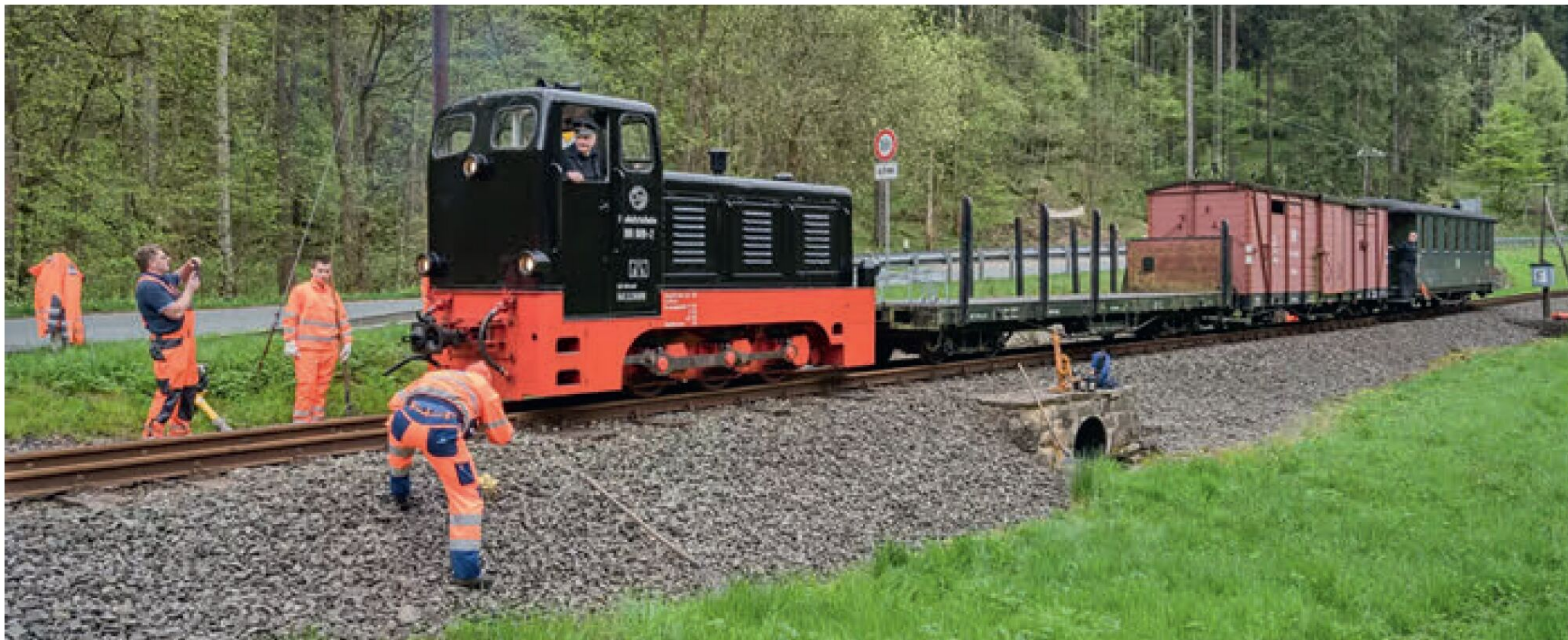
Arbeitseinsatz I: Im Mai 2023 die V10C beim Arbeitseinsatz zwischen der Straße am Grumbach und dem Streckenkilometer 17,4. Bei den Gleisunterhaltungsarbeiten ging es um das Nachstopfen der Schienenstöße ebenso wie um das Prüfen der Schienenbefestigungen.
