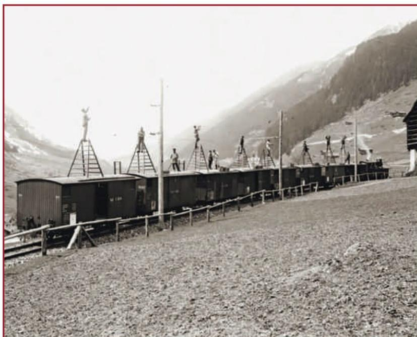
**Früherer Aufbau:** Im Jahr 1913 begann die Rhätische Bahn mit den Arbeiten zur Elektrifizierung. 1922 konnte auf der gesamten RhB-Strecke mit Strom gefahren werden.
