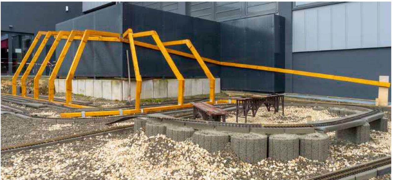
**Gute Basis:** Massive Holzbalken sowie Winkelverbinder und Balkenschuhe bilden die tragenden Elemente der Gebirgskonstruktion.
