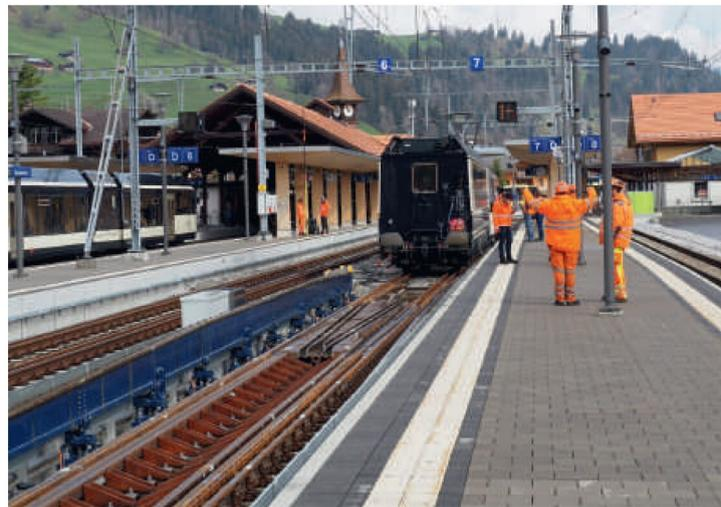
**Übergang:** Im Bahnhof Zweisimmen steht die Umspuranlage, die auch die Wagenkästen auf die 550 Millimeter der Normalspur anhebt.
