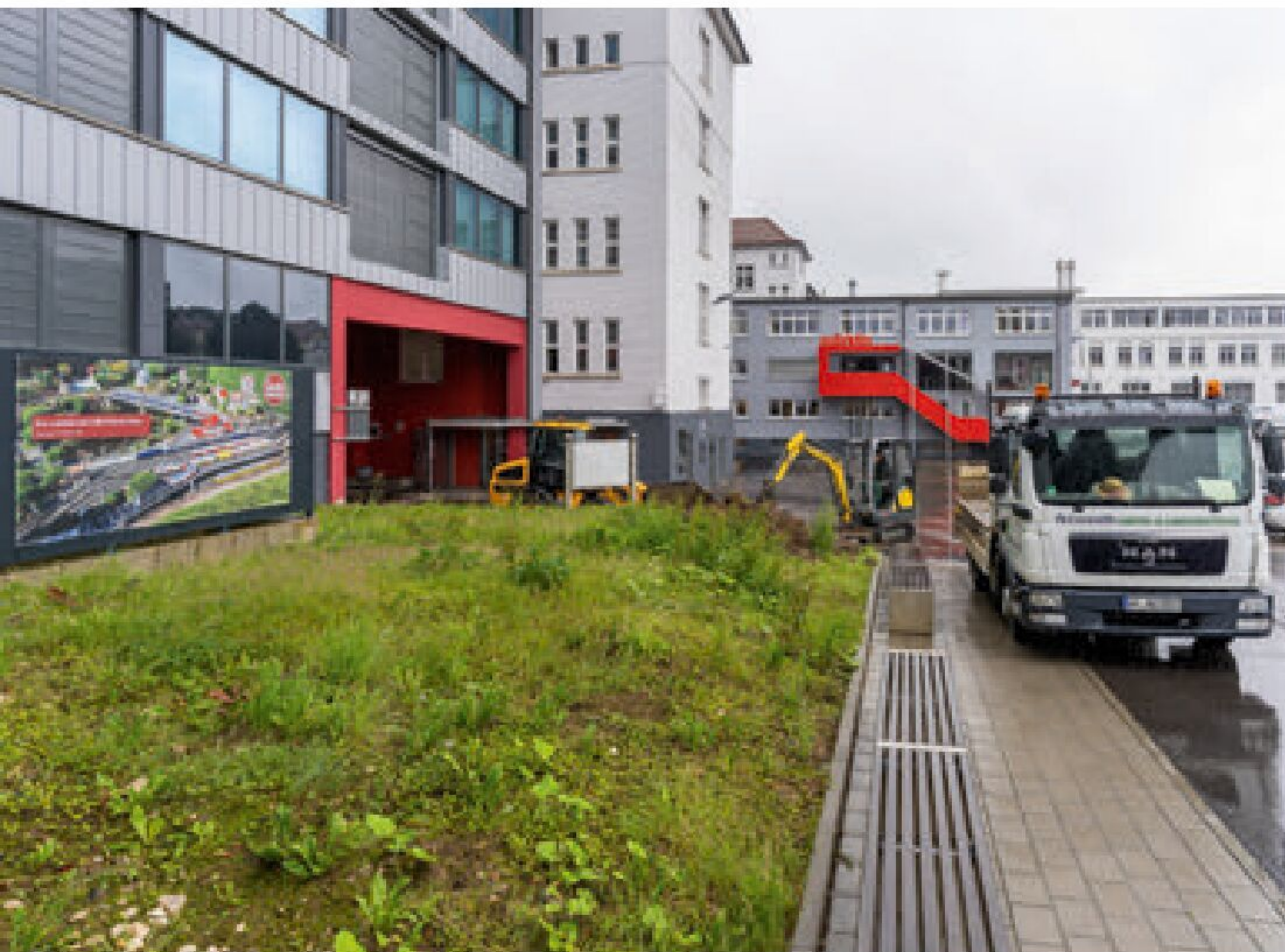
Erdarbeiten: Der Ausbau der Schauanlage startete im Juni 2021.
