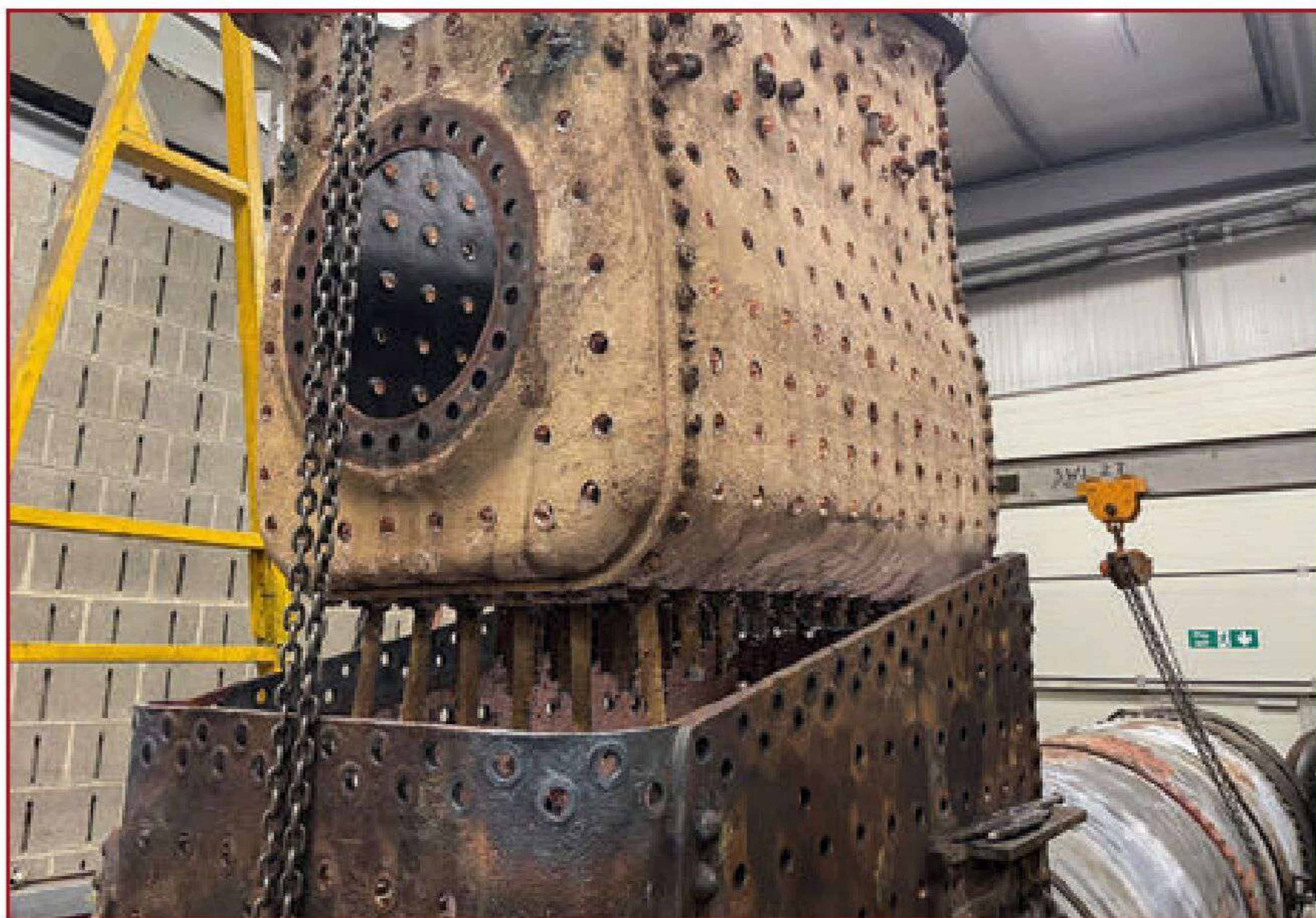
Nächster Schritt: Die Feuerbüchse wird bei der NNR zur Sandstrahlung vom Kessel getrennt. Die weiteren Renovierungsarbeiten können nun beginnen.
