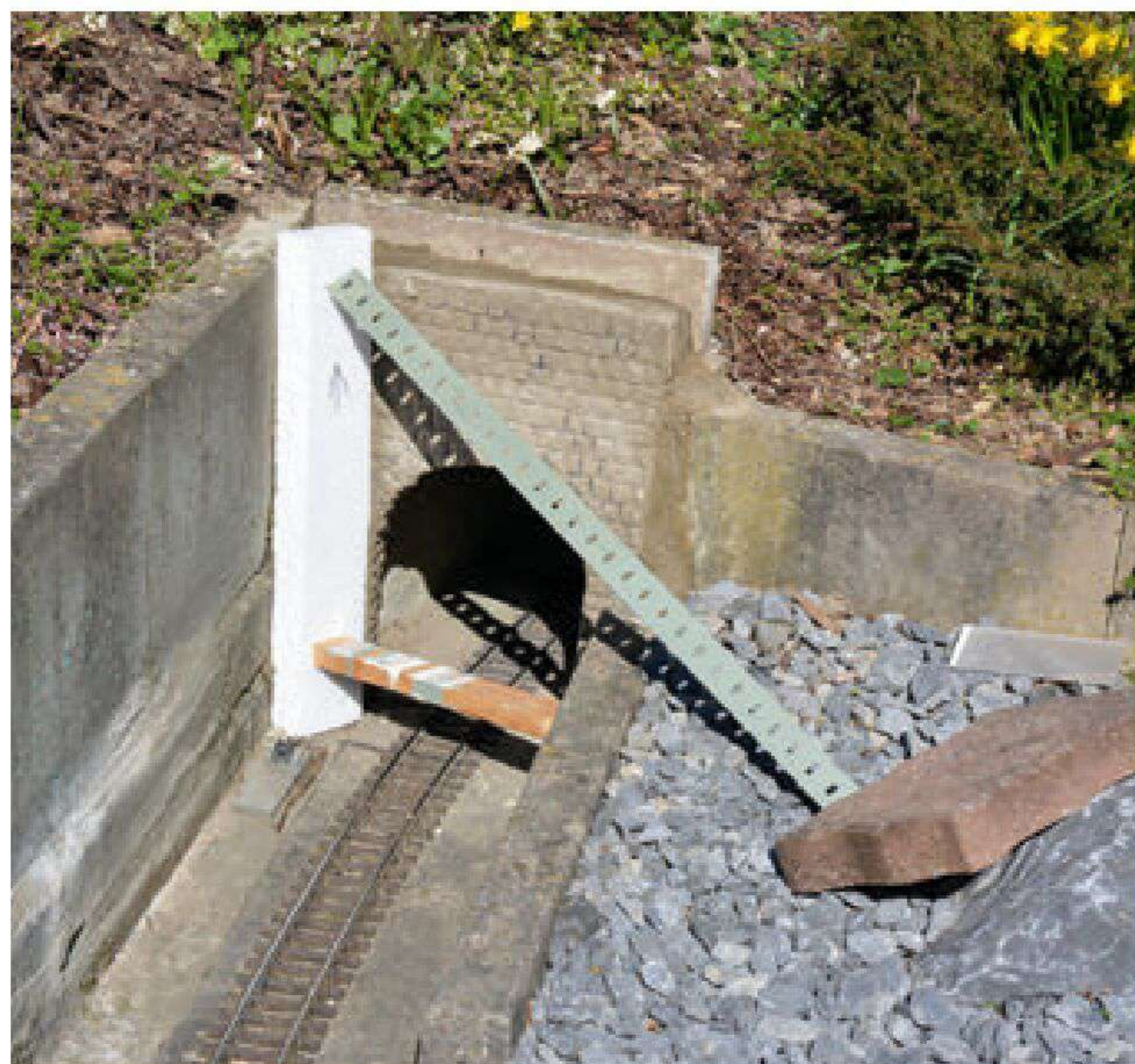
Die Lücke zum L-Stein gießen wir ebenfalls mit Beton aus. Ein schmaler Streifen aus Styrodur dient als Schalelement.
