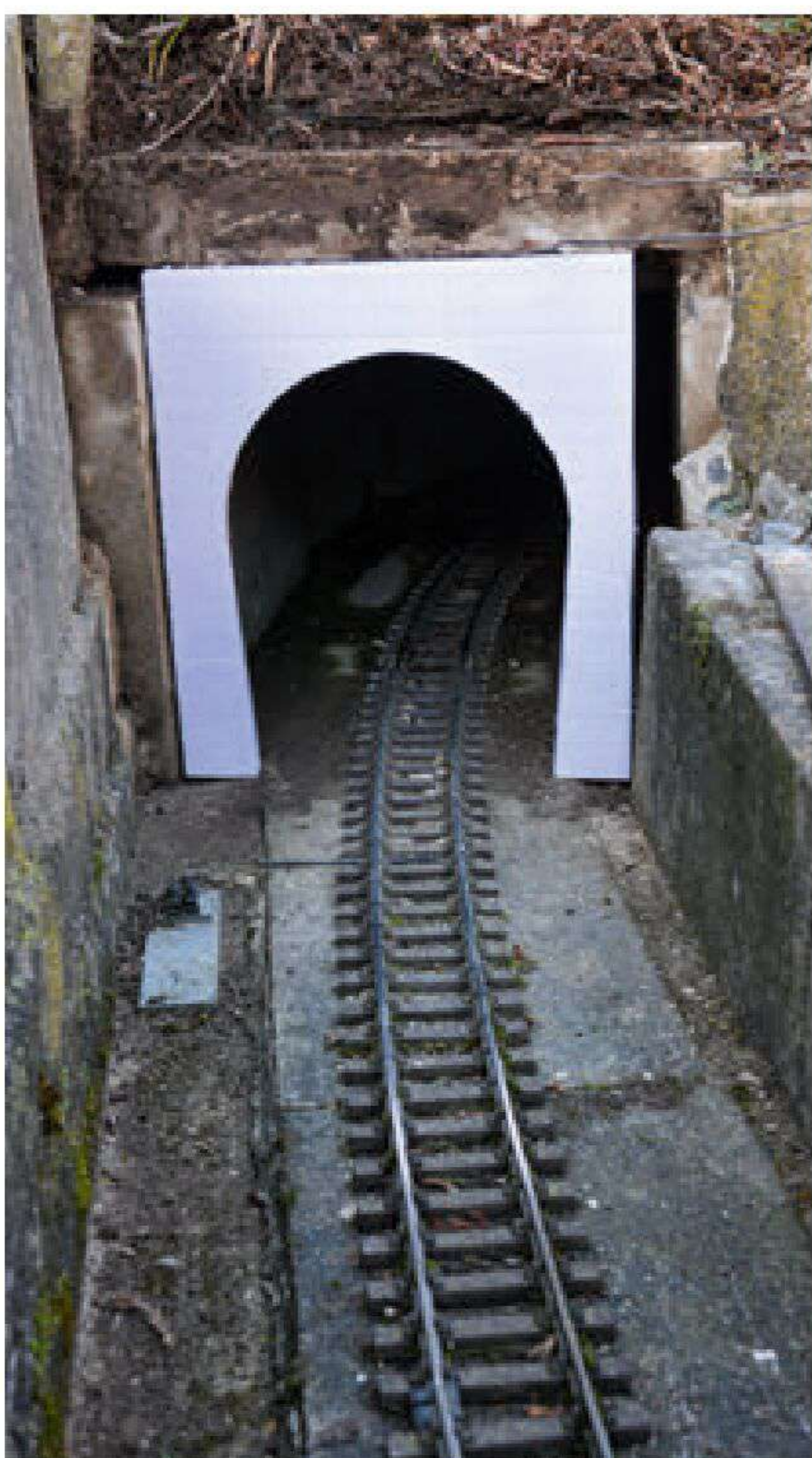
Ein erstes aus Styrodur gefertigtes Portal dient dazu, die Abmaße zu verifizieren.
