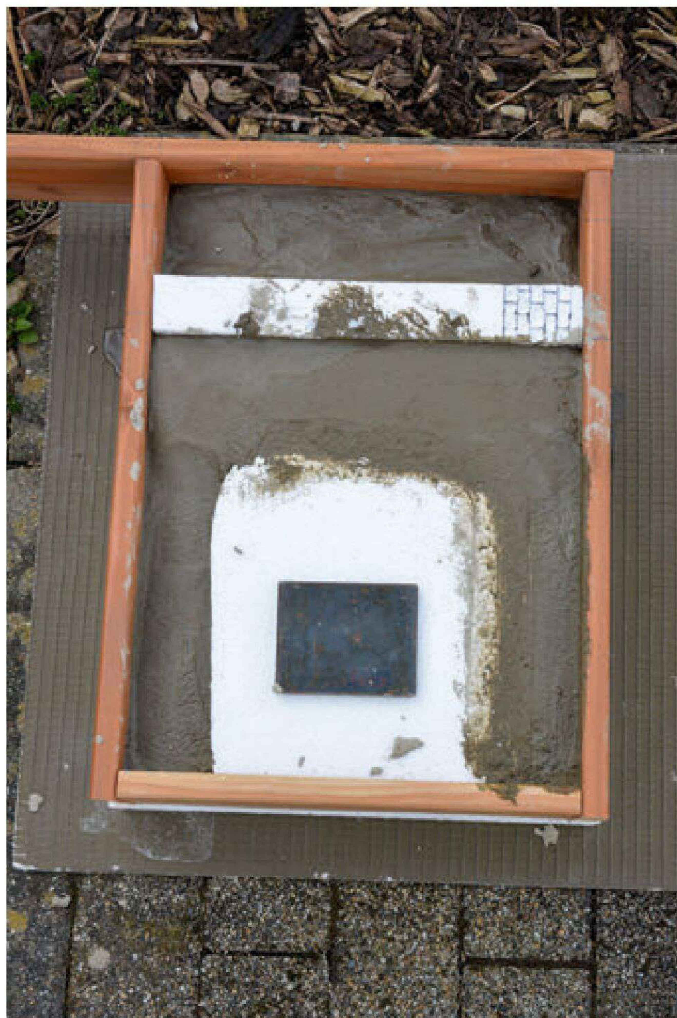
Die Negativform umrahmen wir mit Brettern (Höhe sechs Zentimeter). Nun kann die Form mit Beton ausgegossen werden, den wir im Verhältnis 1:3 (3 Teile Sand, 1 Teil Zement) anrühren.
