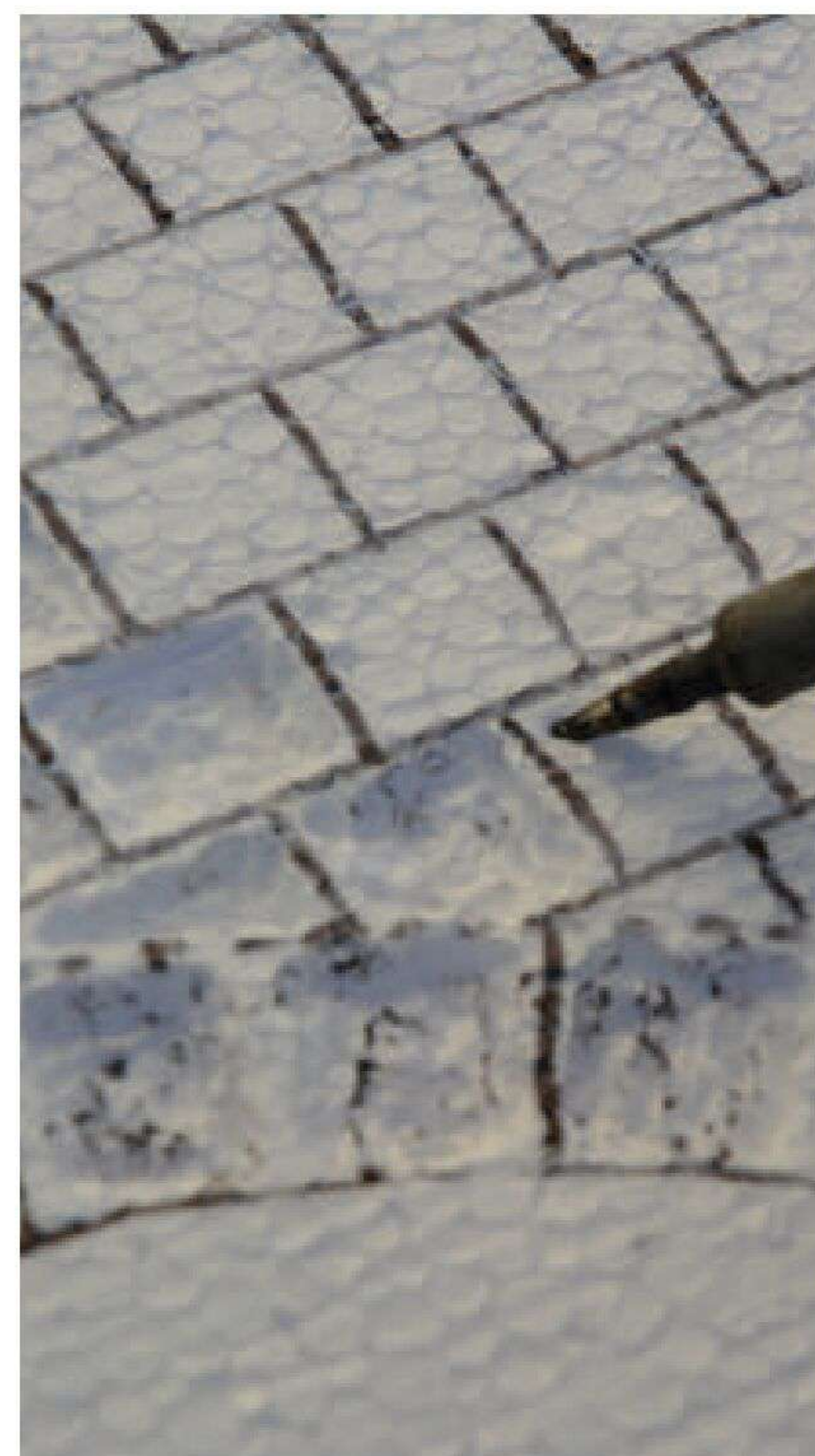
Mit einem LötKolben brennen wir dann entlang der Linien Vertiefungen ein.
