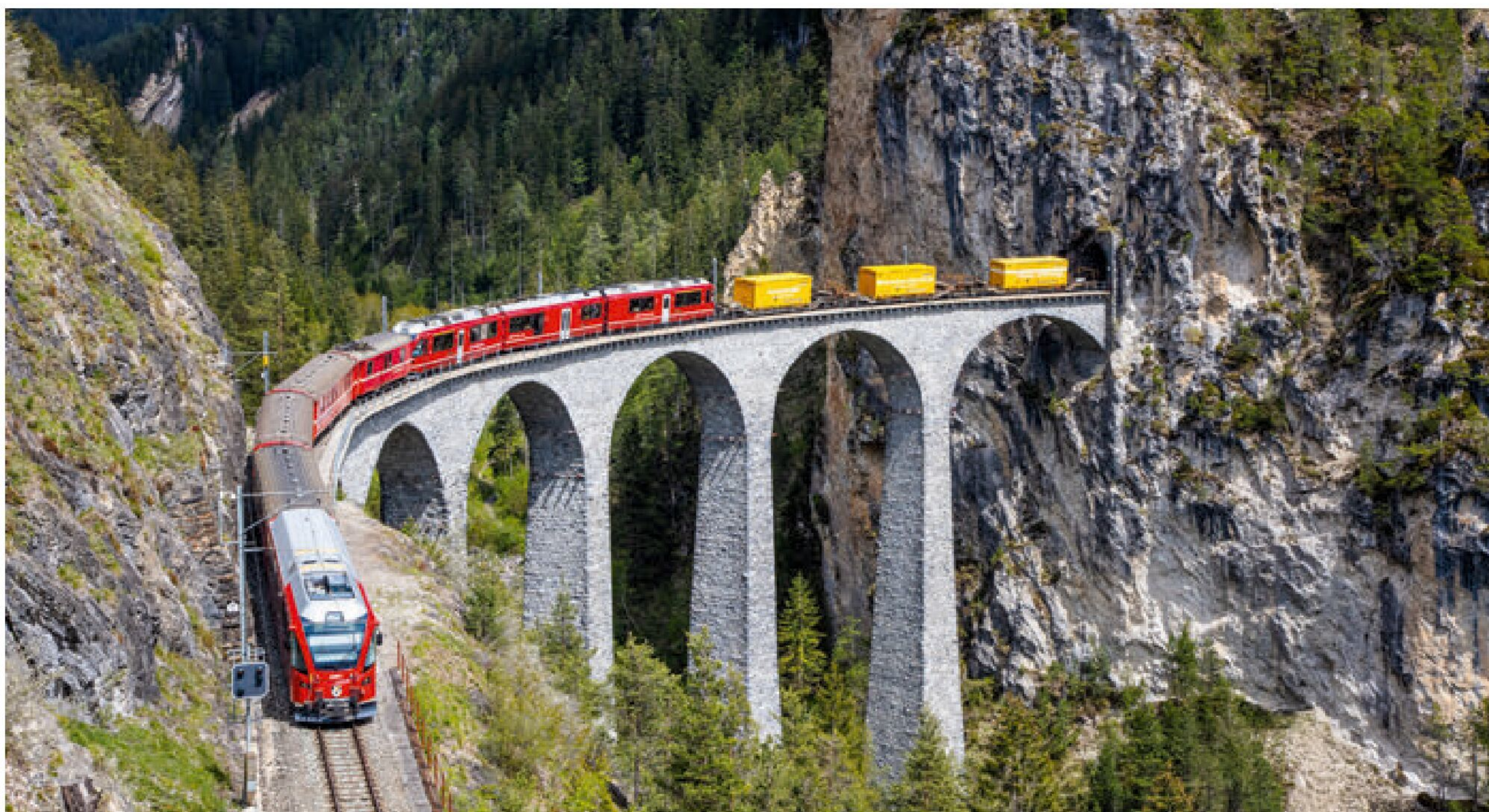
Rhätische Komposition: Der Steuerwagen Bt 52801 mit einer Einheit ABe 8/12 und Gütertragwagen mit Post-Containern überquert den Landwasserviadukt – ein mehr als imposanter Anblick. Platz 1 unseres Fotowettbewerbs geht an R. Hildenbrand.
