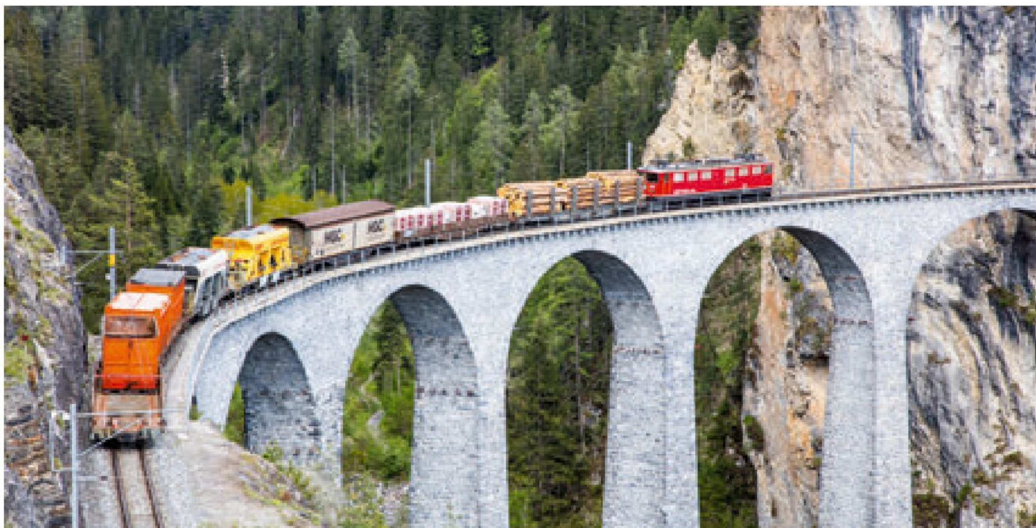
Lebensader: Die Ge 6/6 II 703 quert den Landwasserviadukt mit wichtigen Baumaterialien – von Holz bis Schotter. Eingereicht wurde das Foto von H. R. Honegger ( Platz 6 ).
