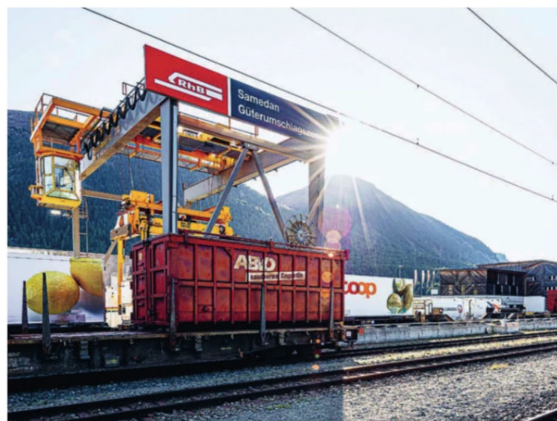
Rushhour in Samedan: Im Güterumschlagzentrum Oberengadin wartet gerade ein ABVO-Container auf seine Beladung.
