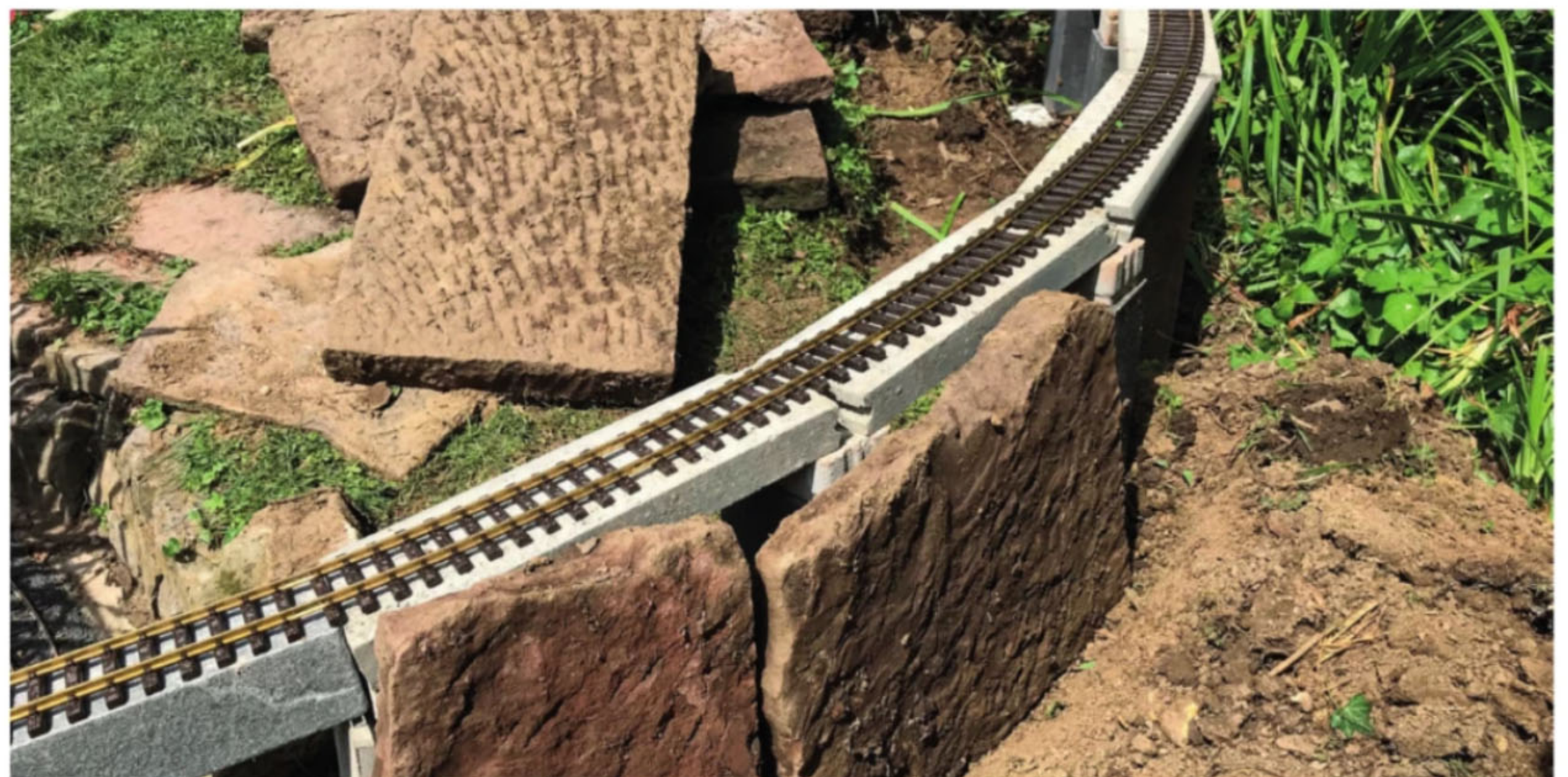
Hochbau: Einige Teile der Schienentrasse wurden bis zu 60 Zentimeter aufgeständert.
