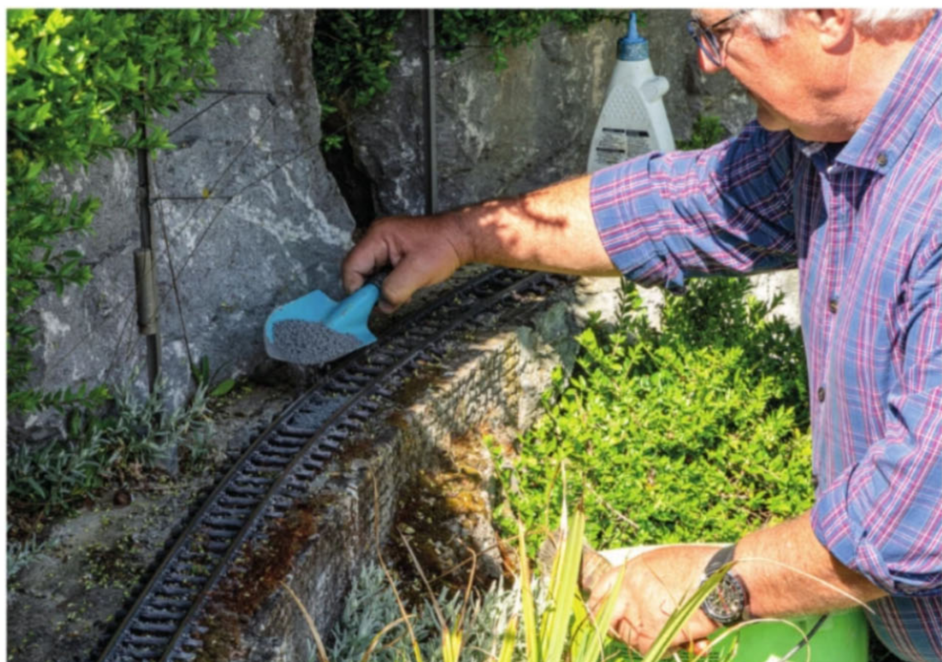
Feinarbeit: Die Gleise werden mit drei Millimeter feinem Basalt-Fugensplitt geschottert.
