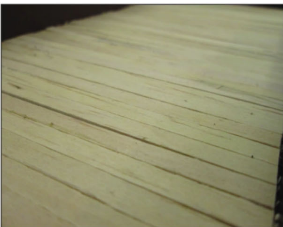
Einleger: Der Holzboden wird verlegt.
