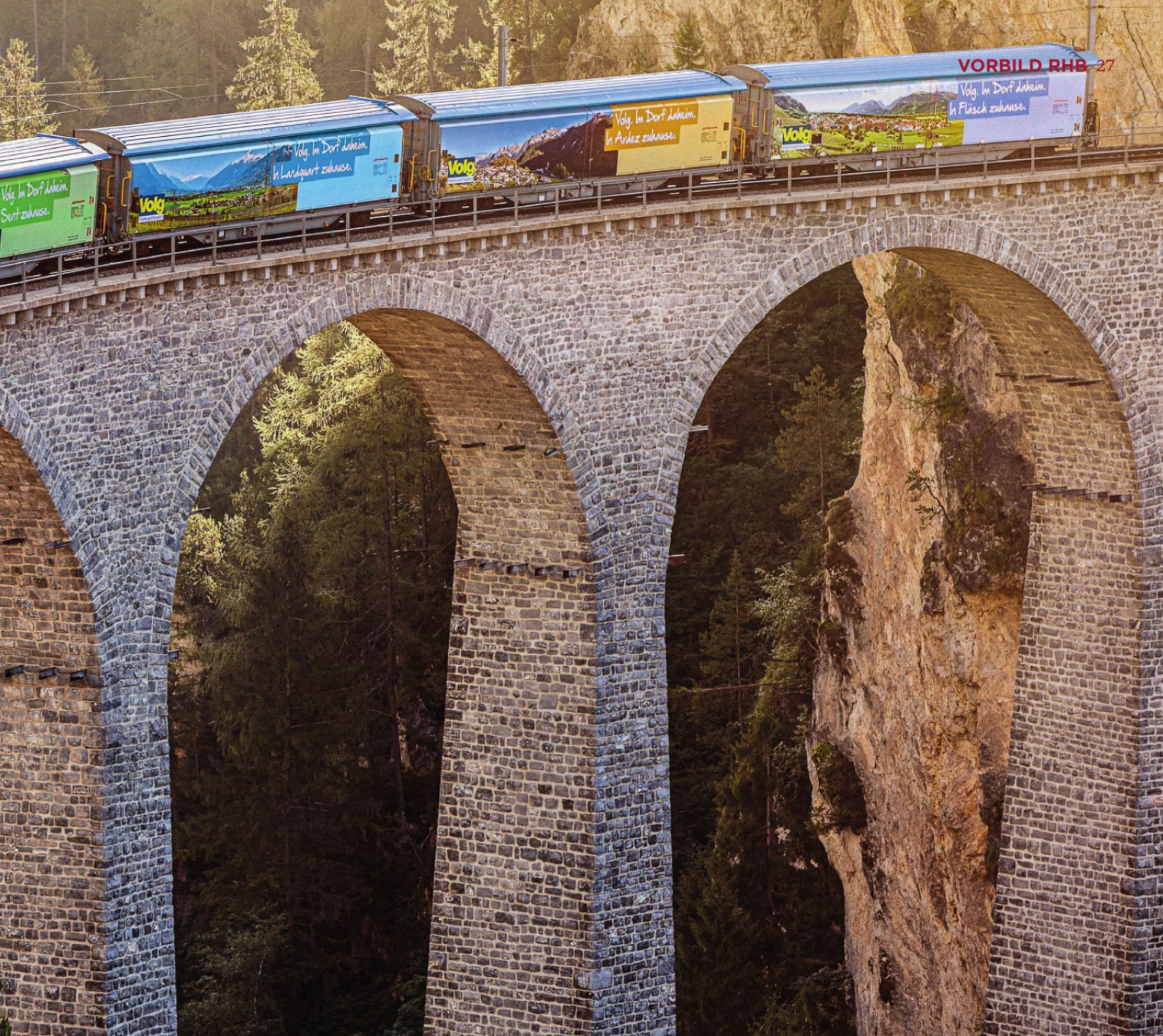
Mehr als beeindruckend: Eine Ge 4/4 II (Nr. 621) überquert mit Güterwagen vom Typ „Haik“ den grandiosen Landwasser-Viadukt.
