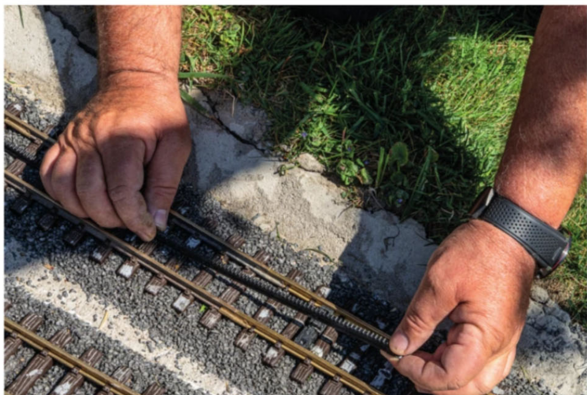
Flott gemacht: Zuerst werden die Zahnstangenhalter eingesetzt, dann die Zahnstangen verlegt.
