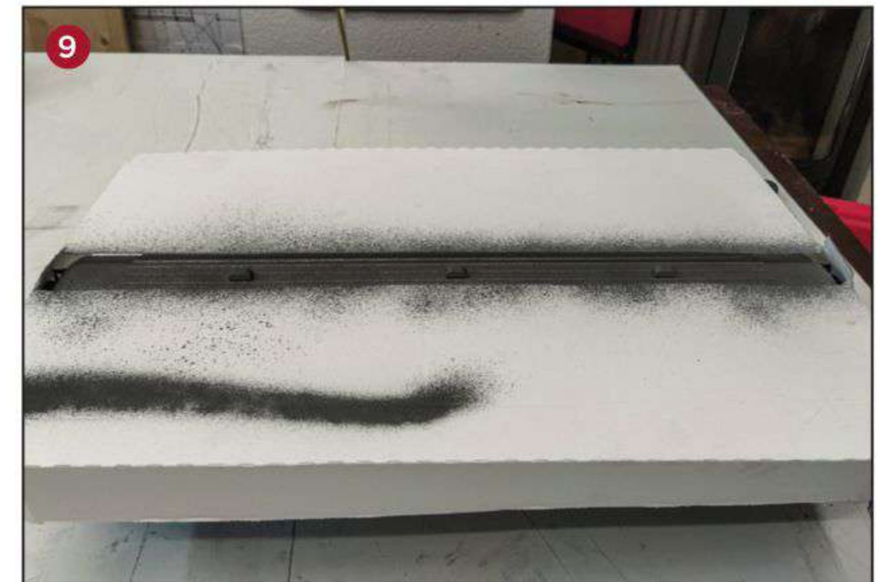
Dacharbeiten: Mit einer Schablone wird der Schmutzstreifen aufgetragen.
