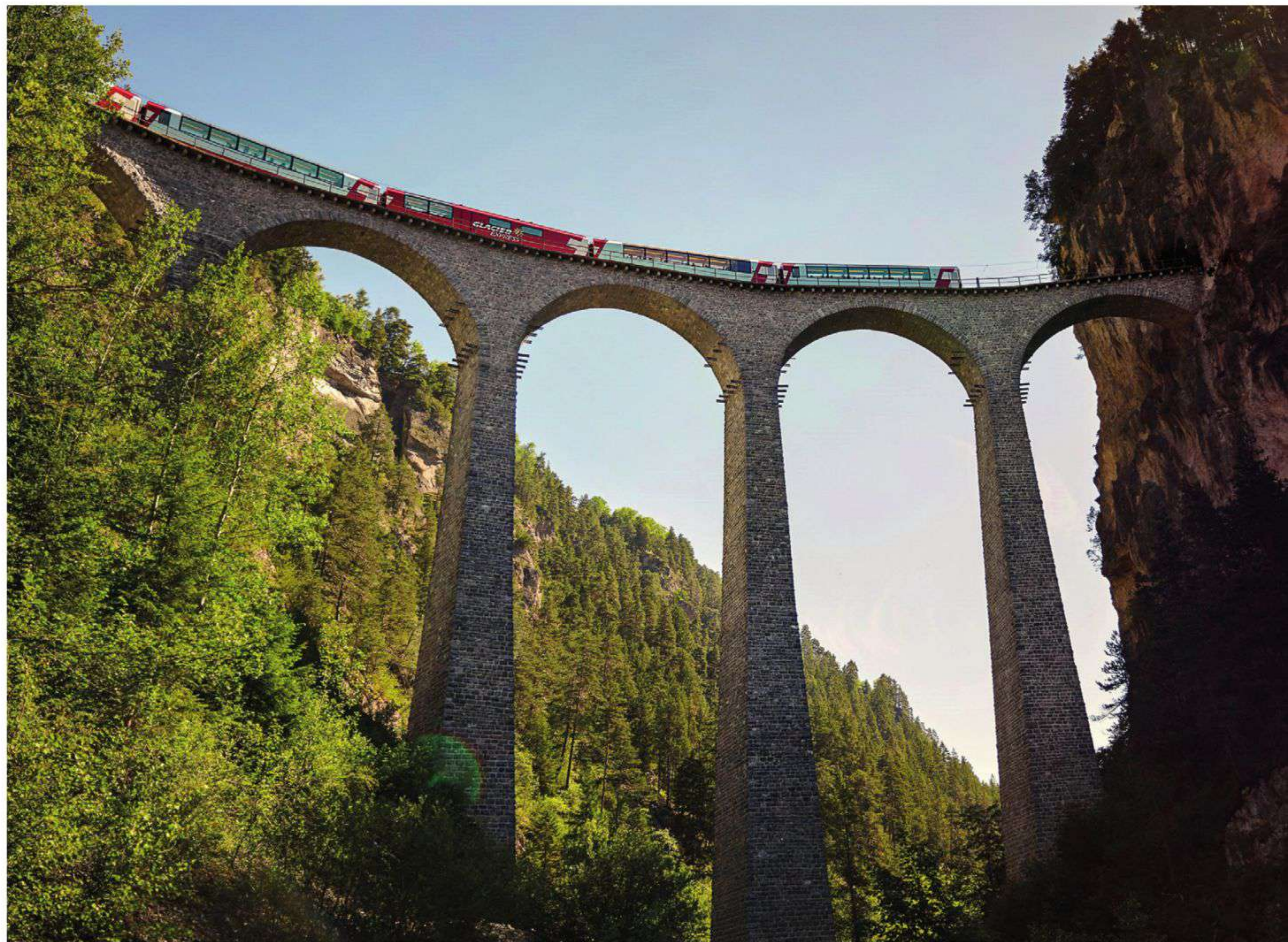
Spektakulär: Der 65 Meter hohe Landwasser-Viadukt ist das beeindruckendste Brückenbauwerk auf der 291 Kilometer langen Reise des Glacier Express.
