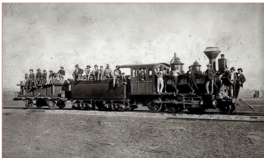
Auf Montage: Eine „Mogul“ der Western Railway namens „Pioneer“ an einer Bahnbaustelle zwischen Roma und Mitchell, South Dakota, im Jahr 1885. Gut zu sehen ist die kompakte Bauweise der Lok, die ihren universellen Einsatz ermöglichte.
