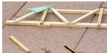
Fachwerk-Bau: Mit Schreinerwinkel, Geodreieck und Stift bringt man die Pfosten und Streben für die Seitenteile in die richtige Position.
