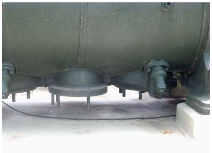
Unterseite des Zylinders, in der Mitte der Dampfeintritt, rechts und links die (größeren) Austritte.
