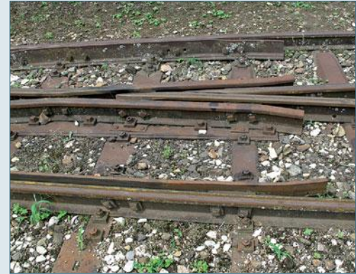
... und am geschraubten Herzstück, den Radlenkern und Futterstücken
