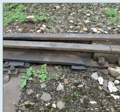
Gleitstuhlplatten und Zungengelenk
