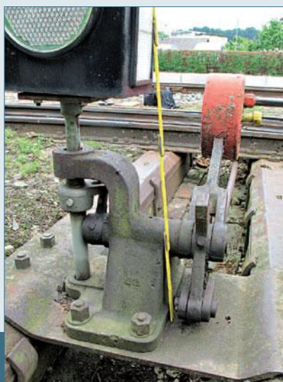
Anordnung Stellbock und Weichenlaterne. Länge Stellhebel (oben)
