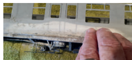
Abfeilen des reparierten Abschnitts der Sohlenleiste unterhalb der Aussparung
