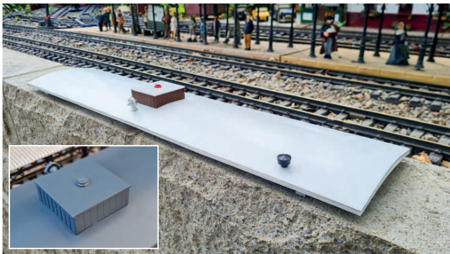
Bau und Montage des Wassertanks auf dem Dach
