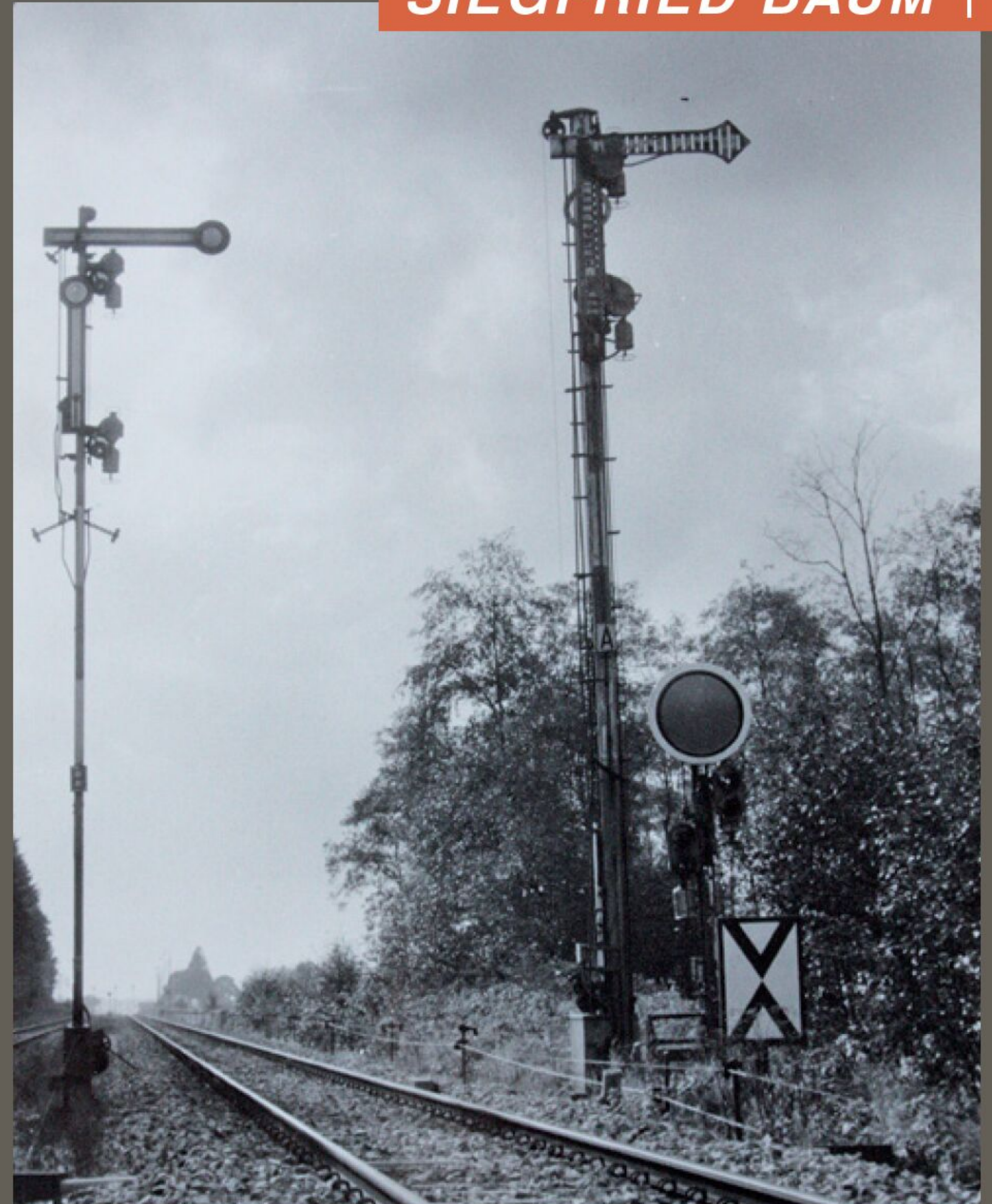
„Gemischtes Doppel“ von Einfahr-Signalen für Ungerhausen aus Richtung Buchloe im Herbst 1968. Rechts das der Hauptstrecke und links für die Nebenstrecke von Ottobeuren. Die Signallampen aller drei Signale wurden noch mit Flaschengas betrieben.
