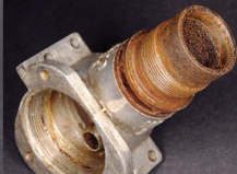
Verdeckt, angerostet und feststehend – bei dem dreht sich nichts mehr.
