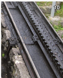
Granitplatten als Unterbau, verankert im Fels
