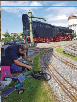
Unser Signal- und Weichen-Techniker bei der Arbeit: Hier werden die ersten Hauptsignale installiert.
