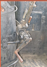
Die Umsteuereckel für die Feineinstellung nebst Spindel. Der kleine Hebel rechts betätigt die Entwässerungshähne.
