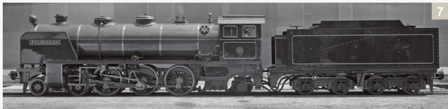
Lok Tazzelwurm im Mai 1950 vor Ablieferung nach Stuttgart im Werkhof aufgenommen. Die Farbe ist wohl noch nicht ganz trocken ...
