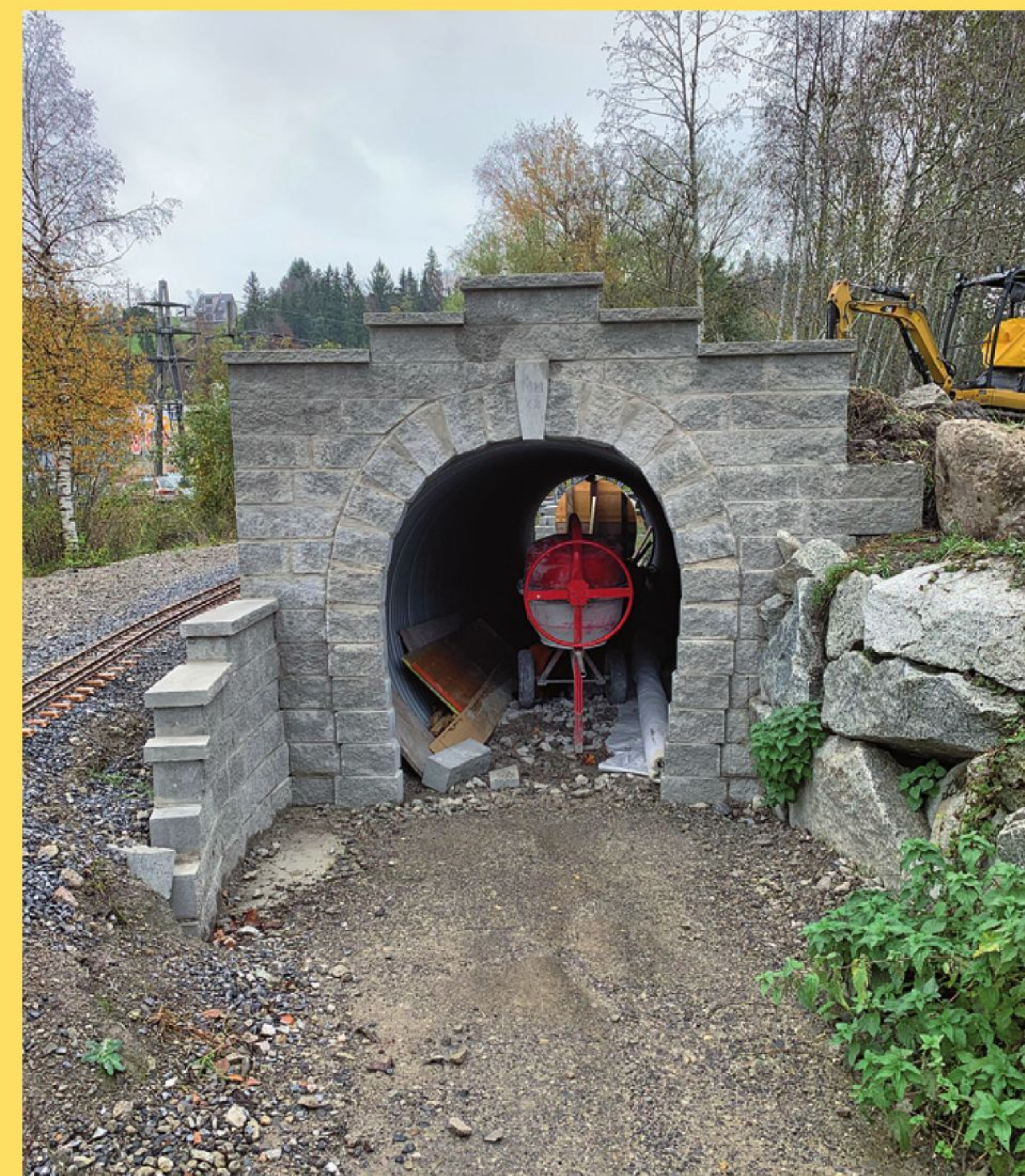
Schönes Tunnelportal wartet nun auf die Gleiserschließung.
