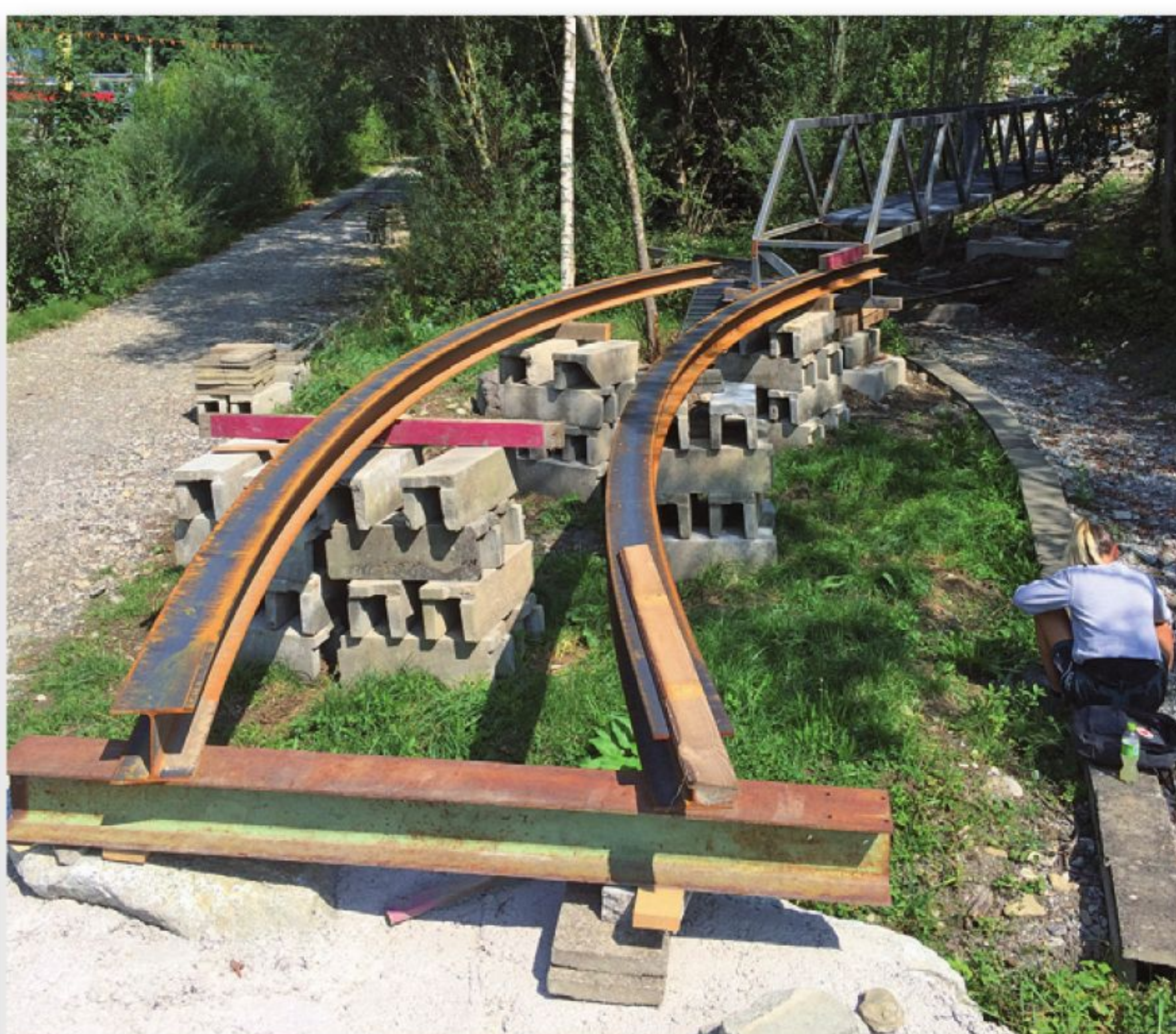
Der Aufbau der 32 m langen Stahlbrücke war eine Herausforderung, neben Gefälle weist die Brücke zudem eine Kurve auf.
