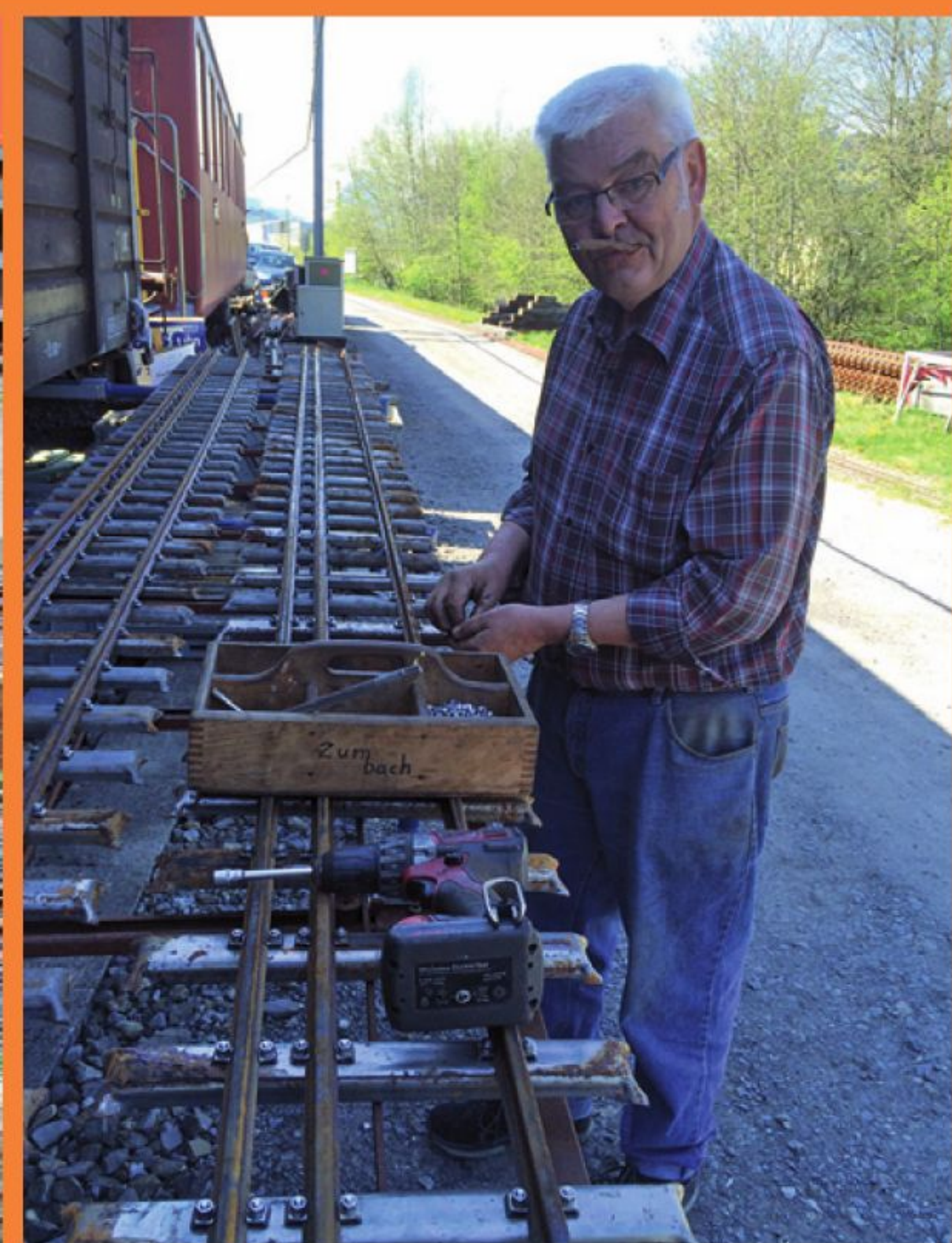
Gleisjoche werden vorbereitet.
