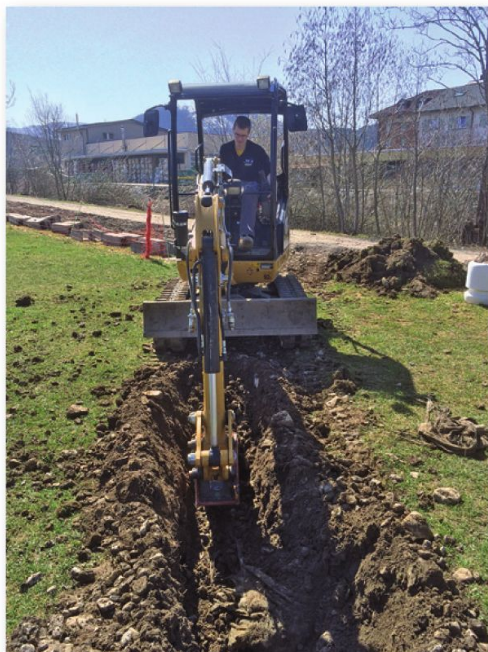
Auch die Erdarbeiten wurden in Eigen- regie durch die Mitglieder ausgeführt.
