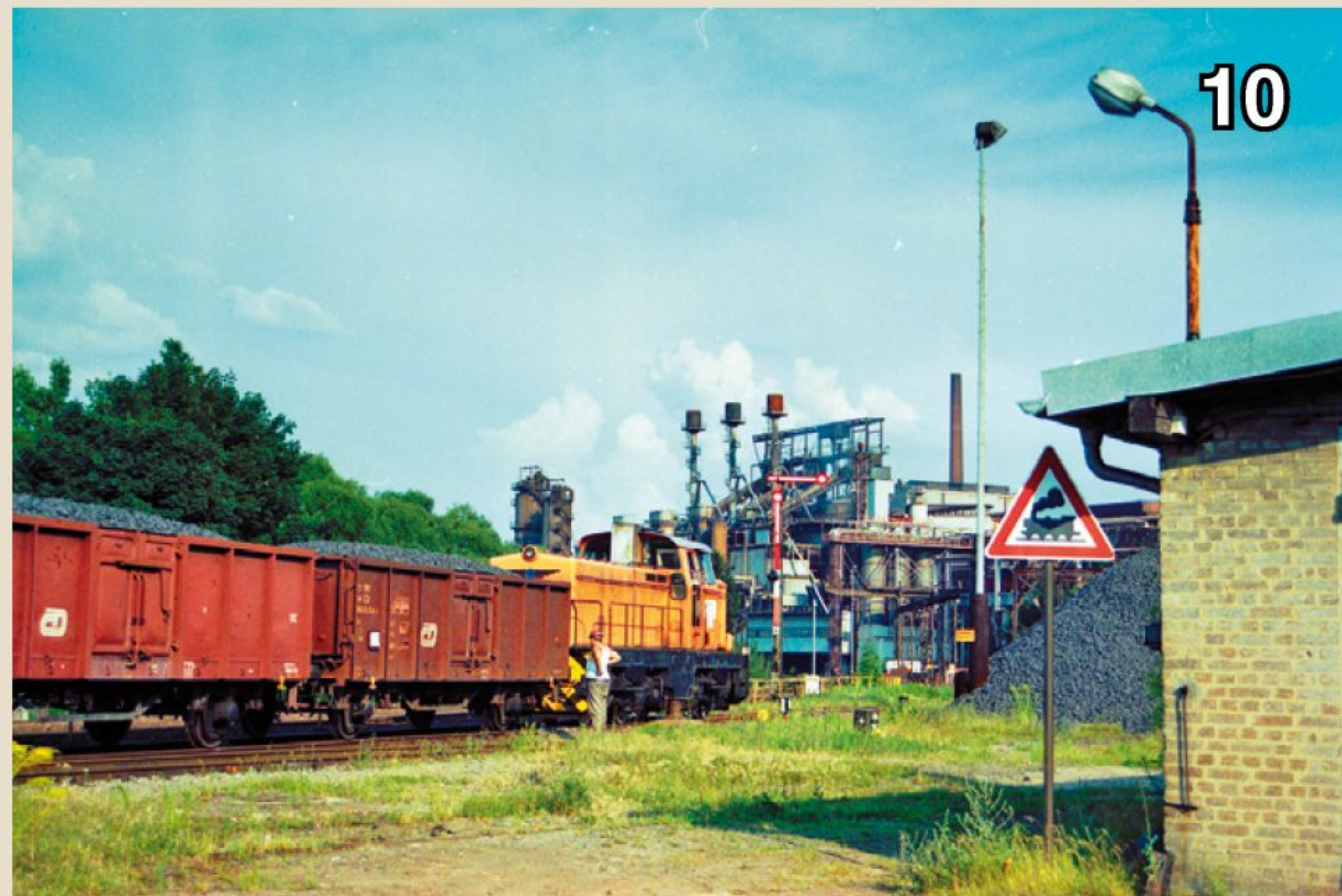
Blick auf das angeschlossene Stahlwerk mit den drei Abgaskaminen der Konverter in Bildmitte. Entladeanlage, Hochofen, Stahlwerk und Walzstraße waren direkt neben der Hauptstrecke Nürnberg-Schwandorf-Furth im Wald aufgereiht. Für den umfangreichen Werksverkehr unterhielt man einen eigenen Fahrzeugpark.
