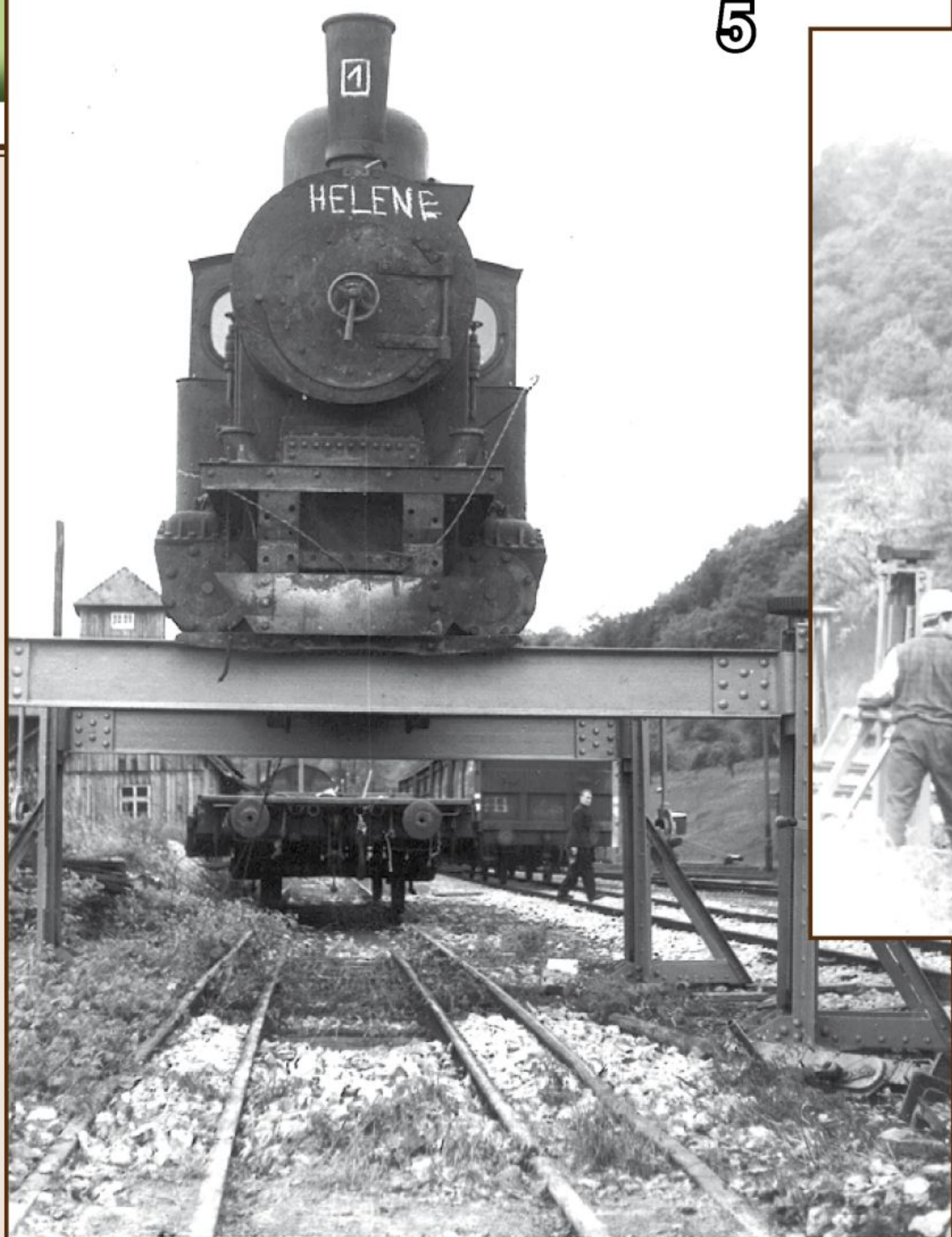
Ein interessantes Zeitdokument, wie 1970 eine kleine Schmalspurlok vom Harz ins Jagsttal transportiert wurde! Nicht wie heute auf der Straße, sondern auf einem Kbs fest verzurrt und dann auf DB-Gleisen ging's zum neuen Bestimmungsort Möckmühl. Noch gut ½ Stunde Kurbelei an den vier Hebeböcken, und das Löklein stand auf den Schienen der Jagstalbahn. 23. Mai 1970. Fotos: Theodor Horn, Kriftel.
