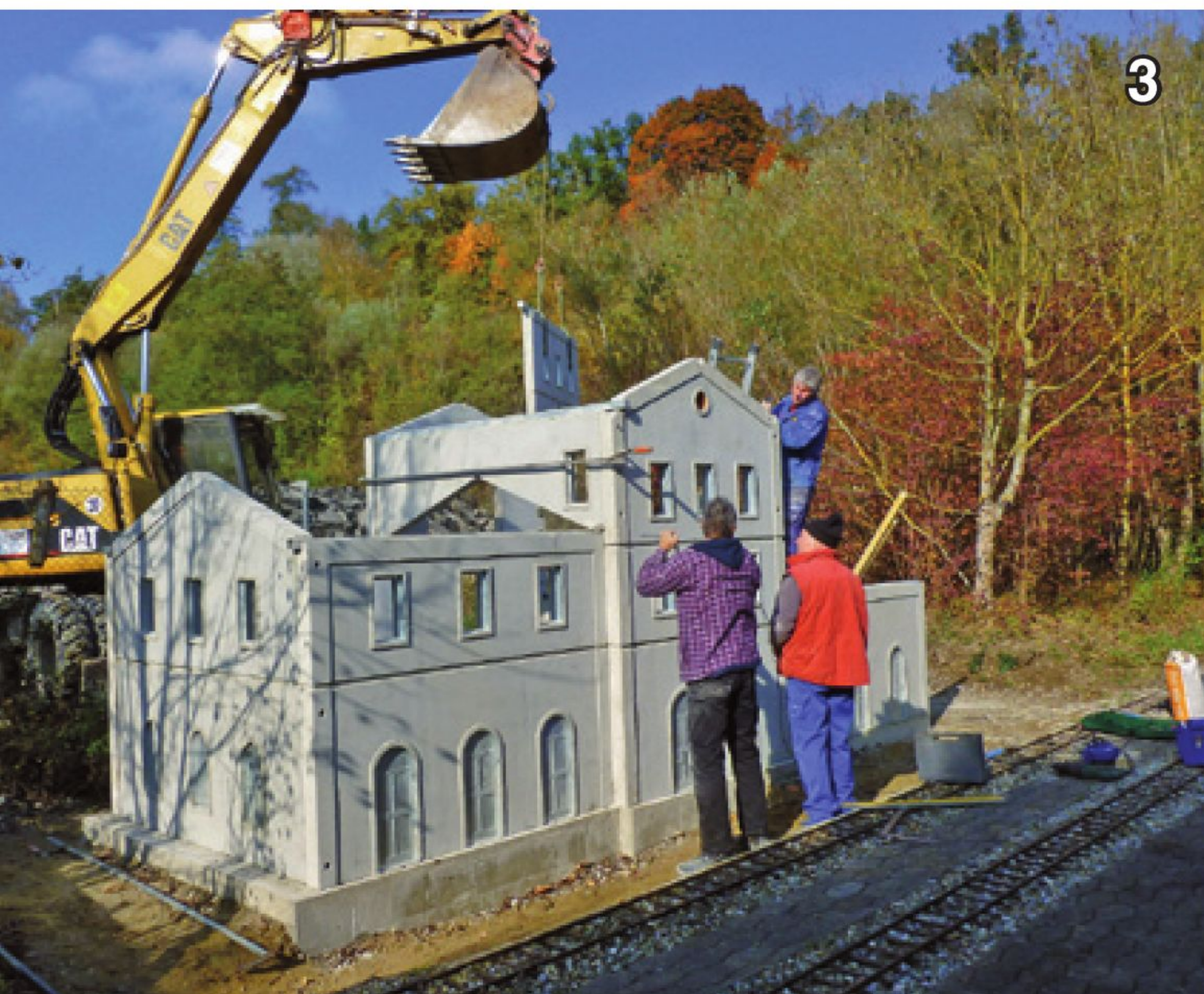
Aufstellen der schweren Betonfertigteile des Bahnhofgebäudes 2011: Oben auf stehend mit Hammer Gerhard Wimmer, sozusagen Technischer Leiter im Verein für alle schweren Bauaufgaben mit Stahl, Beton und Stahlbeton!
