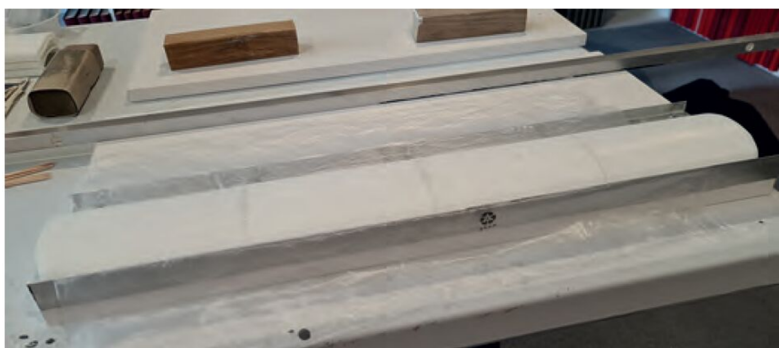
Alle Platten eingesetzt, die Polyethylenfolie wurde über die Dachplatten zurückgeschlagen
