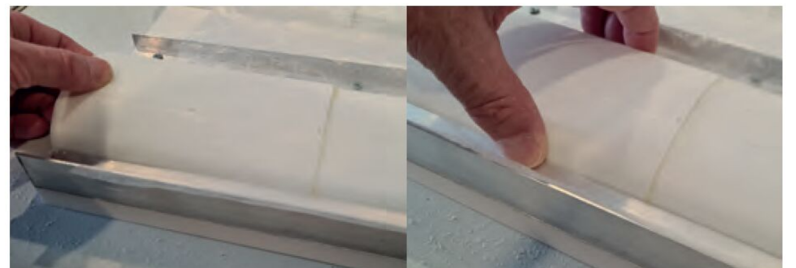
Die Platten werden in die Vorrichtung eingesetzt, wobei darauf zu achten ist, dass sie beim Einsetzen fest an ihren Nachbarn anliegen, um zu verhindern, dass die Polyethylenfolie in die Fuge hineinragt. Durch Zusammendrücken der Platte auf der rechten Seite kann sie zwischen den Winkeln eingeklipst werden. Diese halten dann die Platten fest und richten sie aus.
