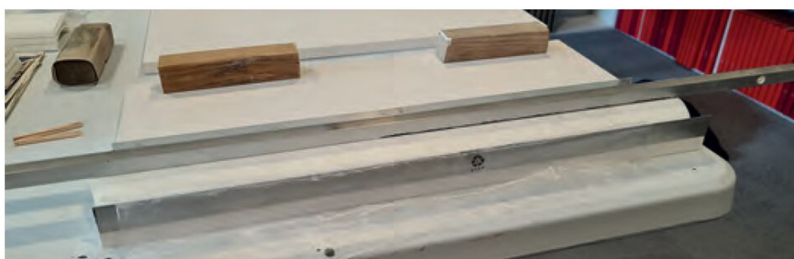
Die Aluminiumrinne wird auf dem Scheitel des Daches angebracht
