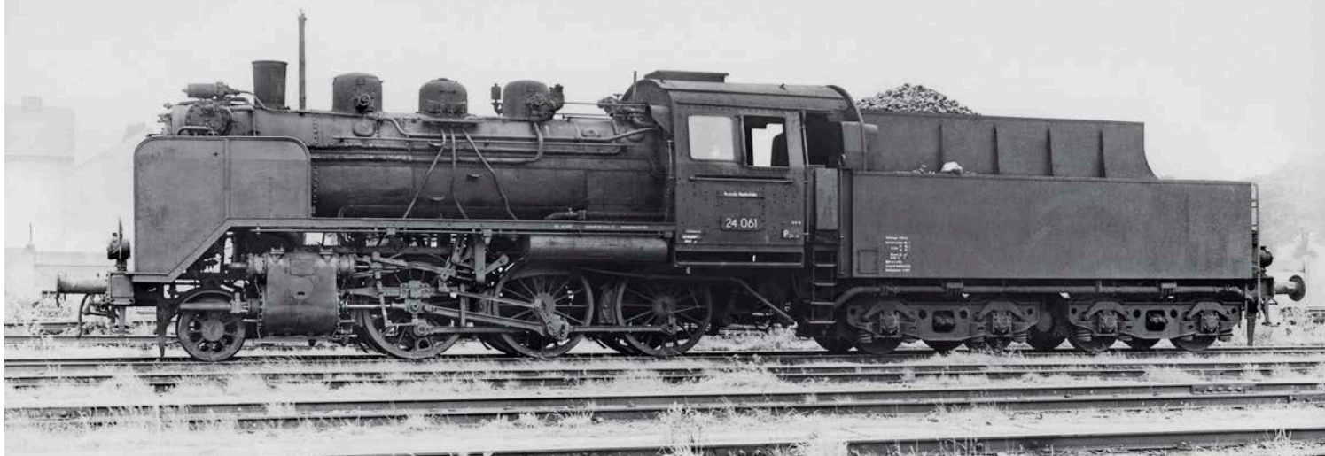
Eine Ausnahmerecheinung war 24 061 des Bw Münster: Im Oktober 1948 hatte sie für Versuchszwecke einen Tender der Baureihe 50 erhalten, mit dem sie fortan im Einsatz war (Foto in Minden 1951) Carl Bellingrodt/Slg. Brinker
