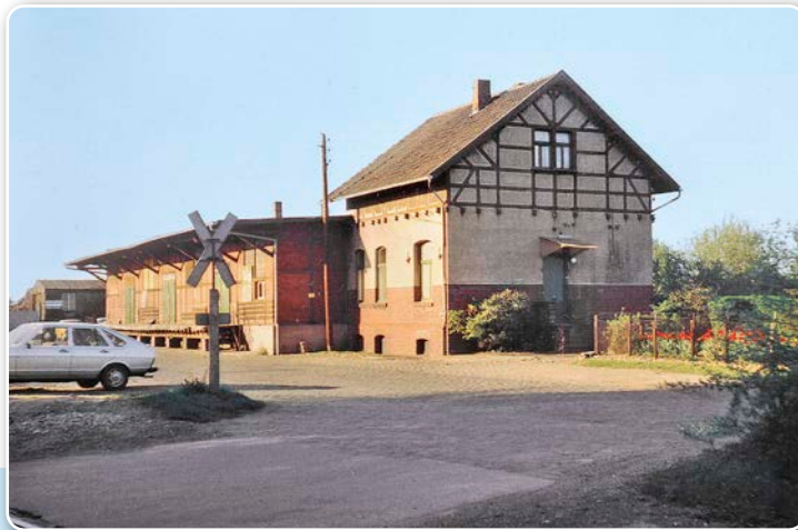
Der Broicher Güterschuppen verfügte rückseitig über einen Gleisanschluss. An der Vorderseite war die Ladestraße mit der Lkw-Rampe angeordnet
