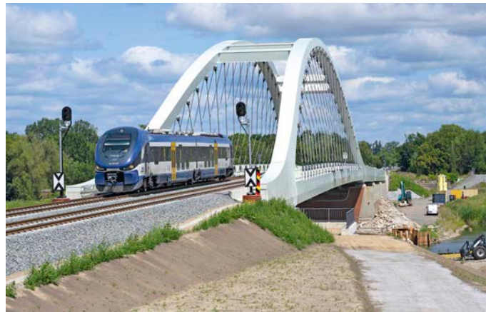
Für die Elektrifizierung vorbereitet ist die Oder-Brücke bei Küstrin. Doch ein Streckenausbau ist derzeit nicht absehbar Bodo Schulz
