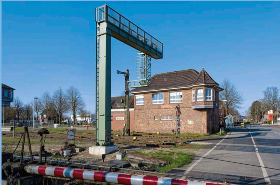
In Niebüll stehen im Frühjahr 2026 bereits die neuen Signalausleger. Diese können später auch eine Oberleitung aufnehmen. Der Bahnübergang wird durch eine Straßenbrücke ersetzt werden Alle Fotos, soweit nicht anders vermerkt, Christoph Grimm
