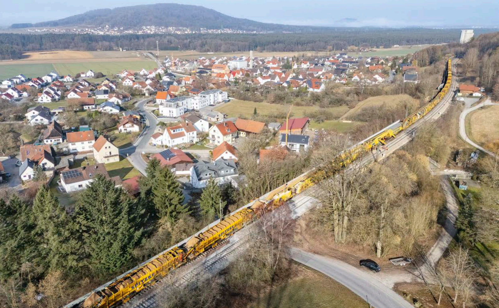
Im Rahmen der Generalsanierung der Strecke Nürnberg – Regensburg kommt die rund 800 Tonnen schwere und über 200 Meter lange Hochleistungs-Gleisbaumaschine (Typ RPM-RS-900, genannt „Katharina die Große“) zum Einsatz Thomas Kiewning/DB AG
