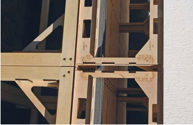
Die Schattenbahnhöfe werden auf dem Unterbau mittels Zapfen, Nuten und Passstücken fixiert
