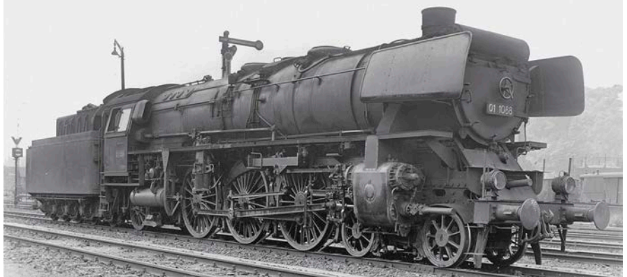
Das zweite Leben der 01 10 : 01 1088 wurde im ersten Halbjahr 1949 bei Henschel „entstromt“
