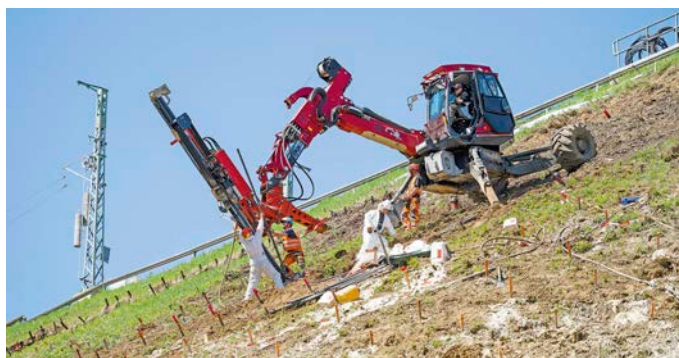
Im Rahmen der Korridorsanierung Nürnberg – Regensburg wird auch der 37 Meter hohe Deininger Damm stabilisiert Uwe Niklas/DB AG
