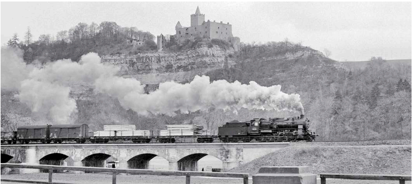
Mit einem Güterzug rollt 58 1835 vom Bahnbetriebswerk Weimar im April 1967 vor der Kulisse der Rudelsburg über den Saaleviadukt – aufgenommen von der parallel verlaufenden Straßenbrücke aus Klaus Winkelmann/Slg. Eisenbahnstiftung
