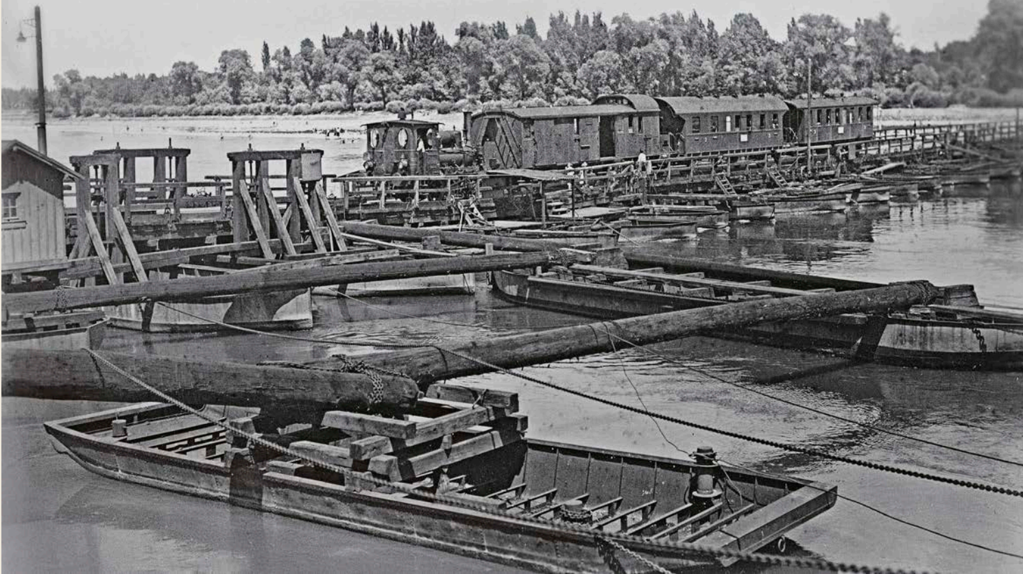
Ein kurzer Zug überquert die Schiffsbrücke Speyer
