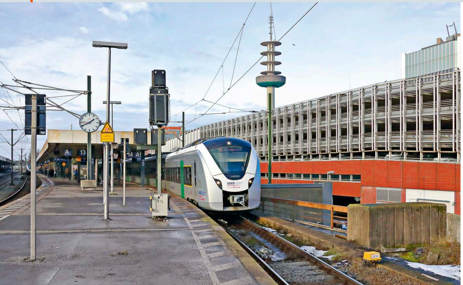
In Hannover Hbf ist am 15. Januar 2026 der S-Bahn-Ersatzzug 1440 829 nach Celle auf Gleis 14 eingefahren. Rechts vom Zug, zwischen Gleis 14 und dem Parkhaus, soll der neue Bahnsteig 15/16 errichtet werden Jürgen Hörstel
