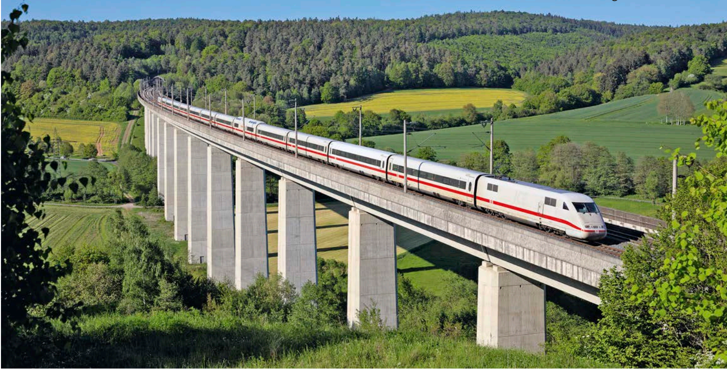
Die Schnellfahrstrecke Hannover – Würzburg zählt seit Jahrzehnten zum natürlichen Habitat des ICE 1. Am 5. Mai 2018 befährt der damals noch 14-teilige Tz 114 „Friedrichshafen“ die 880 Meter lange Aula-Talbrücke bei Niederaula Georg Wagner
