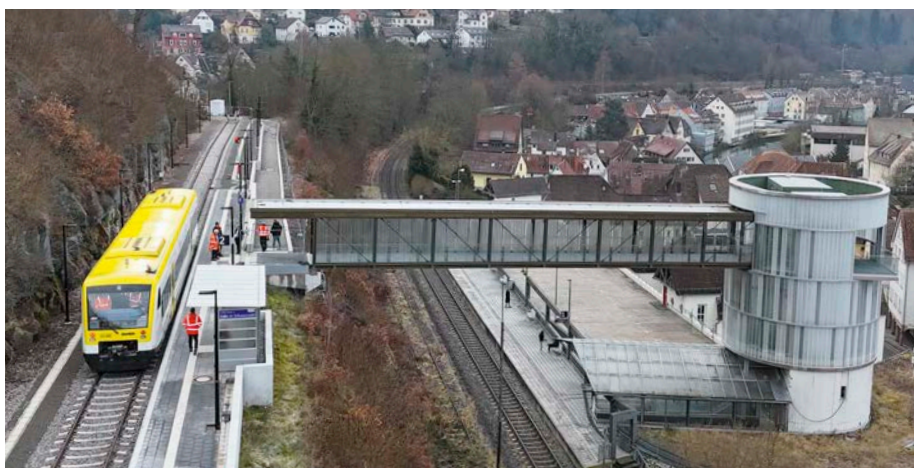
54 Hermann-Hesse-Bahn: Zwischen Calw und Weil der Stadt rollen wieder Züge. Die Reaktivierung war ein Kraftakt für alle Beteiligten Florian Dürr
