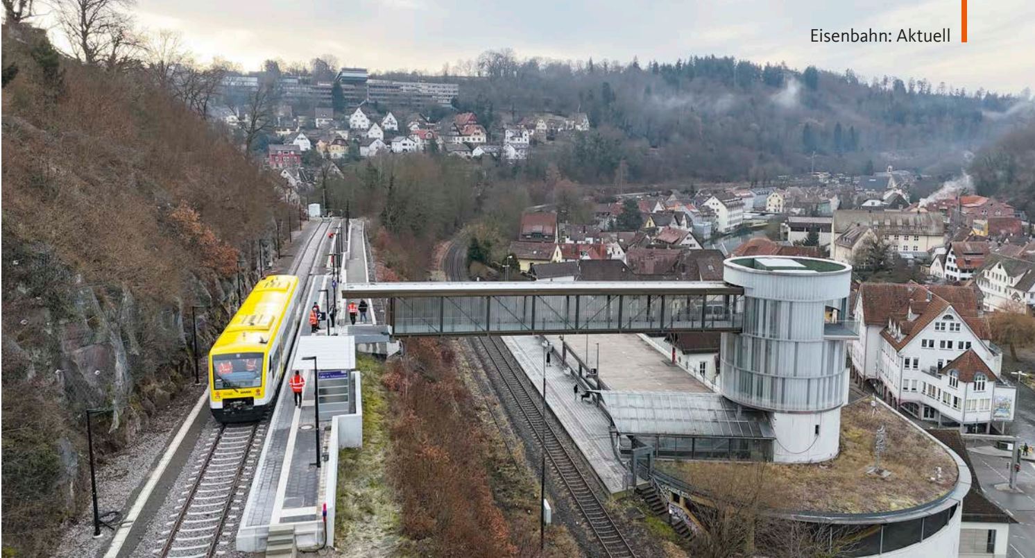
Der Bahnsteig der Hermann-Hesse-Bahn liegt elf Meter über dem Haltepunkt Calw an der Nagoldbahn. Umsteiger müssen Treppe steigen oder den Aufzug nehmen. Im Hintergrund der alte Streckenverlauf bis zum alten Bahnhof Calw Archiv GM
