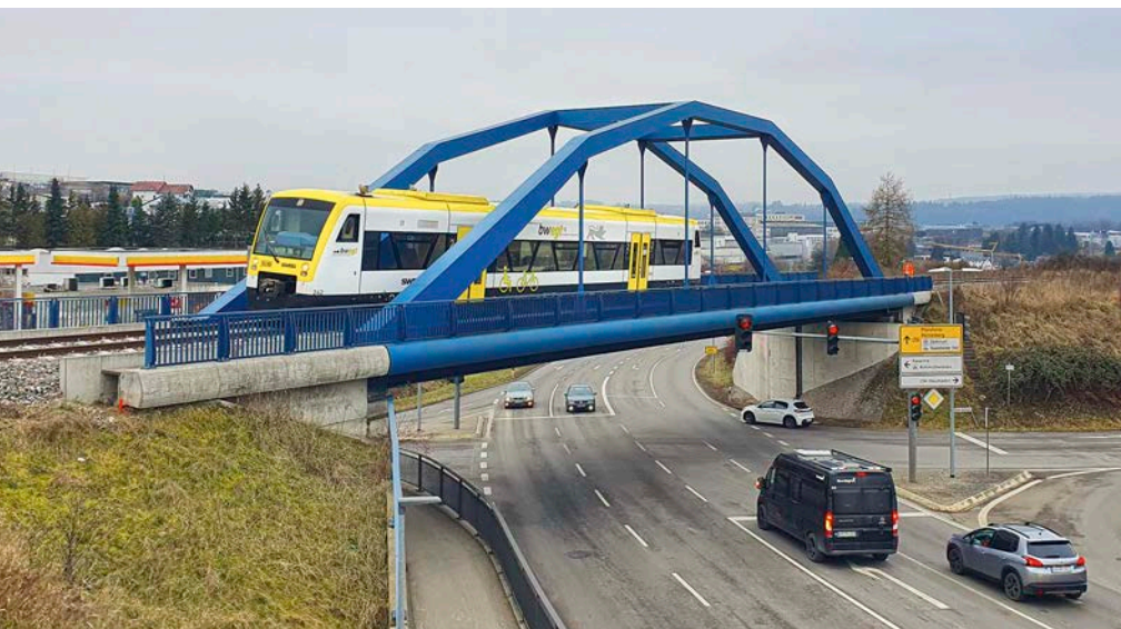
In Calw-Heumaden führt die Hermann-Hesse-Bahn über eine neugebaute Stahlbogenbrücke Frank von Meißner
