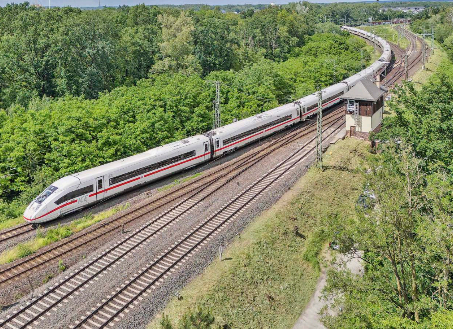
Ein ICE 4-Tz 9483 passiert am 27. Mai 2024 den Abzw Rauschwald in Hanau. Links im Bild ist das Einfahrvorsignal (Formsignal) zum Einfahrsignal des Hanauer Hauptbahnhofs erkennbar Joachim Schmidt
