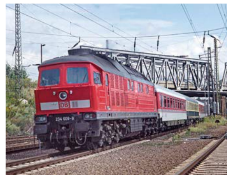
50 Markant überspannt die Hindenburg-Brücke die Westausfahrt in Zwickau Hbf Rainer Heinrich
