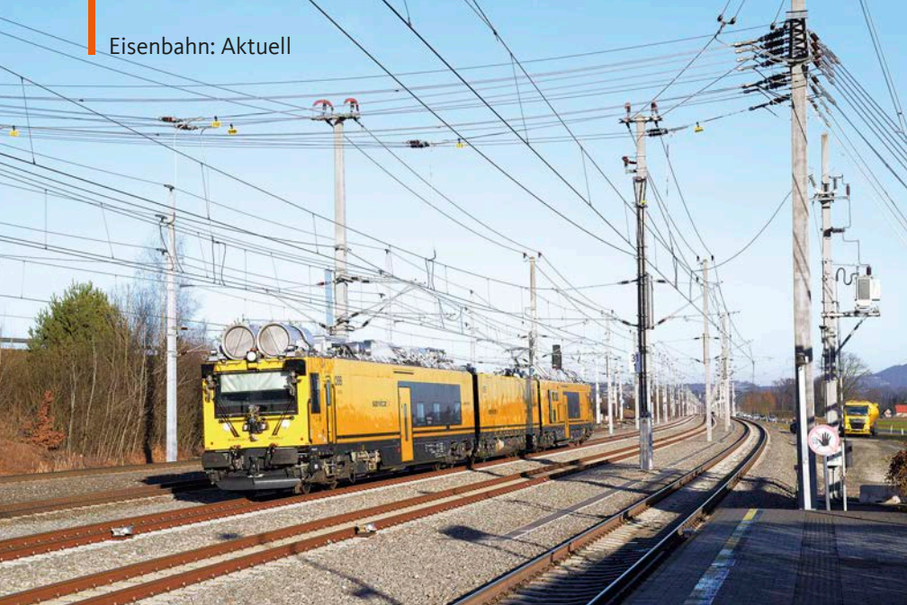
Am 12. Dezember 2025 kam es nach Durchfahrt des Premierenzugs zu einer Rauchentwicklung im Koralmtunnel. Der für solche Fälle bereitstehende Servicejet X122.005 der ÖBB eilt mit hoher Geschwindigkeit durch den Bahnhof Wettmannstätten Markus Inderst
