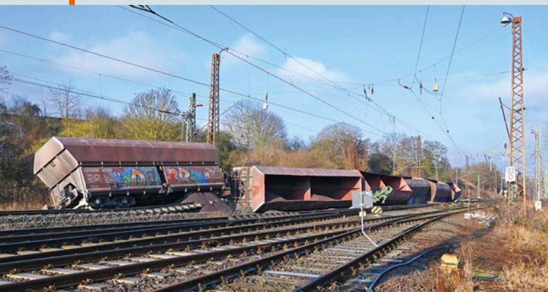
Waggons eines Ganzzugs haben nach einer Entgleisung auf der Nord-Süd-Strecke bei Elze am 23. Dezember 2025 erheblichen Schaden verursacht Volker Wittig
