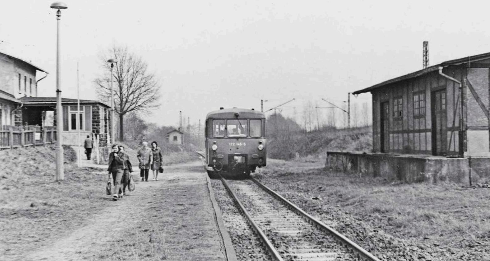
Am 12. April 1979 erreicht 172 145 Brunn. Die Station liegt in unmittelbarer Nähe zur Strecke Leipzig – Hof, deren Verlauf die NG-Linie zwischen Brunn und Neumark folgt
