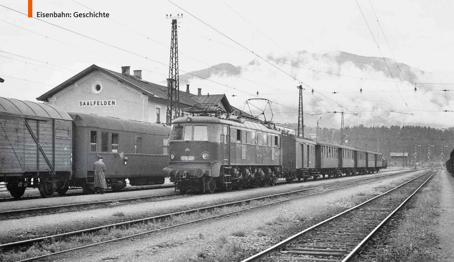
Saalfelden ist der betriebliche Mittelpunkt der Giselabahn. Am 29. Juli 1953 setzt dort 1018.101 am Personenzug P 2521 um Mag. Pharm. Alfred Luft (2)
