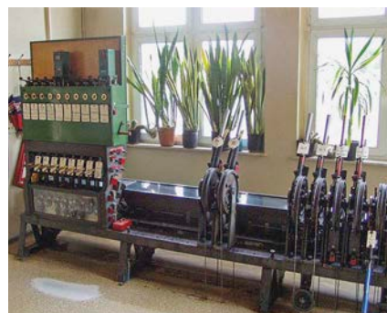
Stellwerk „Kn“ des Bahnhofs Kühnhausen (rechts) und die darin installierte Jüdel-Technik (links)
