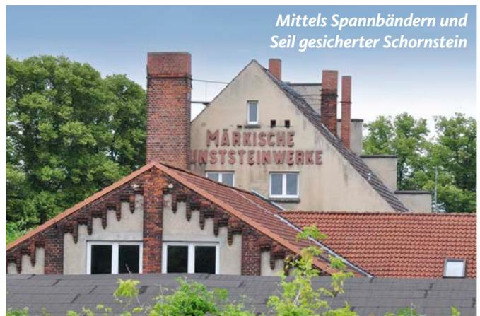
Mittels Spannbändern und Seil gesicherter Schornstein
