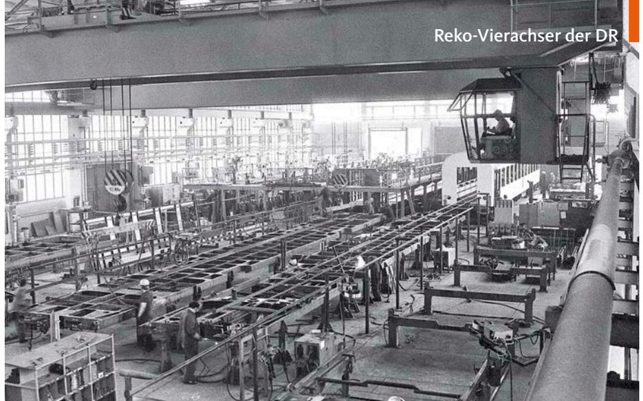
**Blick in die Fertigungshalle des Ausbesserungswerkes Halberstadt mit zahlreichen Rahmen der Wagengattung Bghw und einem im Rohbau befindlichen Komplettfahrzeug rechts im Hintergrund sowie unten der Verschub einer Wagenkarosserie im Freien** Werk/Slg. Dirk Endisch (2)
