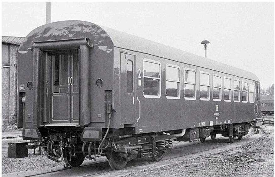
der VES-W Delitzsch erprobt. Technisch unterschied sich das Fahrzeug von den Bghw-Wagen durch die Drehgestelle der Bauart Görlitz VI. Das zweite, im Frühjahr 1970 fertiggestellte, Baumuster der Gattung BDghws besaß schon Drehgestelle der Bauart Görlitz V, mit denen auch die ab 1972 gelieferten Serienfahrzeuge ausgerüstet waren. Bis 1974 wurden im Raw Halberstadt insgesamt 202 kombinierte Sitz-/Gepäckwagen gebaut.
