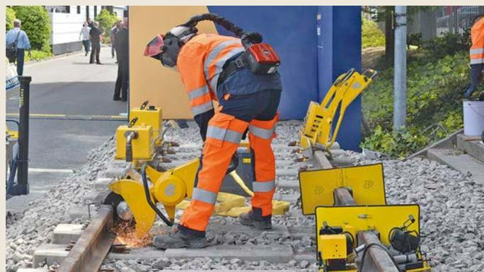
**Die iaf lebt von Vorführungen. Hier wird gerade eine Schiene durchtrennt, damit es anschließend eine Stelle gibt, die geschweißt werden kann**
