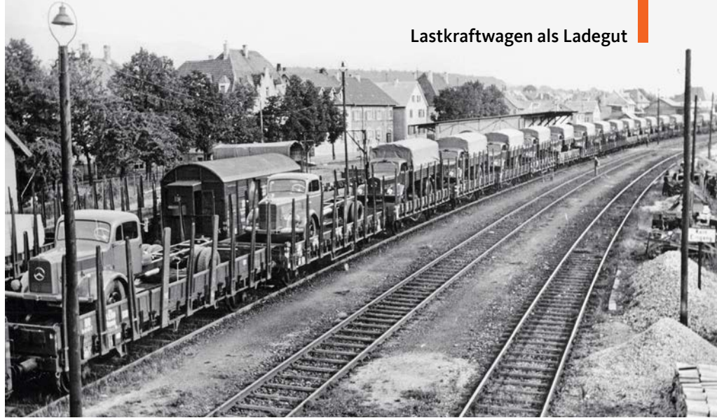
Auf zweiachsigen Rungenwagen verladene Lastkraftwagen des Herstellers Mercedes-Benz, aufgenommen im Oktober 1951 im Netz der Deutschen Bundesbahn Werk/Slg. Benno Wiesmüller (2)
