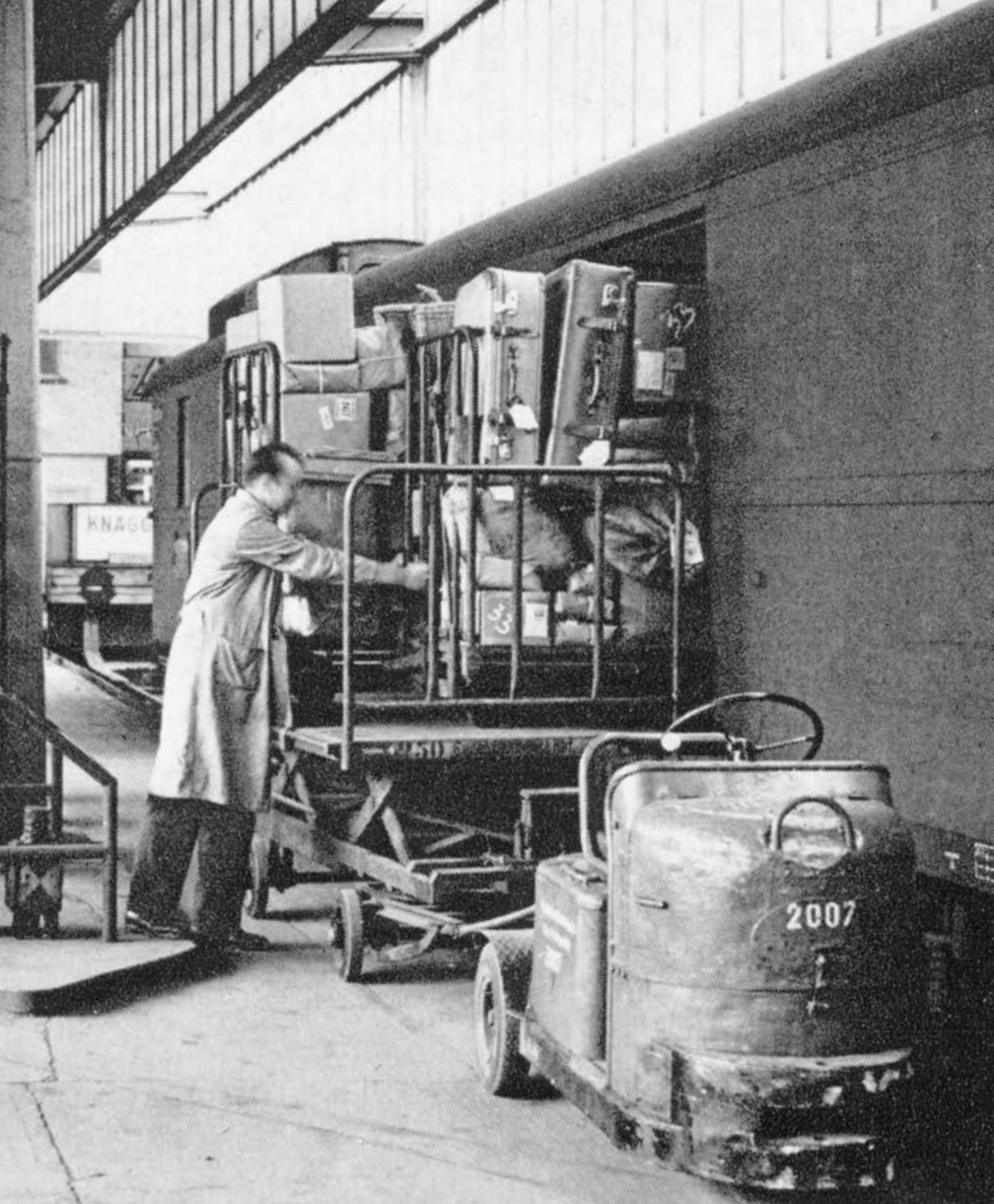
Zwei Beispiele, die die schwere Arbeit des Ladepersonals unterstreichen: oben die Expresgutverladung am Gepäckwagen mit höhenverstellbarem Wagen und Rollladebrett, unten eine Elektrokarre an der Laderampe
