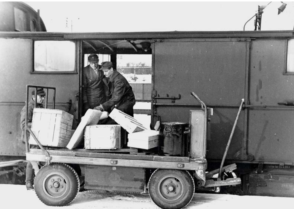
Zwei Beispiele, die die schwere Arbeit des Ladepersonals unterstreichen: oben die Expresgutverladung am Gepäckwagen mit höhenverstellbarem Wagen und Rollladebrett, unten eine Elektrokarre an der Laderampe
