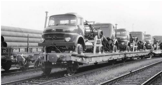
Auf Wagen mit abgesenkten Ladeflächen gesattelt verladene Lastkraftwagen, die mit Böcken, Holzkeilen und Drahtbindungen gesichert sind Paul Scheller
