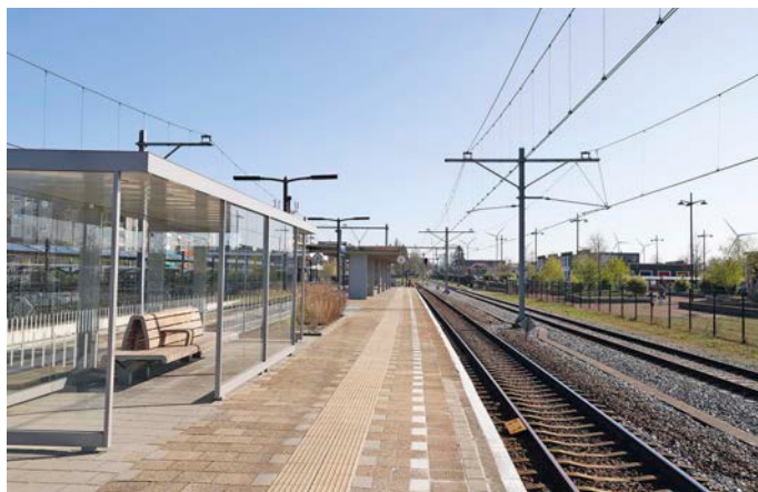
In Coevorden (Foto) soll für Züge nach Neuenhaus ein eigener Bahnsteig entstehen
