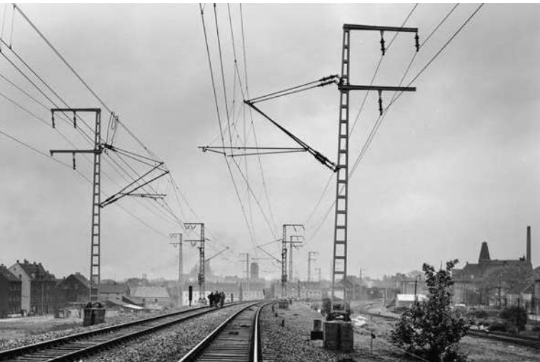
Bei Dortmunderfeld erforderten Bergsenkungen Spezialmasten mit höheren Fundamenten (links). E 10 193 (Bw Frankfurt (M)-Griesheim) passiert um 1966 das Unterwerk Rudersdorf zwischen Siegen und Gießen Willi Marotz/HVB-Pressedienst/Slg. OS (links) / BD Wuppertal/Slg. OS (rechts)
