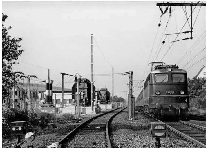
Bei Dortmunderfeld erforderten Bergsenkungen Spezialmasten mit höheren Fundamenten (links). E 10 193 (Bw Frankfurt (M)-Griesheim) passiert um 1966 das Unterwerk Rudersdorf zwischen Siegen und Gießen Willi Marotz/HVB-Pressedienst/Slg. OS (links) / BD Wuppertal/Slg. OS (rechts)
