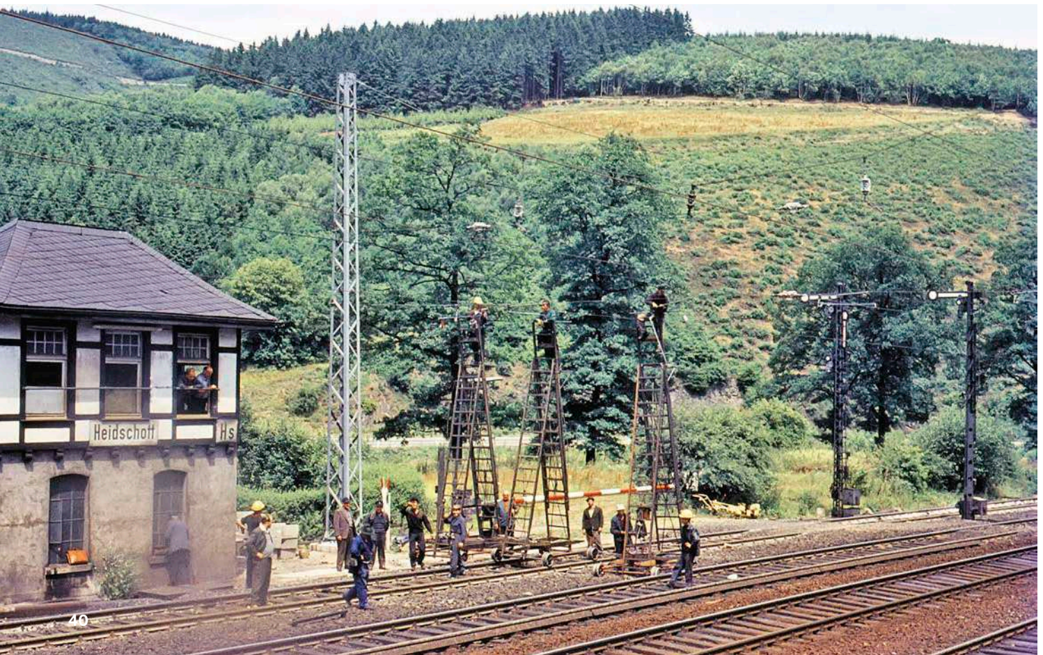
Im Juli 1964 spannen Arbeiter den Fahrdrabt bei der Blockstelle Heidschott zwischen Altenhundem und Welschen Ennest. Die Eröffnung des elektrischen Betriebs auf der Ruhr-Sieg-Strecke fand am 14. Mai 1965 statt Carl Bellingrodt/Eisenbahnstiftung
