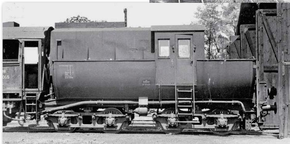
**Ab 1952 setzten die ÖBB auf die Vorzüge von Kabinentendern. Wie beim Prototyp von 1942 nutzte man die vielfach vorhandenen Wannentender der Baureihe 52 als Basis und baute die vergrößerte Kabine fest oberhalb des vorderen Radsatzes des hinteren Tenderdrehgestells ein. Im Juni 1968 ist 52 4552 mit einem Güterzug bei Wien Hetzendorf unterwegs (oben). Die 52 6065 links steht 1966 in Bruck (Leitha)**
