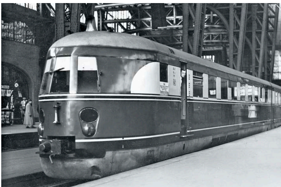
Schnelltriebzug „Bauart Hamburg“ aus der Gruppe 137 149–152 und 224–232. Die Gattungsbezeichnung B6vT ist lesbar! Von „VT“ ist keine Rede
