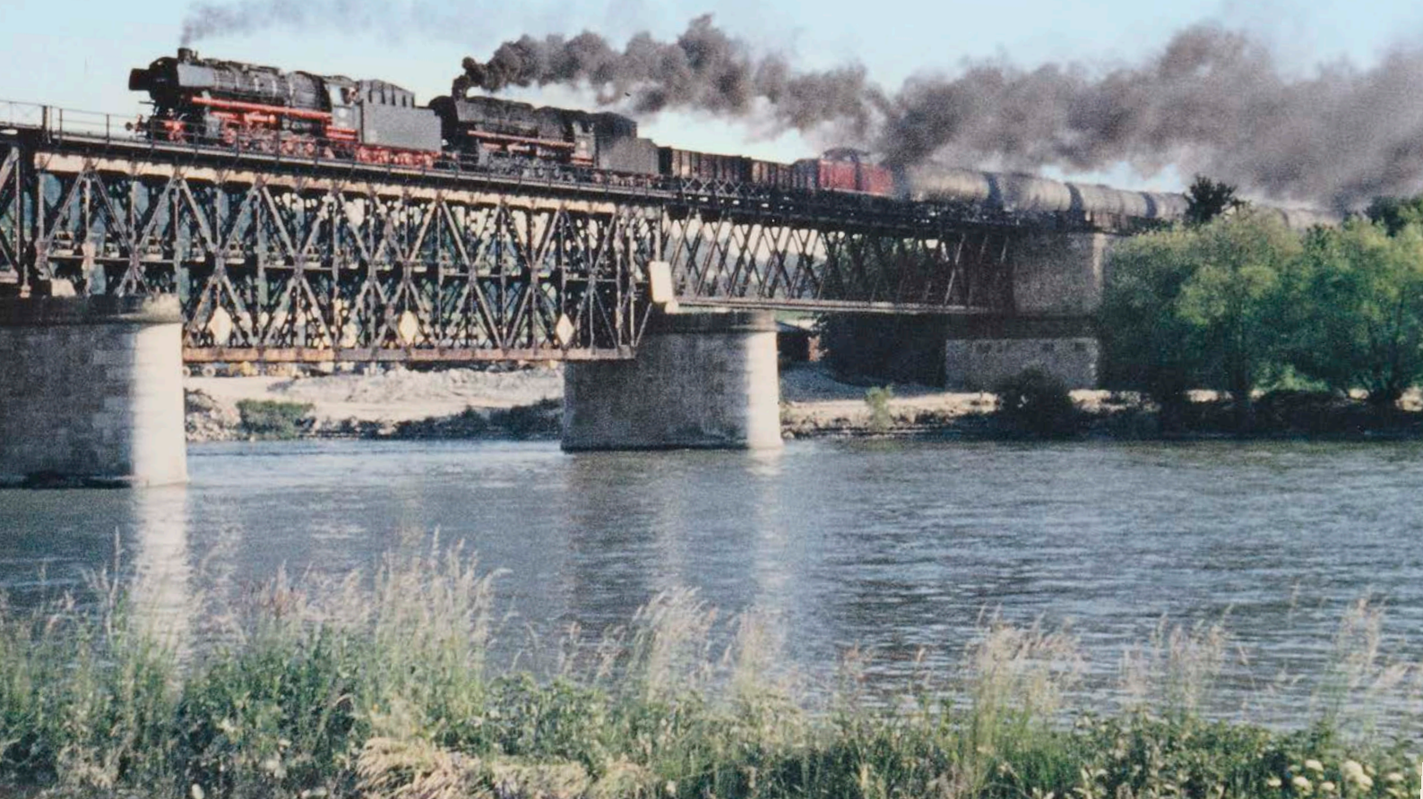
Insgesamt vier Mal quert die Strecke zwischen Neuoffingen und Regensburg die Donau. Die Stahlträgerbrücke bei Poikam befährt am 8. Juni 1976 ein Ölzug, der zur Überführung zweier 44 von Crailsheim nach Regensburg genutzt wird
