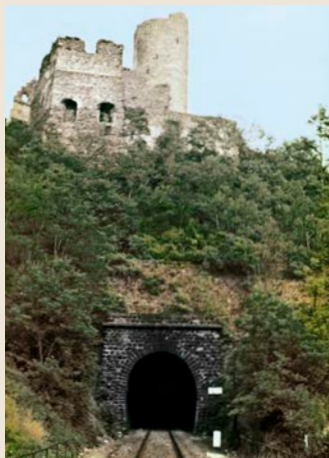
Tunnel der Eifelquerbahn nahe Monreal mit einer modellbahntypischen Burgruine auf dem Bergmassiv
