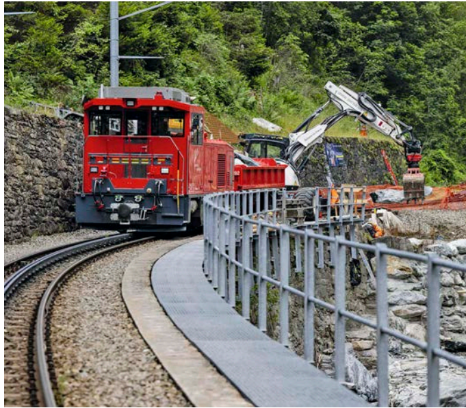
Arbeiter reparieren am 10. Juli 2024 das Gleis der Strecke Visp – Zermatt nach den Unwettern im Oberwallis
