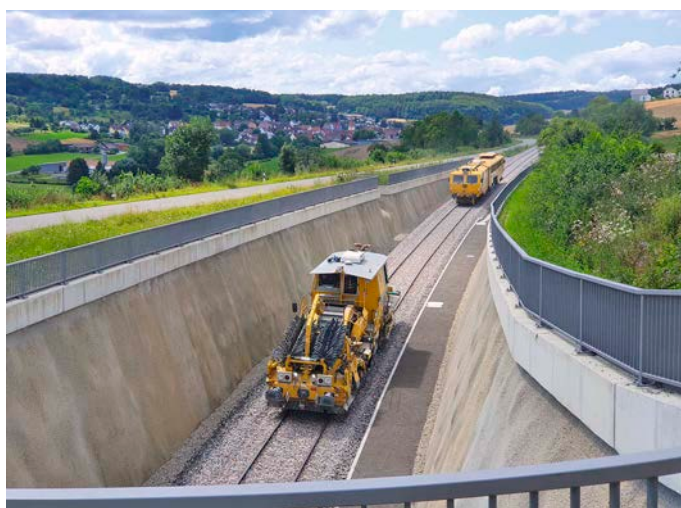
Am 16. Juli 2024 bearbeitete die Gleisstoppmaschine das Baulos 2 zwischen Weil der Stadt und Ostelsheim, hier bei Einfahrt in den „Iris“-Neubautunnel bei Schafhausen
