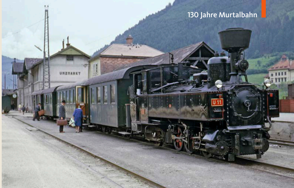
In Unzmarkt haben Reisende der Murtalbahn Anschluss an die Züge Wien – Villach. Die 1894 für die Murtalbahn beschafften C1'-Dampflok (im Bild: U 11) erhielten 1897 – abgeleitet von ihrem ersten Einsatzort Unzmarkt – die Reihenbezeichnung U Will A. Reed/EB-Stiftung
