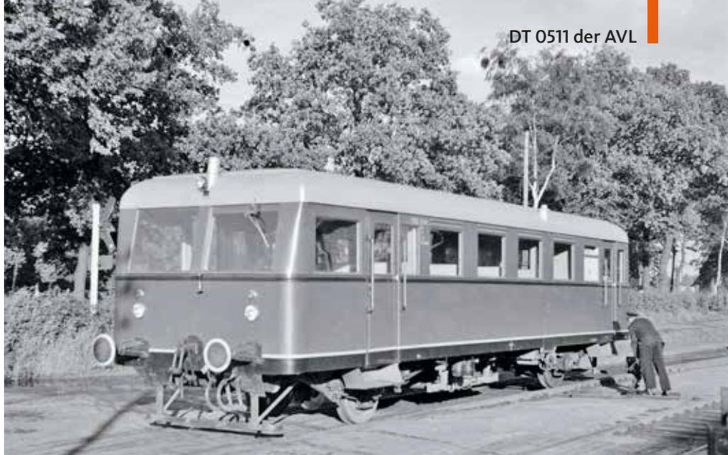
**1958 bis 1960 baute die OHE den DT 0511 umfassend um. Dabei erhielt er unter anderem höhere Achsen und verlor seinen Dachgepäckträger. Wenige Monate nach Abschluss der Arbeiten, am 1. September 1960, zeigt sich der Triebwagen im neuen roten Lack im Bahnhof Winsen an der Luhe**
