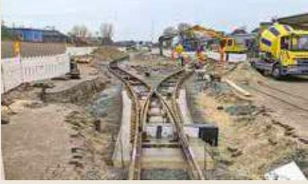
**Borkum Reede: Über zwei Verbindungsweichen auf eigenen Betonfundamenten werden die drei Gleise an der Fischerbalje zusammengeführt. Zwischen den Rillenschienen wird noch Pflaster verlegt**
