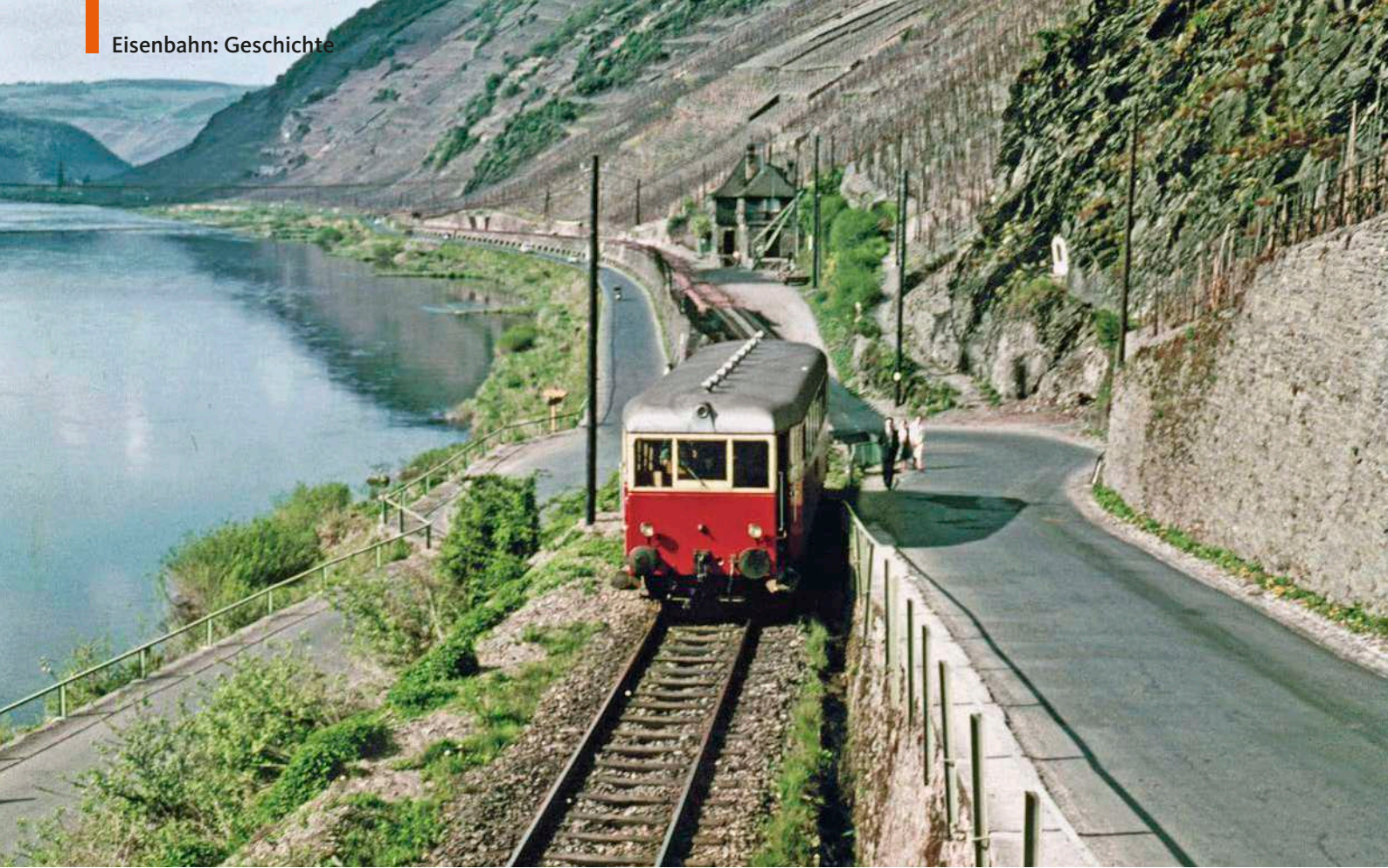
Bahnhof Trittenheim der privaten Moselbahn, April 1957: Die nach rechts abzweigende Straße führt über die Moselbrücke zum Ort Trittenheim, die einst die Fähre ersetzte. Mit dem Derrickkran wurden Weinfässer in offene Güterwagen gehievt de Jongh, Slg. Hans-Dieter Jahr/Eisenbahnstiftung
