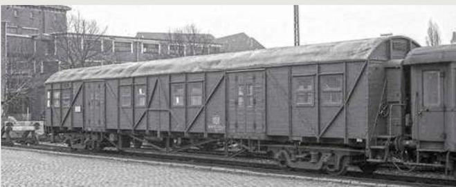
**Ein Behelfspackwagen mit einer verschlissenen Dachdecke aus Segeltuch und Übergängen ohne Gummiwulst, während der Epoche IV als MDyge<sup>986</sup> bezeichnet, steht im März 1971 in Hamburg-Altona auf dem Bereitstellungsleis**
