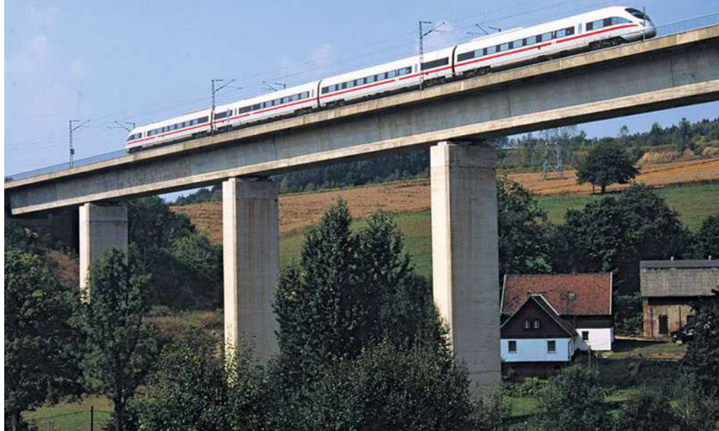
Sieht fast aus wie eine Schnellfahrstrecke: Mit enormem Mitteleinsatz ist die Sachsen-Franken-Magistrale vor der Jahrtausendwende ertüchtigt worden. Im Sommer 2001 überquert ein ICE TD der Baureihe 605 das Neubauviadukt Hetzdorf
