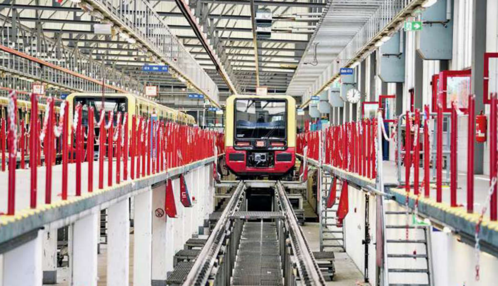
Die Unterhaltung der Baureihen 483/484 findet im S-Bahn-Werk Grünau statt Volker Emersleben
