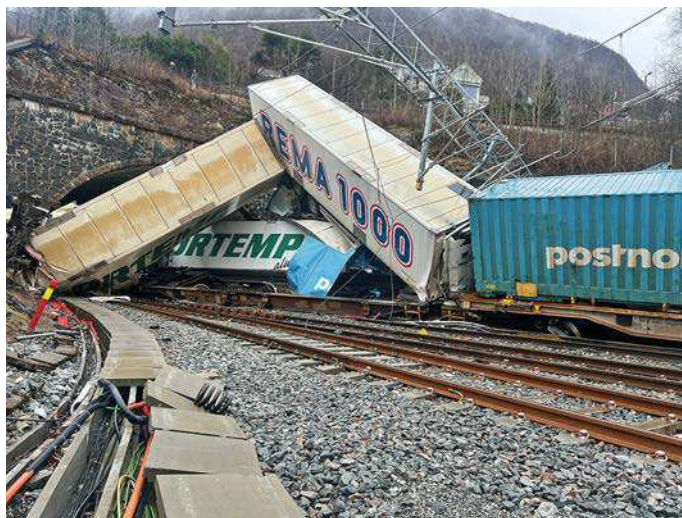
Container türmen sich nach einer Entgleisung bei Arna am 2. April 2024 vor dem Portal des Arnanipa-Tunnels auf
