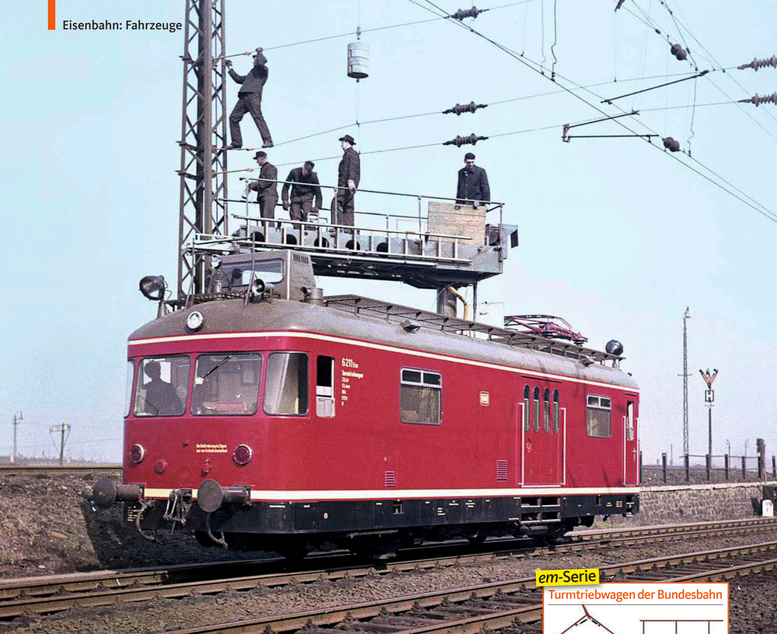
Turmtriebwagen (TVT) 6211 Esn (WMD, Baujahr 1958) ist im Jahr 1965 bei Oberleitungsarbeiten am östlichen Bahnhofskopf von Essen Hbf im Einsatz. Ab 1968 wurden die TVT in die Baureihe 701 umgezeichnet Willi Marotz/Eisenbahnstiftung
