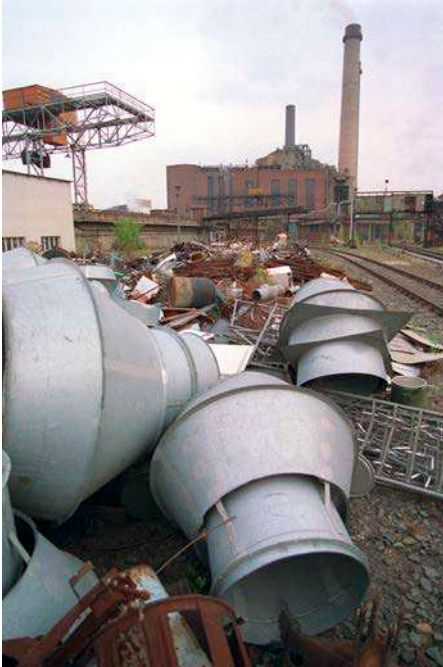
Mit der Wende kam das Ende: Blick auf bereits demontierte Anlagen des Kraftwerks Hirschfelde am 28. Oktober 1992
