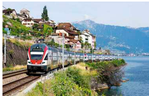
Noch geht es für Züge zwischen Vevey und Lausanne dicht am Genfer See entlang. Der Kanton Waadt plant hier einen Tunnel Florian Dürr
