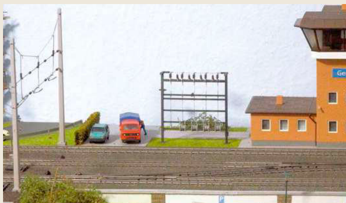
Schaltgerüst zum Trennen von Fahrleitungsabschnitten auf einer in Bau befindlichen ÖBB-HO-Anlage mit noch nicht gespannter Fahrleitung
