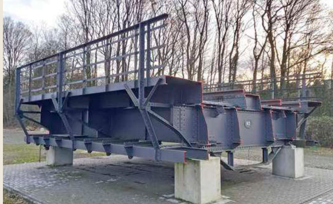
Am Bahnhof Solingen-Schaberg steht dieser ausgebaute Fahrbahn-trog-Torso der Münstener Brücke, sodass man nicht unbedingt kletternd die Konstruktion erkunden muss
