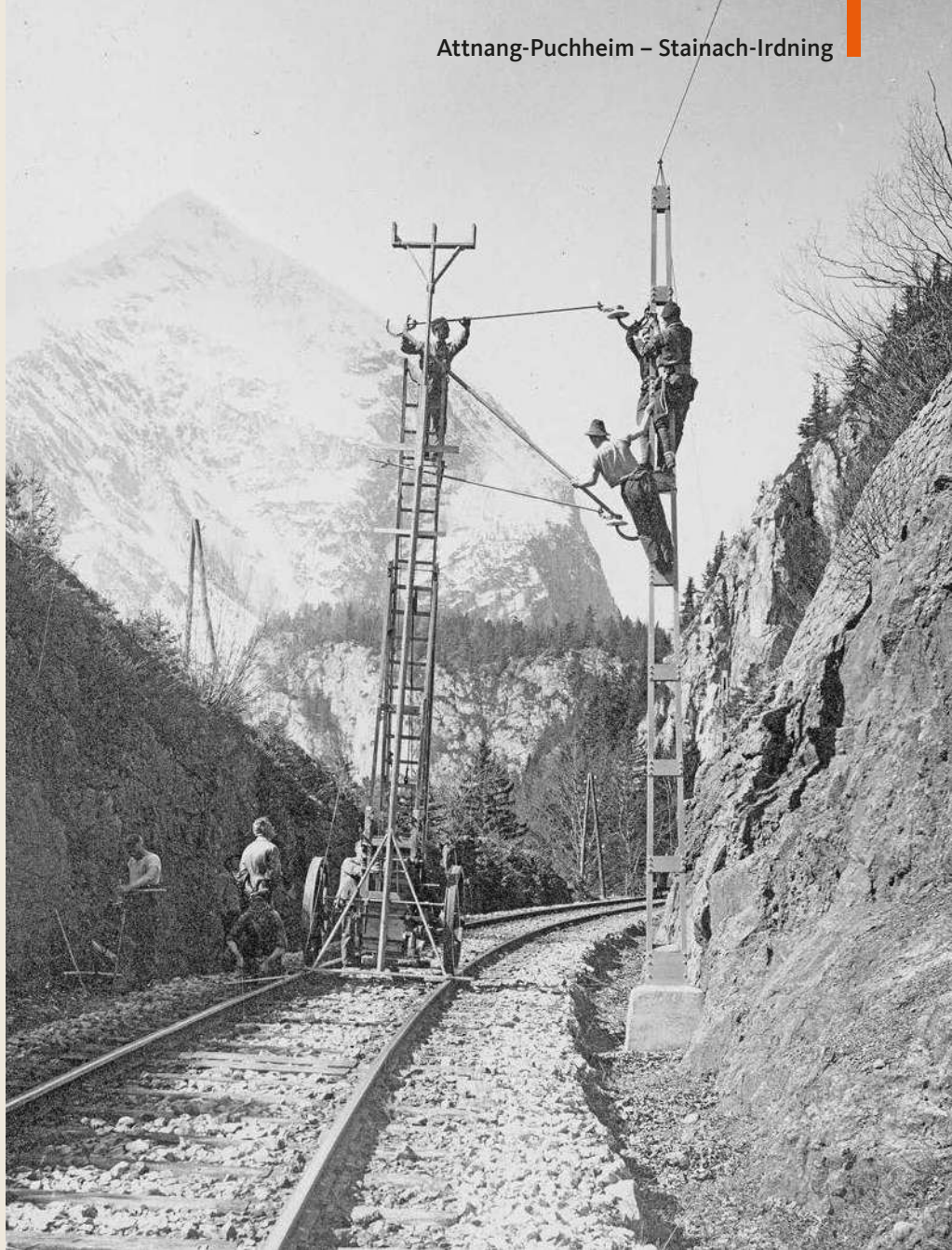
Montage eines Auslegers auf einem Fahrleitungsmast mithilfe einer auf einem speziellen Bahnwagen aufgestellten Leiter nahe Pürgg im Frühjahr 1923. Die neun Bediensteten sind zum Teil akrobatisch gefordert. Im Hintergrund der schneebedeckte Grimming
