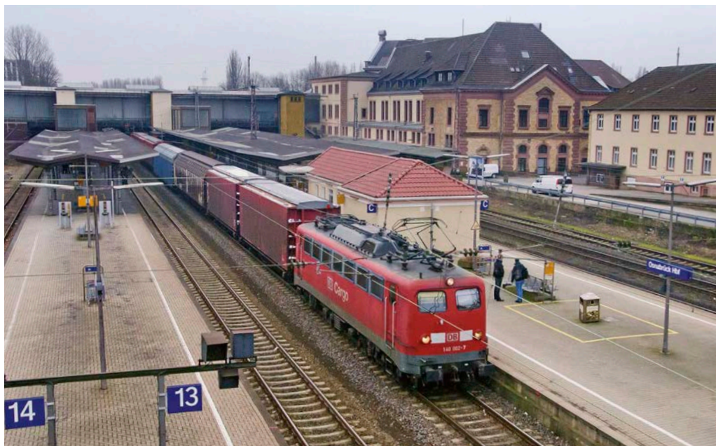
Die Gleise der Strecke Löhne – Rheine führen in Osnabrück Hbf durch den Tiefbahnhof. 140 002, mittlerweile für die PRESS im Einsatz, fährt am 19. Februar 2011 mit einem Güterzug Richtung Rheine, oben verläuft die Rollbahn Wanne-Eickel – Hamburg Joachim Schmidt/EB-Stiftung
