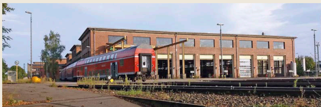
Eine ab 1938 gebaute, 345 Meter lange Wartungshalle diente der DB zuletzt noch für die Reparatur von Reisezugwagen. 2024 wird sie dem Neubau weichen
