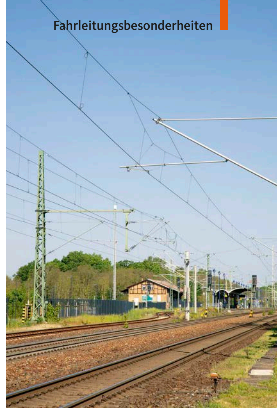
In Unterwerksnähe – hier in Köln-Mülheim – sind diverse 15-kV-Speiseleitungen zur Versorgung der Bahnhofsschaltgruppen und Fahrleitungen an Mastkopf und -schaft befestigt
