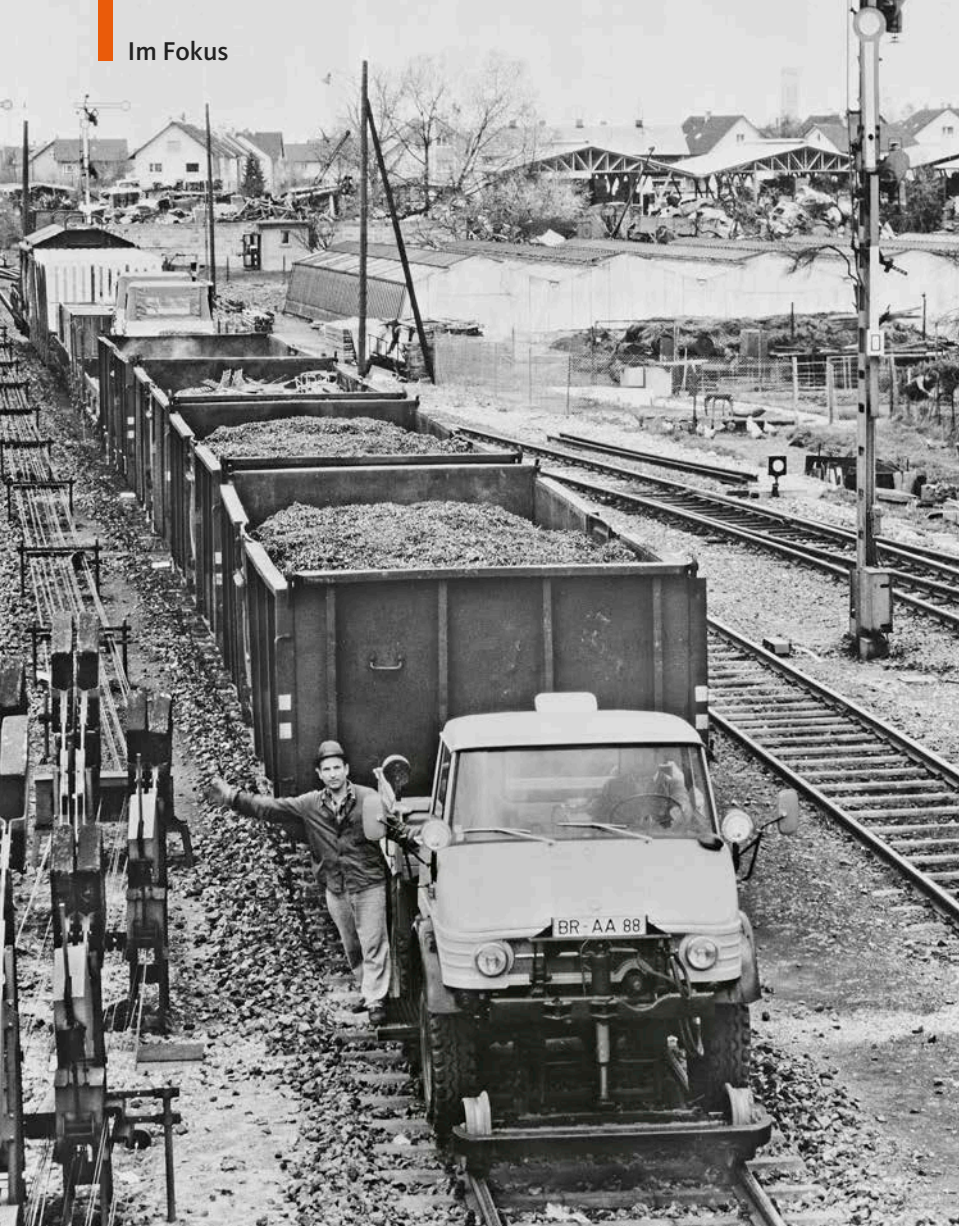
Ausgerüstet mit einer Schienenführungseinrichtung kann der Zweibege-Unimog 406 bis zu 300 Tonnen Waggonlast rangieren
