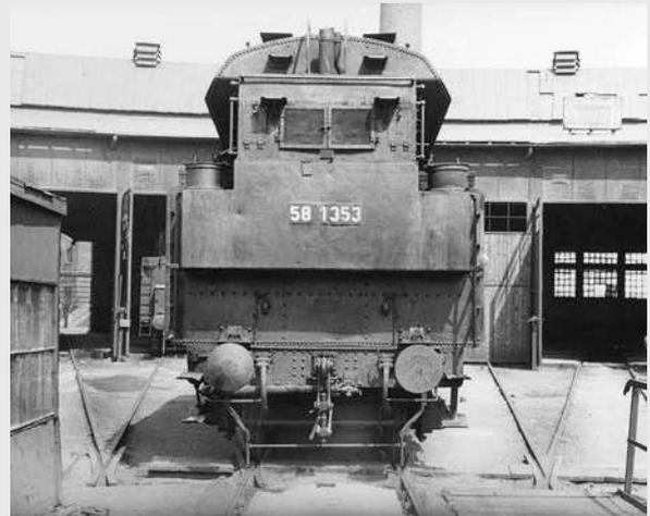
Rückansicht des Tenders der 58 1353 im Bw Halle G mit der Dampfturbine zum Antrieb der Kohlenstaub-Förder-schnecke *Bildstelle Rbd Halle/Slg. Michael U. Kratzsch-Leichsenring*
