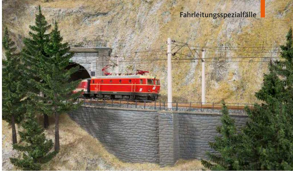
**Oft erhielten vor allem talseitige Stützmauern separate Pfeiler für die Aufnahme von Fahrleitungsmasten, hier beispielhaft beim HO-Modell der Semmeringbahn nachgebaut**
