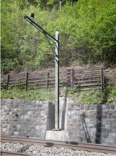
**Beim Vorbild werden Stützmauern zum Setzen von Fahrleitungsmasten oft mit Nischen versehen wie hier an der BLS-Bergstrecke. Auch in Modell sollte diese Option in Erwägung gezogen werden**
